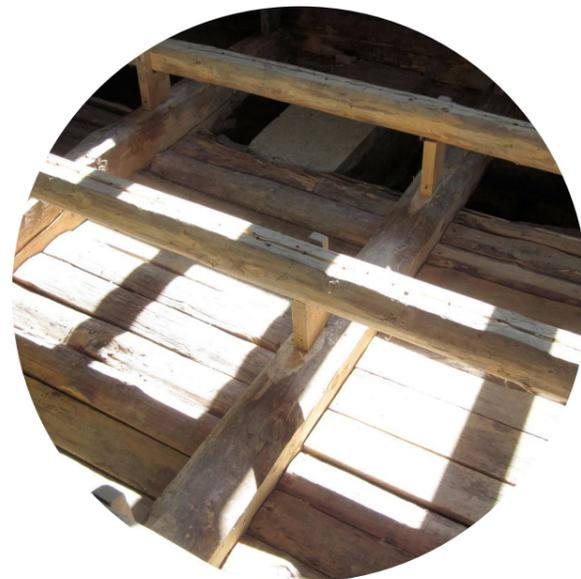
*Stockhuset har en enkel, massiv konstruktion som tål bra förändringar. Det är enkelt att reparera skadorna. Vid reparation bör alltid användas trä. Orsaken till skadan bör elimineras.*
