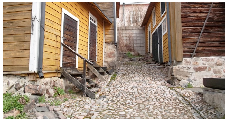
Också nya vattenledningsrännor bör byggas så att kuller- eller storgatstenar läggs i bottnen av rännan. Betongrännor bör inte till gårdskonstruktionerna i gamla stan.
