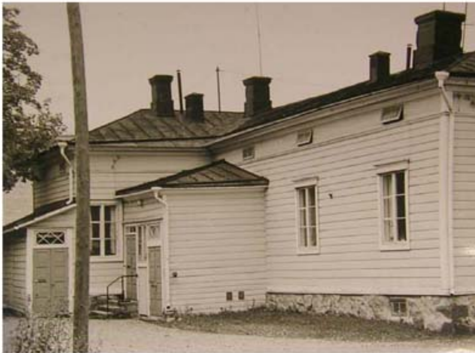
Kuva 1. Talo 3 ennen peruskorjausta (Suurpää, 1975b)
