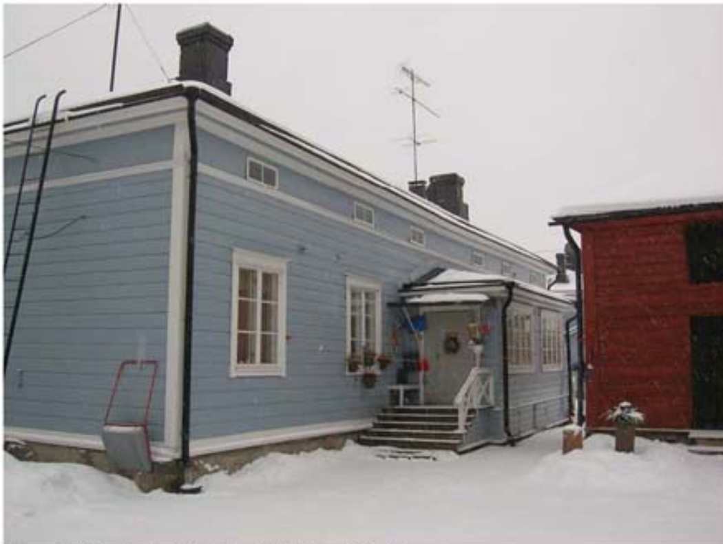
Kuva 2. Talo 2 pihajulkisivu (Räsänen, 2009)
