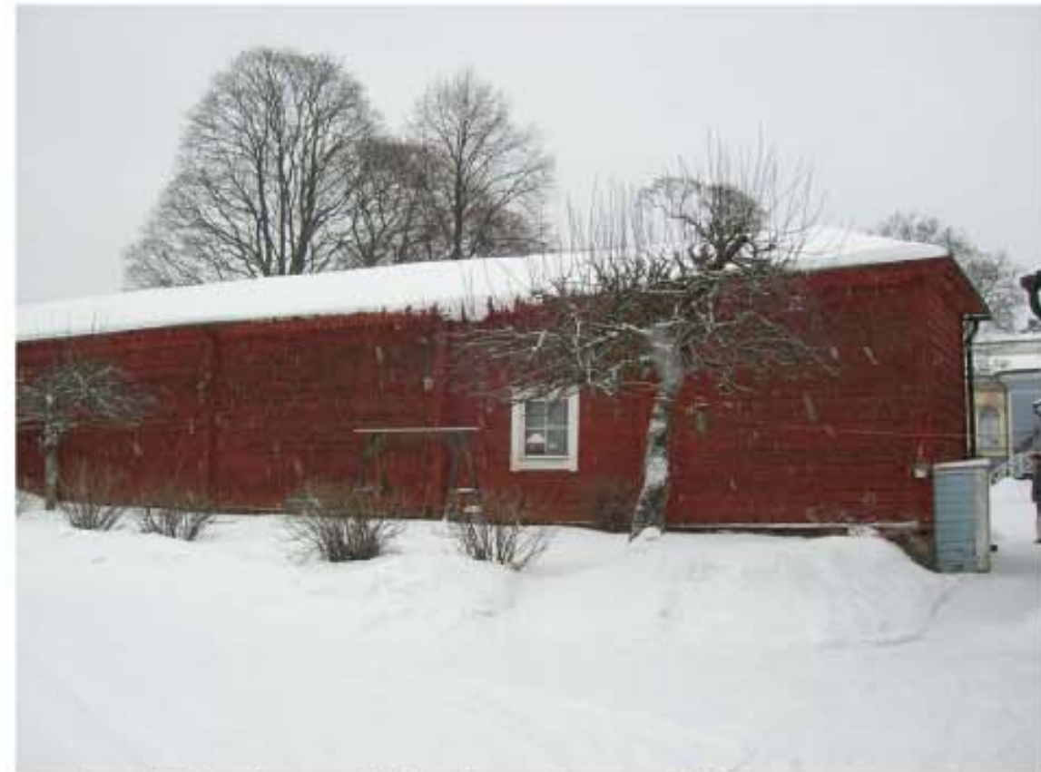
Kuva 3. Ulkorakennus, julkisivu länteen (Räsänen, 2009)
