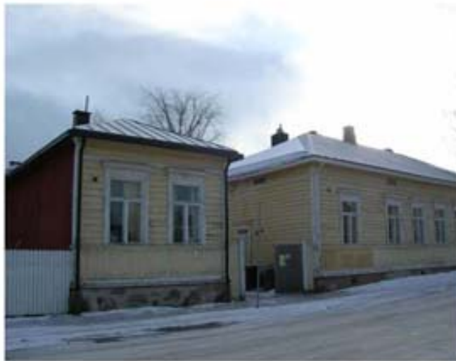
Kuva 2. Tontin 2 rakennukset Runeberginkadulla
