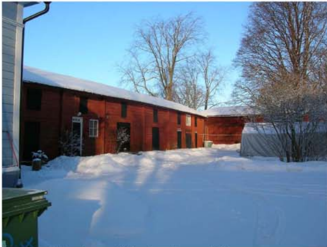
Kuva 2. Ulkorakennus, julkisivu itään (Räsänen, 2009)
