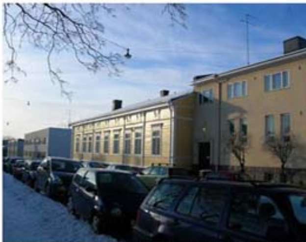
Kuva 2. Rikkoutunutta katutilaa Runeberginkadulla
