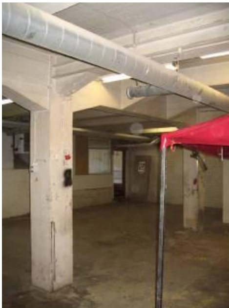
Entisen hevosenkenkätehtaan hokkiosaston (108) betonirakenteet ovat 1940-luvulta. 1920- ja 1930-luvulla tilassa oli vaneritehtaan block-board -osasto. Henrik Wager 2008, Porvoon museo.
