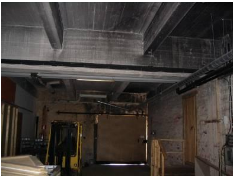
Entisen sorvisalin (101) ja vanerisalin (102) välinen tila on muuttunut. Henrik Wager 2008, Porvoon museo.
