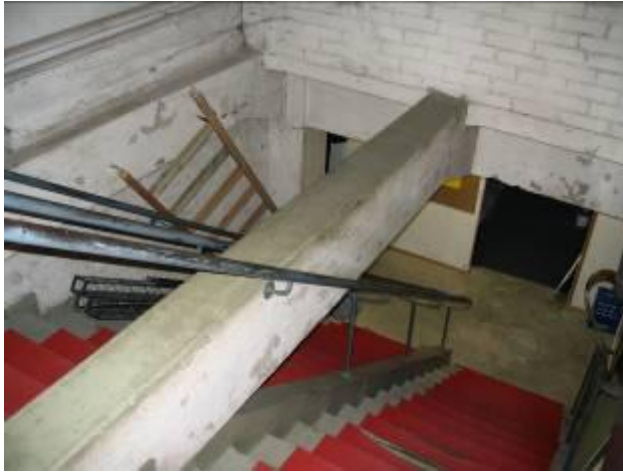
Pohjoissiiven porrasmousu ja sen massiiviset betonirakenteet ovat 1940-luvulta.
