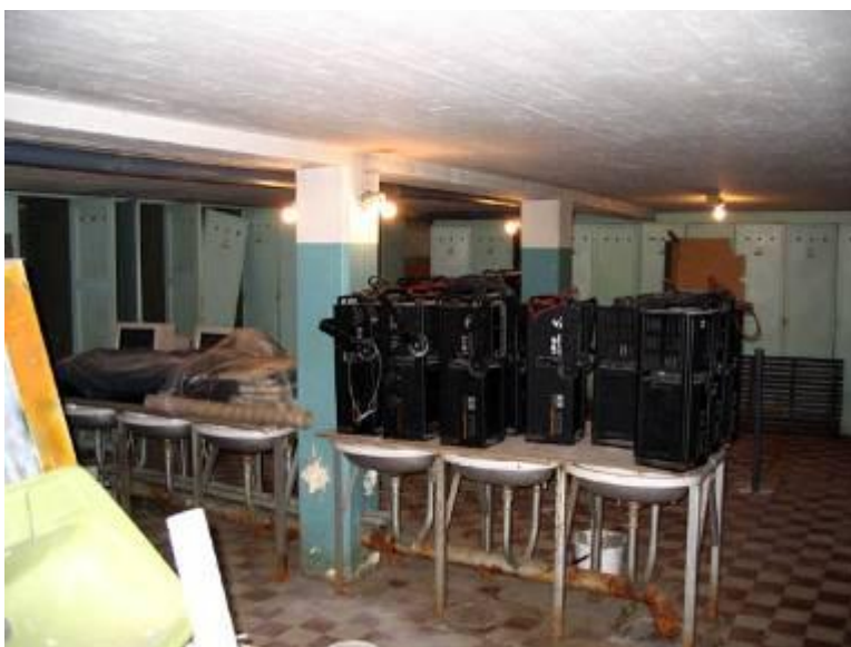
1930-luvun sorvisalin laajennuksen (101b) kellaritilassa oleva entinen pukuhuone. Henrik Wager 2008, Porvoon museo.
