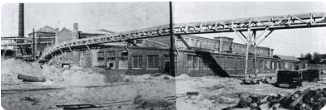
Palon jälkeen korjattu eteläsiiven eteläinen julkisivu vuonna 1937. Hjalmar Lindfors, Teollisuus-Palo, ELKA.
