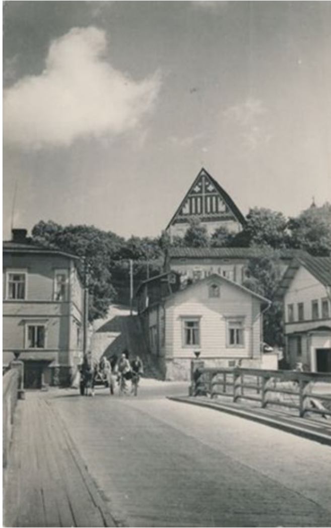
Kuva 17. Tässä 1940- tai 1950-luvulla otetussa kuvassa näkyy sillan kansirakenne. Puukannen päällä on luultavasti ollut jokin kulutuskerros, joka kuvan aikaan on jo poistettu. (Postikortti, lähetetty 1951. Helenius.net.
