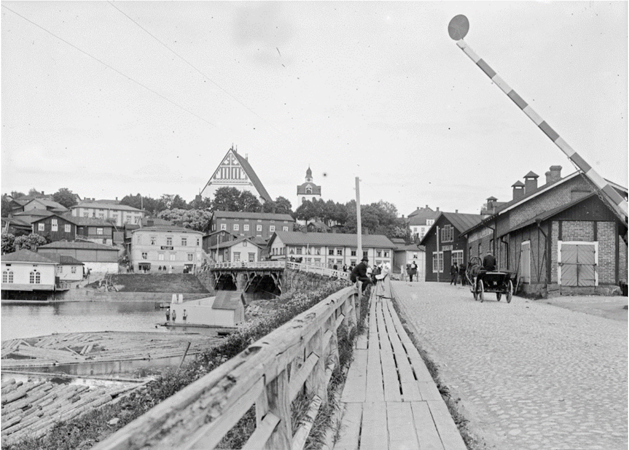
Kuvat 25. Rautatieylikäytävän puomi ja joen rannan teollisuusrakennukset vuosisadan vaihteessa. Kuvassa näkyy myös sillan kaupunginpuoleinen pää sillan pielessä sijainneiden rakennusten purkamisen jälkeen. Toisessa valokuvassa näkyy sillan kansi vähän ennen purkamista vuonna 1951. (Gustav Sandberg, SLS)
