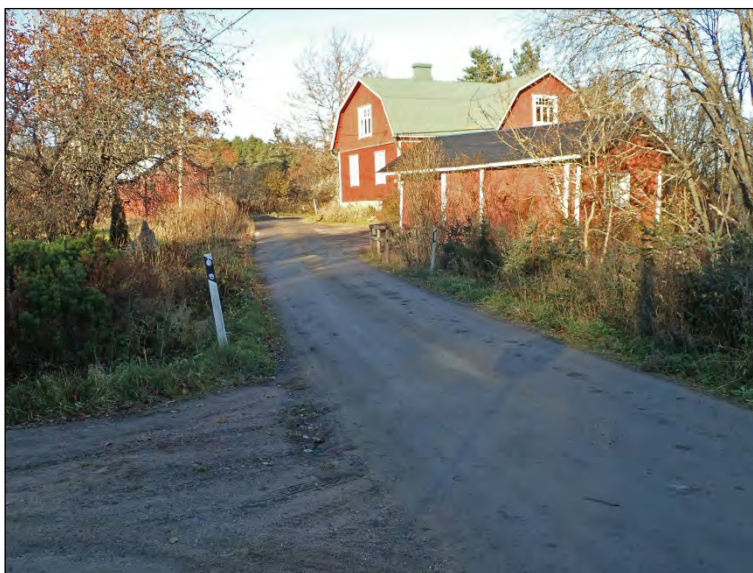
Bäcken löper under vägen mellan de röda byggnaderna på bilden. Tagits mot nordost. Kvarnen har legat i närheten.
