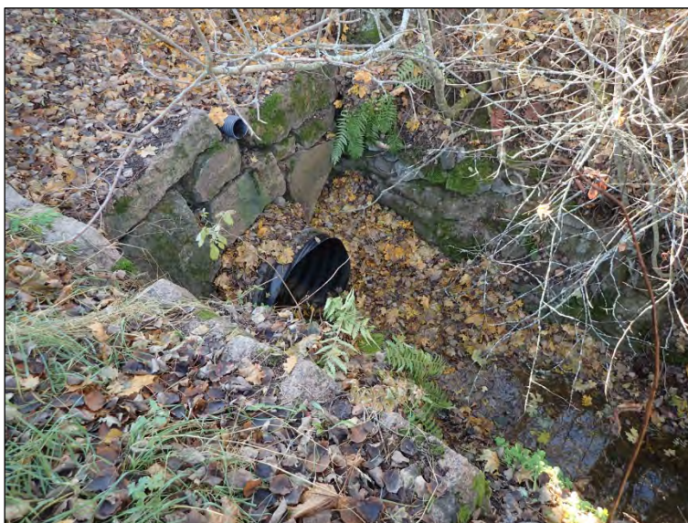
Detalj över bron med plaströret på norra sidan av vägen.
