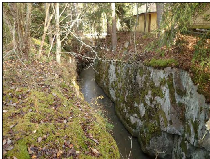
Kallioon räjäytettyä uomaa vanhan myllynpaikan kohdalla. Pohjoiseen.
