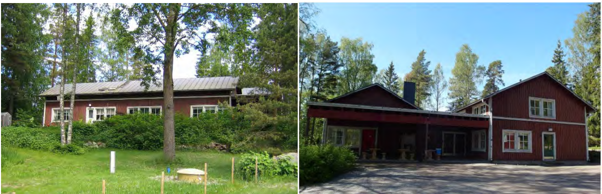
Kuvat 5 ja 6. Leirikeskuksen päärakennus rannan ja sisääntulon suunnalta
