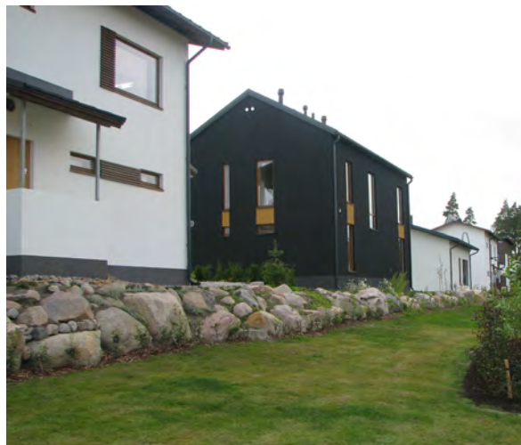
En terrasserad stödmur med yta av skiffersten.
