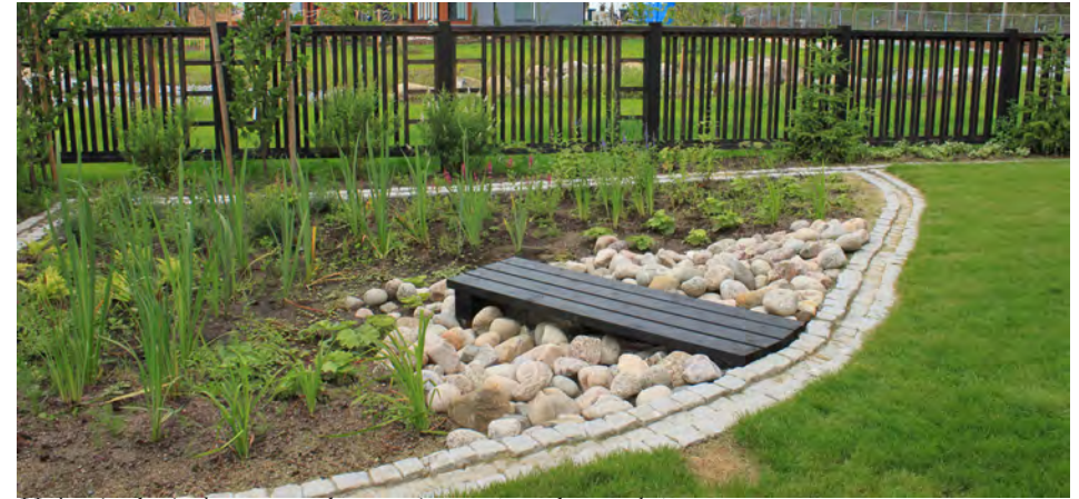
Hulevesien käsittelyä varten rakennettu istutettuja sadepuutarhoja.
