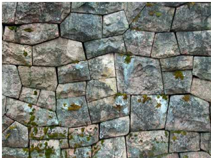
Kuva 3: Esimerkki lohkopintaisesta kivimuurista.
