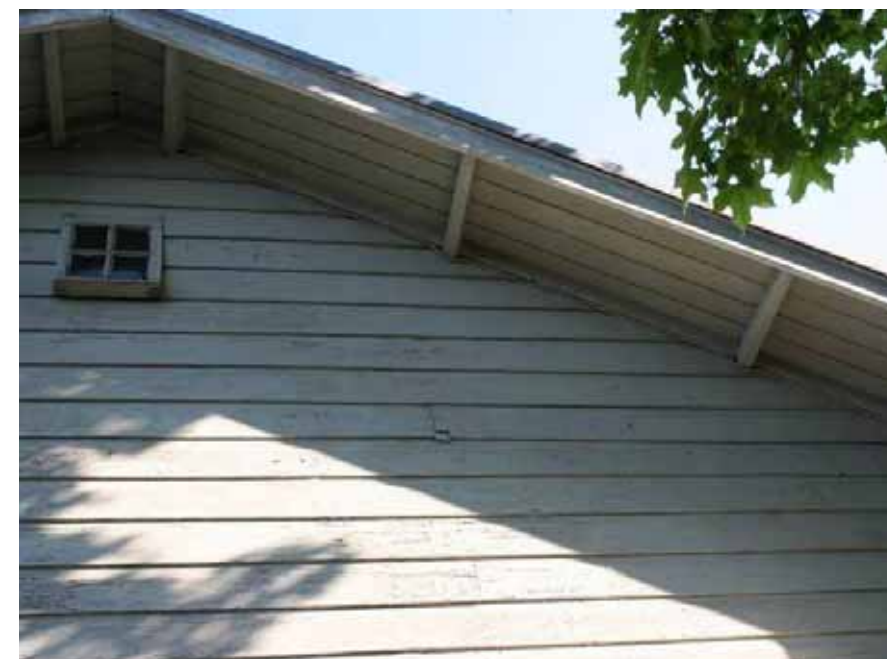
Kuva 4: Esimerkki avoimesta räystäästä.
