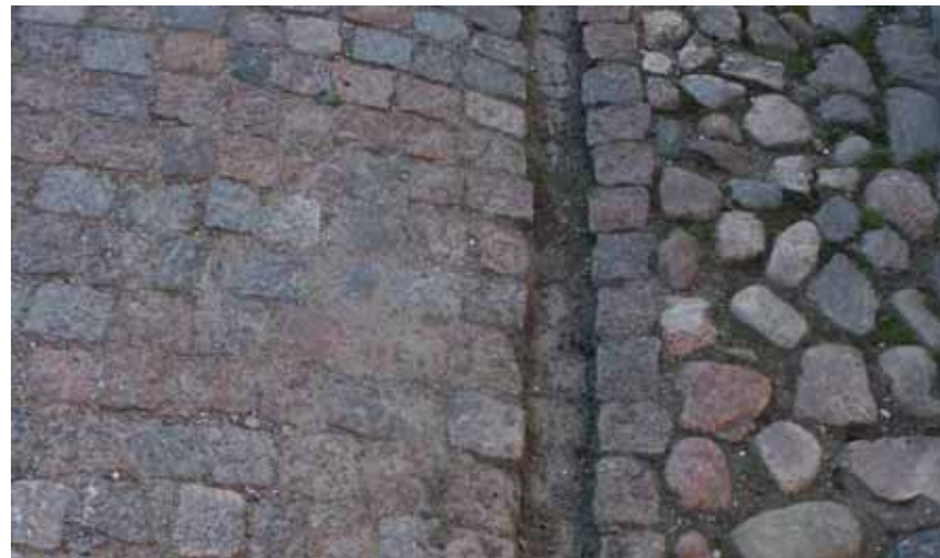
Kuva 42: Esimerkki yksinkertaisesta kivetystä pintavesipainanteesta.
