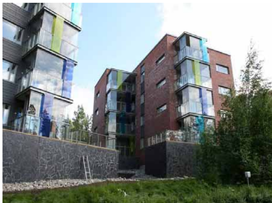
Kuva 5: Maaston tasoero ratkaistu kivimuurein.
