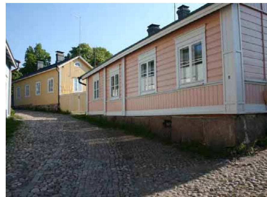
Kuva 6: Sokkelilinja kaltevassa maastossa.
