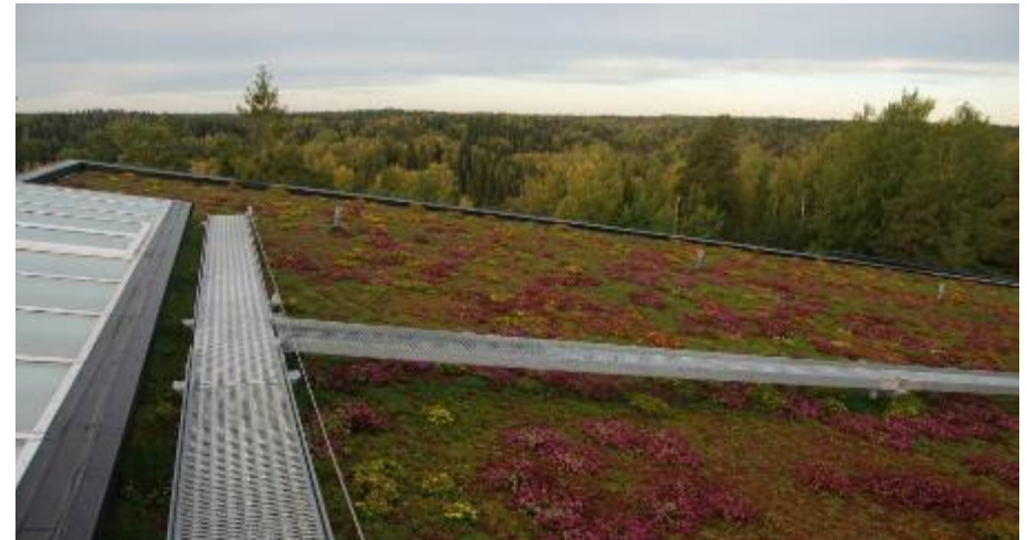
Bild 4. Exempel på ett extensivt grönt tak. Objekt: Solvalla idrottsinstitut, Esbo. 2
