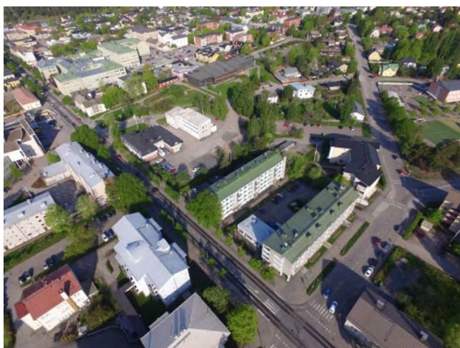
Situationen i kvarteret sommaren 2018. Förrådet mot höghusen längs Mannerheimgatan har rivits. Den gamla kopplingsstationen finns kvar.
