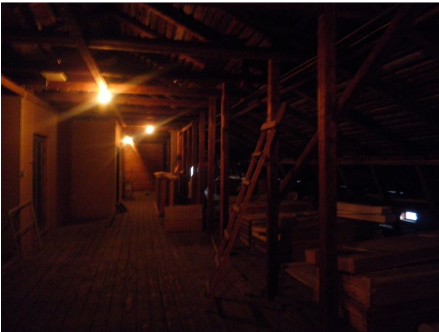
Kuva 69. Rakennus A:n kattostruktuuri on hyvin hahmotettavissa. Juha Vuorinen 2014.
