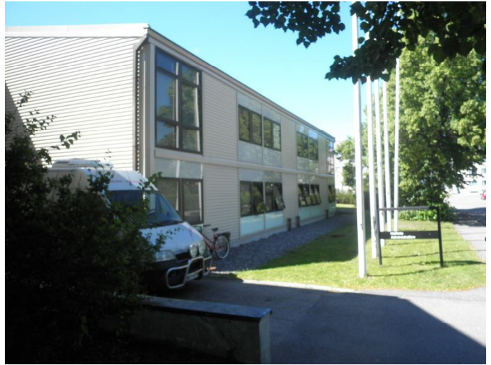
Kuva 93 ja 94. Rakennuksessa käytettiin ajankohdalle tyypillisiä materiaalikokeiluja, ja julkisivulasina on tummennettua eristyslasia. Juha Vuorinen 2014.
