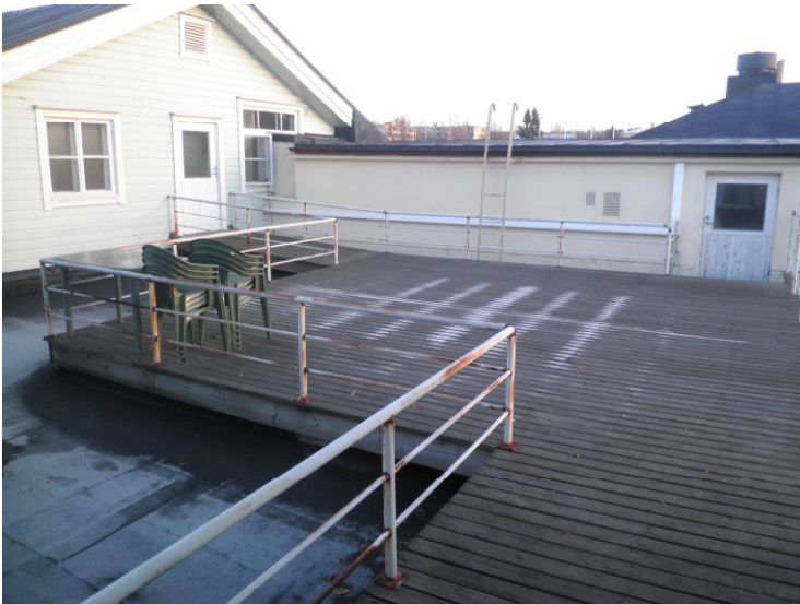
Kuva 85. Pääsisäänkäynnin yläpuolella on 1980-luvun alussa toteutettu terassi, josta on pääsy rakennus A:n ullakolle. Juha Vuorinen 2014.
