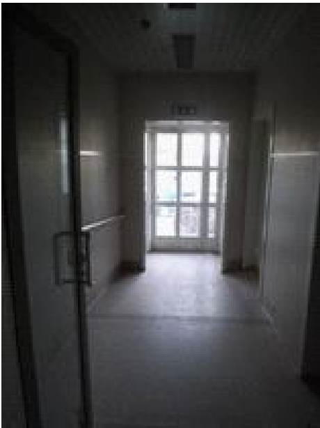
Kuva 65. Rakennus A:n alkuperäistä kiinteää sisustusta ei ole ensimmäisessä kerroksessa säilynyt. Jalka- ja kattolistoja ei ole säilynyt. Yleisvaikutelma on viimeisen käytön myötä synnytetty terveystakeskusmaisen steriili. Rakennuksen pinnat on levytetty, lattia peitetty muovimatolla ja yleisväri on laitosbeige. Juha Vuorinen 2014.
