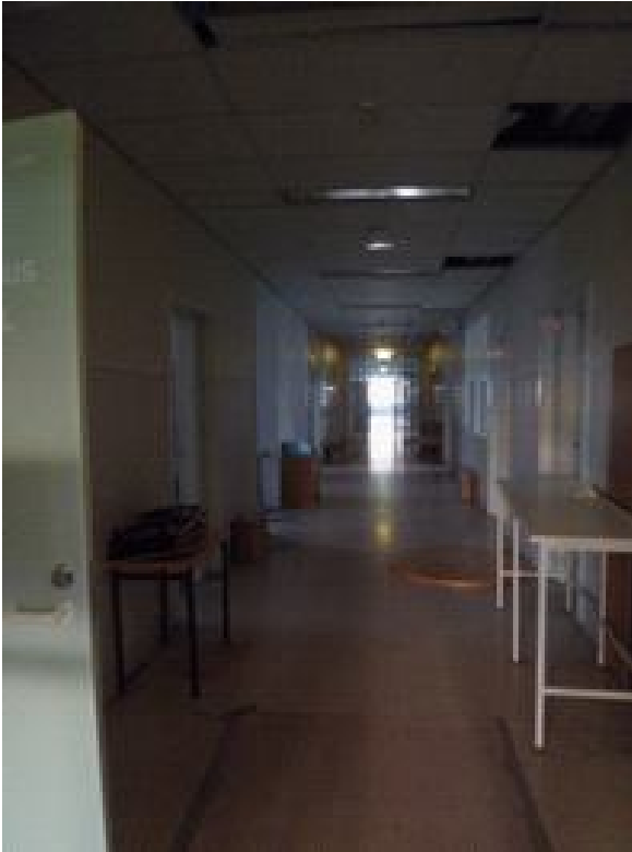
Kuva 64. Varhaisvaiheiden tilaohjelman periaatteet ovat pysyneet pitkälti entisellään. Tilaohjelmassa oleellisinta on keskuskäytävä, joka jakaa huonetiloja. Väliseinissä on vuosien saatossa ollut runsaasti liikehdintää, mutta ottaen huomioon kokonaisuuden institutionaaliset muutokset ovat alkuperäiset tilaohjelman periaatteet hyvin hahmotettavissa. Tilanne on todennettavissa sijoitettaessa alkuperäinen pohjapiirros nykyisen päälle (ks. kuva 99). Juha Vuorinen 2014.
