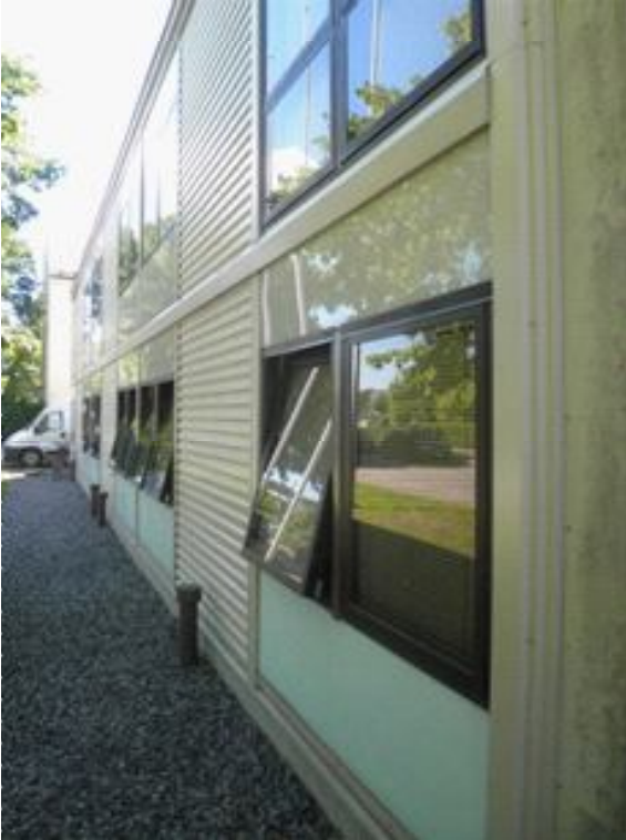
Kuva 93 ja 94. Rakennuksessa käytettiin ajankohdalle tyypillisiä materiaalikokeiluja, ja julkisivulasina on tummennettua eristyslasia. Juha Vuorinen 2014.
