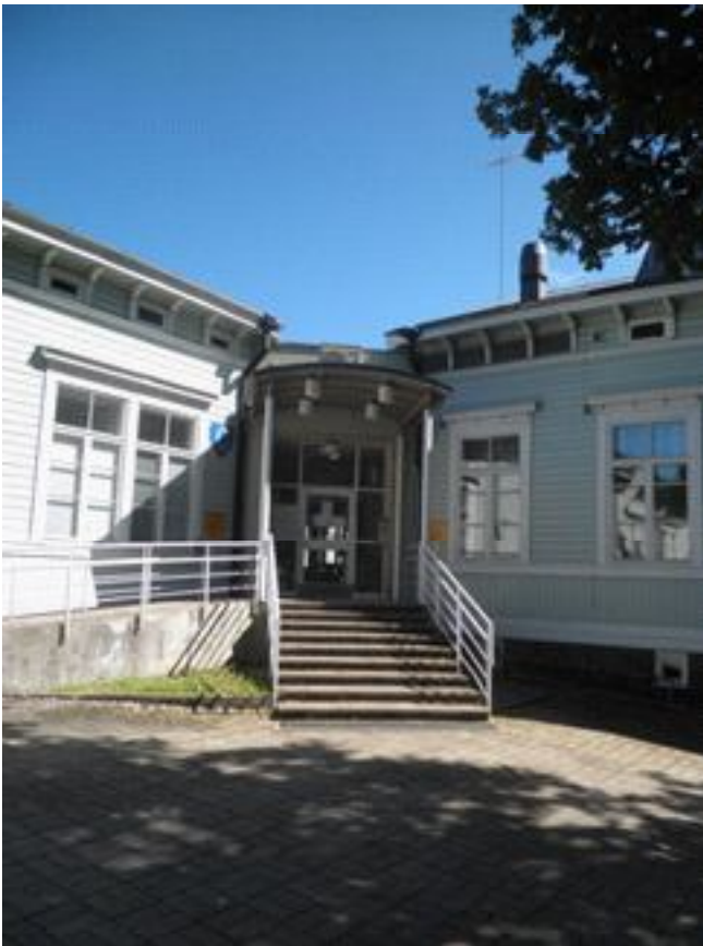
Kuva 81. Rakennuksen (järjestyksessään kolmas) pääsisäänkäynti. Ramppi , istutusallas ja katos ovat 1990-lopun saneerauksesta. Juha Vuorinen 2014.
