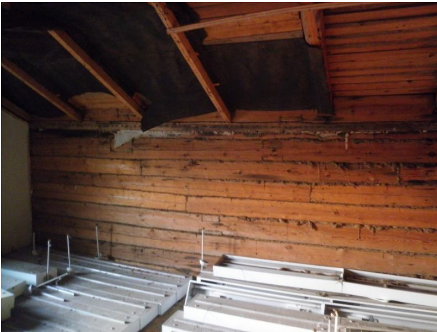
Kuva 67. Rakennuskokonaisuuden vanhimmat alkuperäiset pinnat löytyvät lähes muuttumattomina ja pitkään vajaassa käytössä toimineelta ullakolta. Hirsikäsittelyä on näkyvillä ullakon huonetiloissa. Juha Vuorinen 2014.
