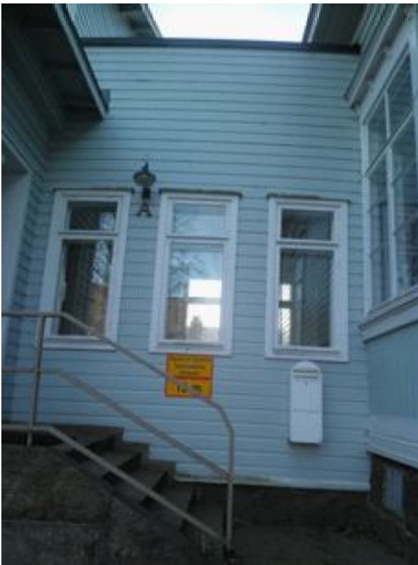
Kuva 73. Jatkeosa rakennus A:n ja B:n välillä. Juha Vuorinen 2014.
