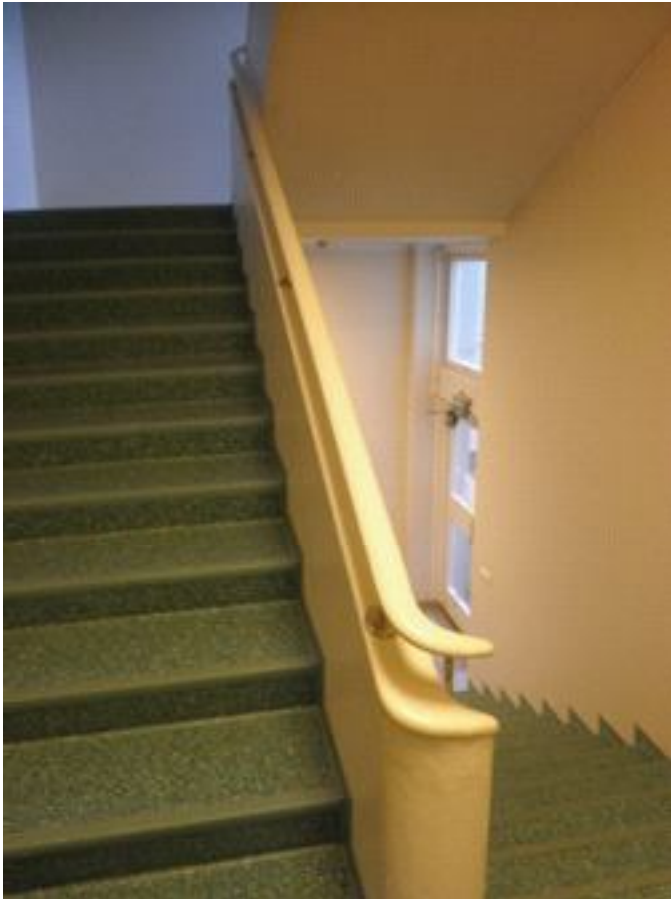
Kuva 83. Eleettömät porrashuoneet kaidejärjestelmineen edustavat muuntumattominta osaa rakennus D:ssä. Juha Vuorinen 2014.
