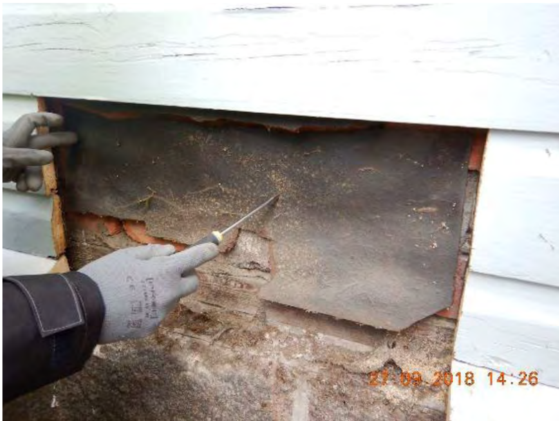
Kuva 32. Ulkoseinäavaus U41. Julkisivulaudoituksen takana tervapaperi ja tiilimuuraus.
