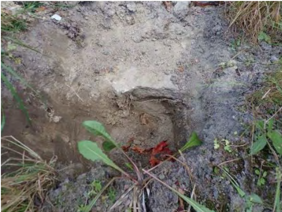
Kuva 6. Avauksessa havaittiin sokkelin aluskivi.
