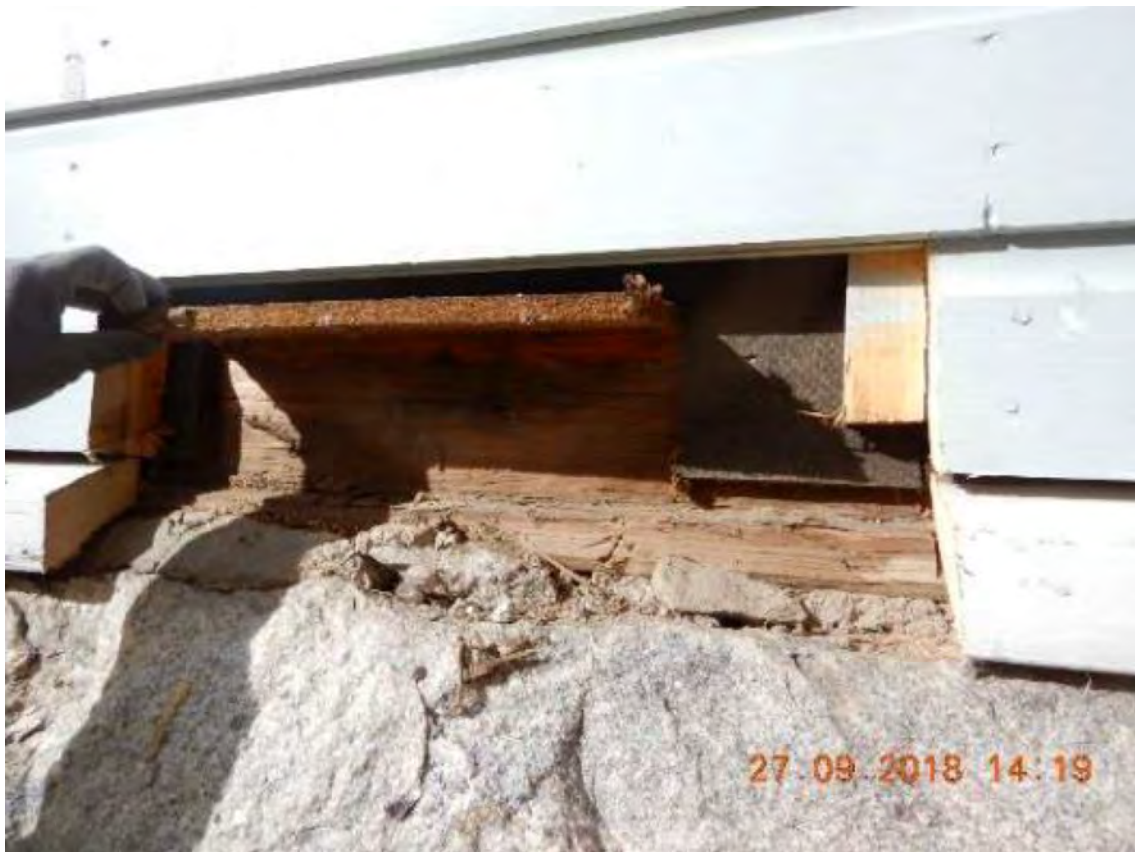
Kuva 29. Ulkoseinäavaus U42. Tuulensuojalevy hirsirunkoa vasten.
