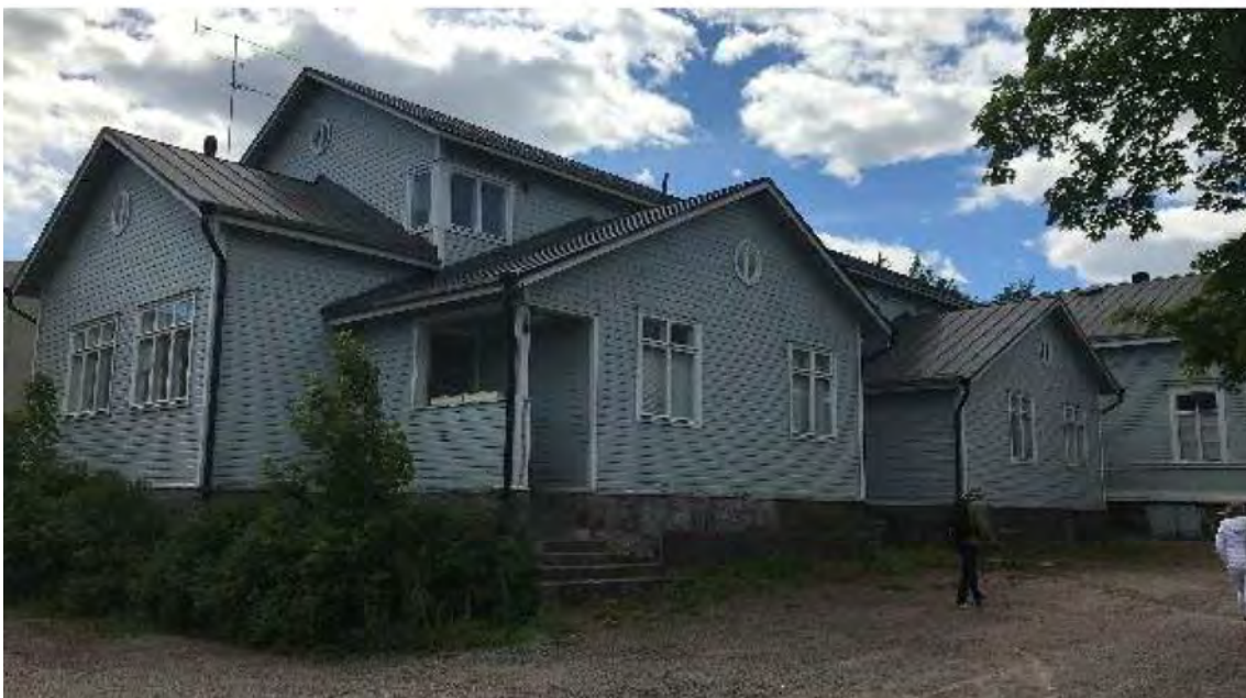
Kuva 3. C-osan pitkän sivun julkisivu.
