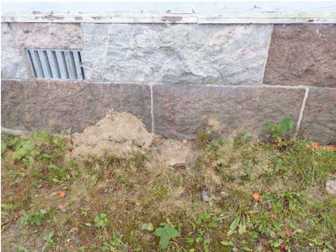
Kuva 5. Sokkelin vierustan kaivuu.
