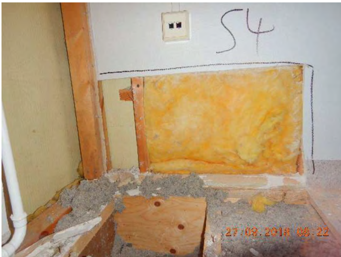
Kuva 44. Rakenneavaus S4 sisäseinästä.
