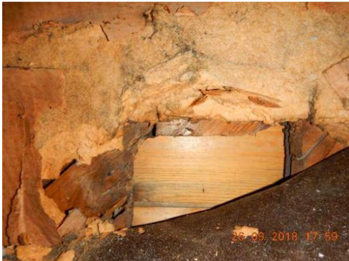
Kuva 35. Ulkoseinäavaus U02, huokoisen kipsilevyn takana vinolaudoitus ja julkisivulaudoitus.
