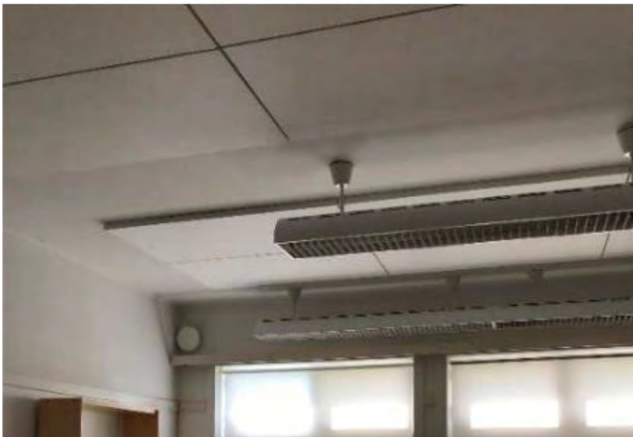
Kuva 46. Huoneiden katossa akustiikkalevyjä.
