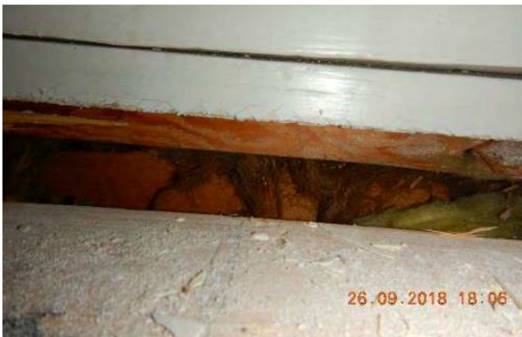
Kuva 37. Ikkuna-avaus I15. Tilkemateriaalina rive.
