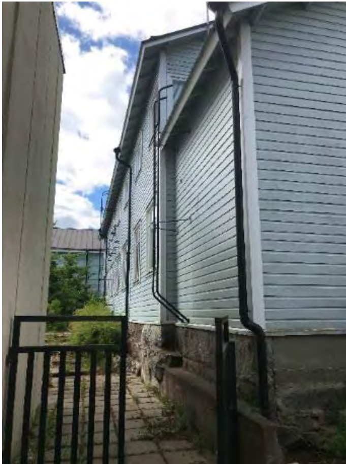
Kuva 4. C-osan julkisivu sisäpihan suuntaan.
