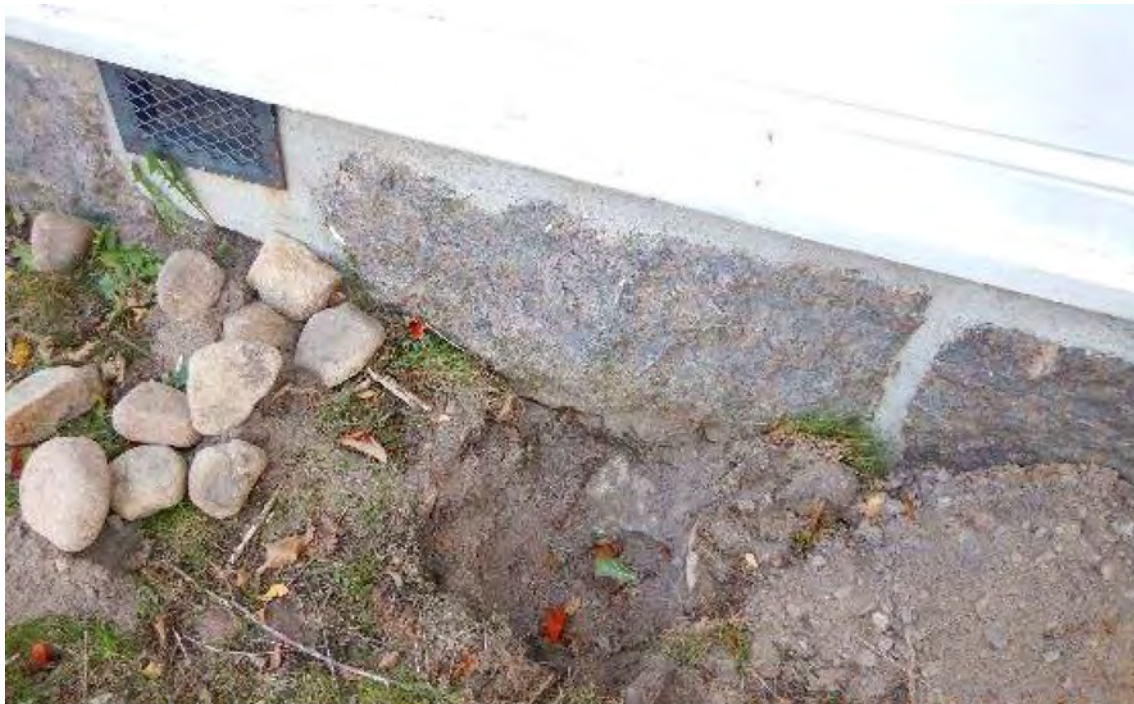
Kuva 5. Tuuletusaukko E-osan sokkelissa ja sokkelin vierusta auki kaivettuna. Sokkelin alla leveämpi aluskivi.
