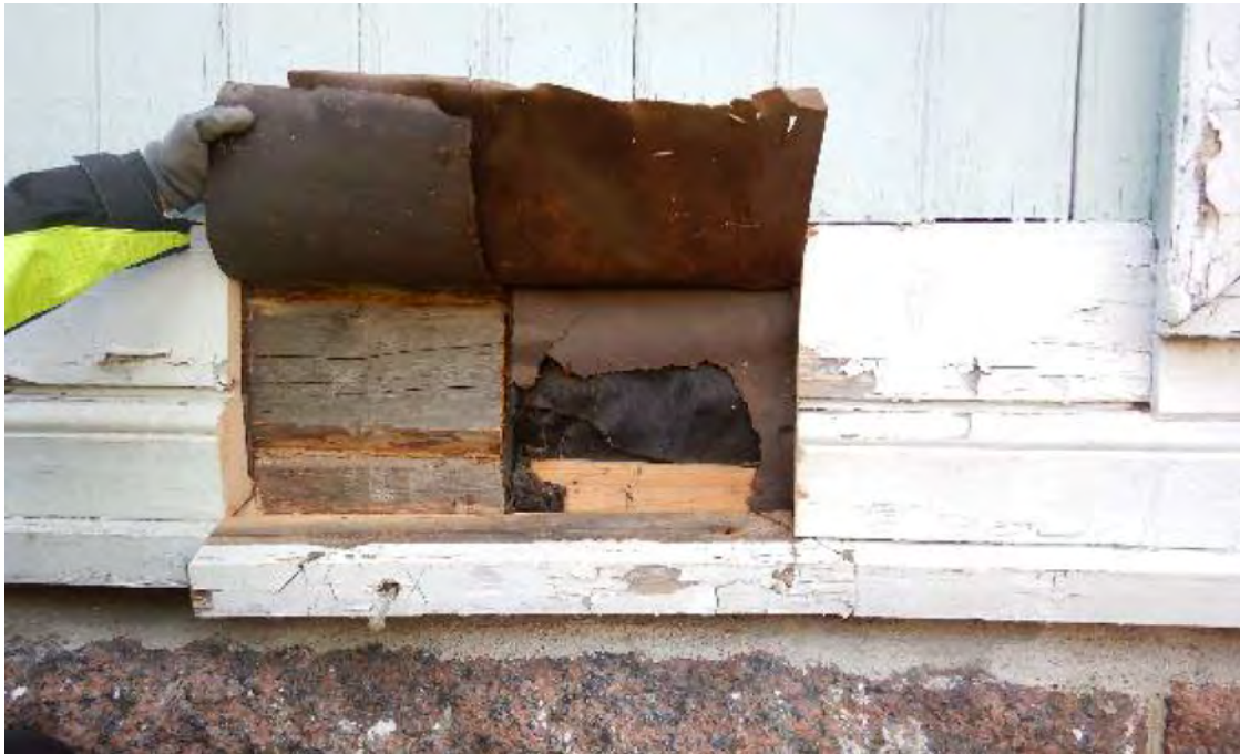
Kuva 24. Ulkoseinäavaus U40. Oikeassa alareunassa vanha läpivientiaukko, joka on tukittu tervapaperi-mineraalivilla-tervapaperi -rakenteella.
