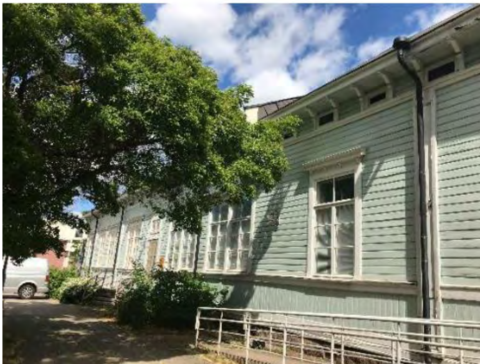
Kuva 3. Rakennuksen E-osan pitkä sivu.
