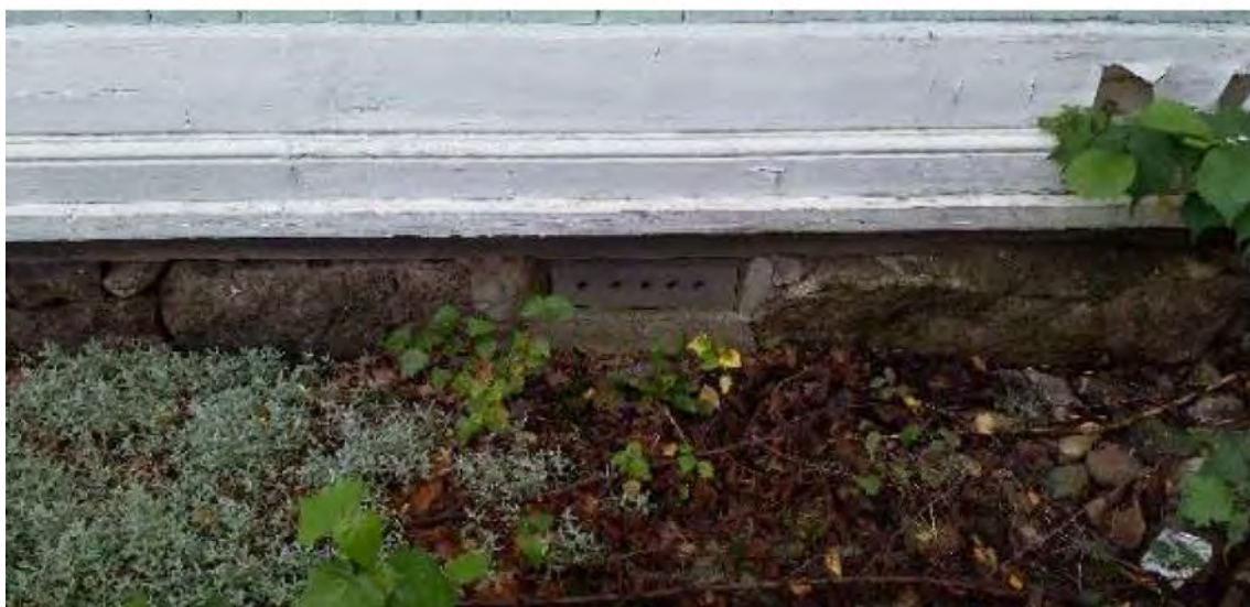
Kuva 6. Esimerkki yhdestä rakennuksen E-osalla olevasta ryömintätilan tuuletusaukosta.
