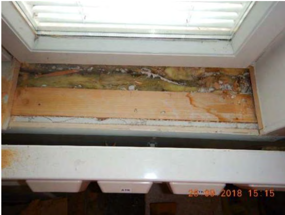
Kuva 25. Ikkuna-avaus I16 tilassa 2093.
