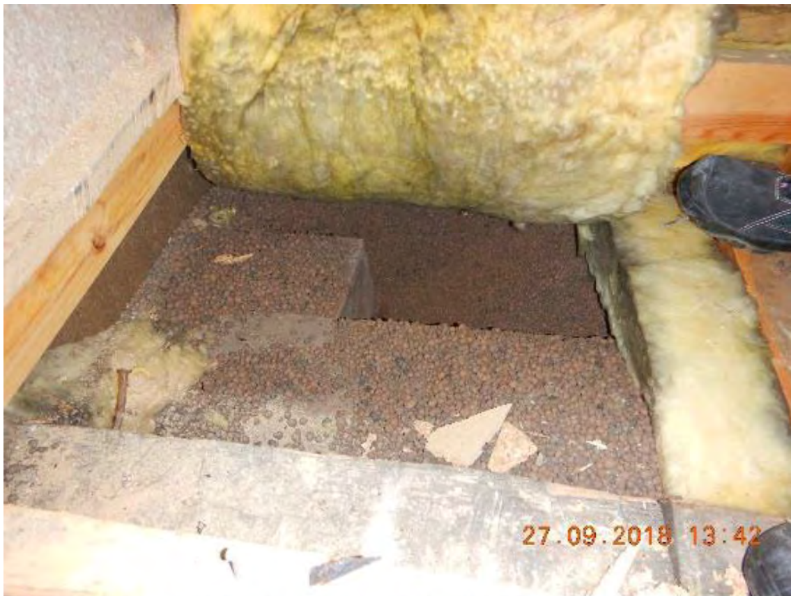
Kuva 12. Alapohja-avaus A01. Mineraalivillan alla kevytsoraa.
