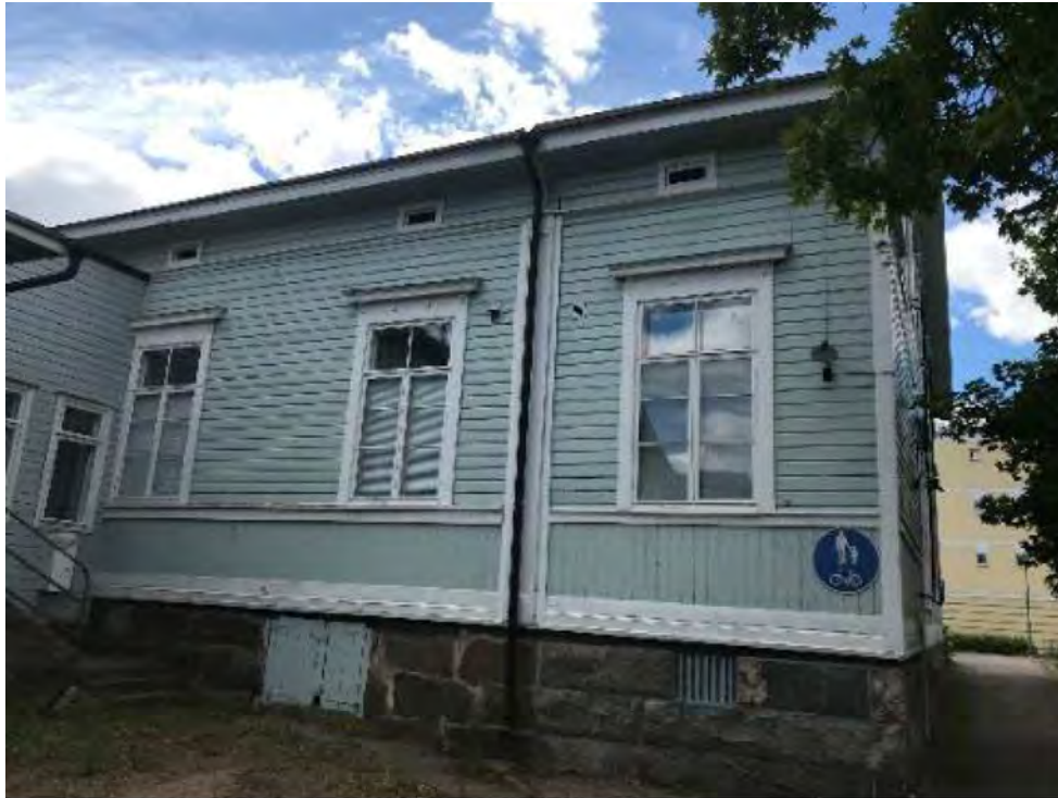
Kuva 2. Rakennuksen E-osan pääty.
