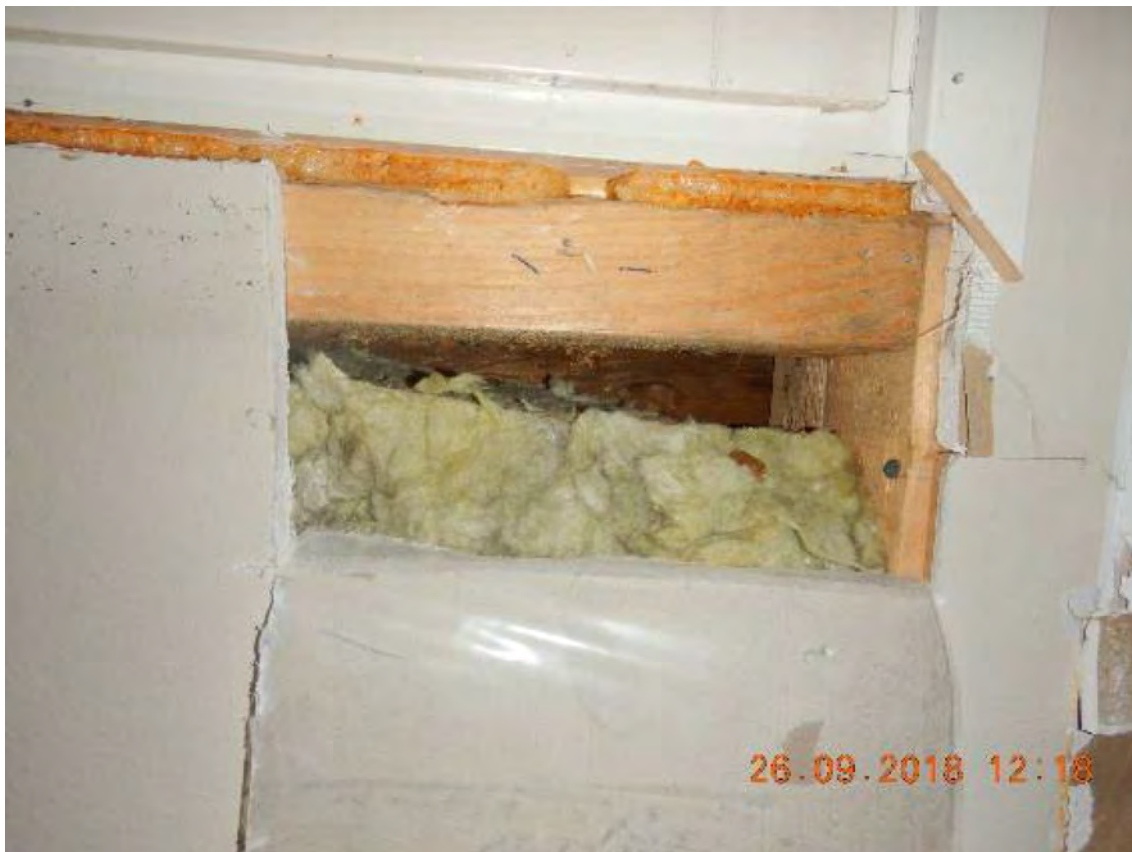
Kuva 46. Ikkuna-avaus I20. Tilkkeenä polyuretaani.
