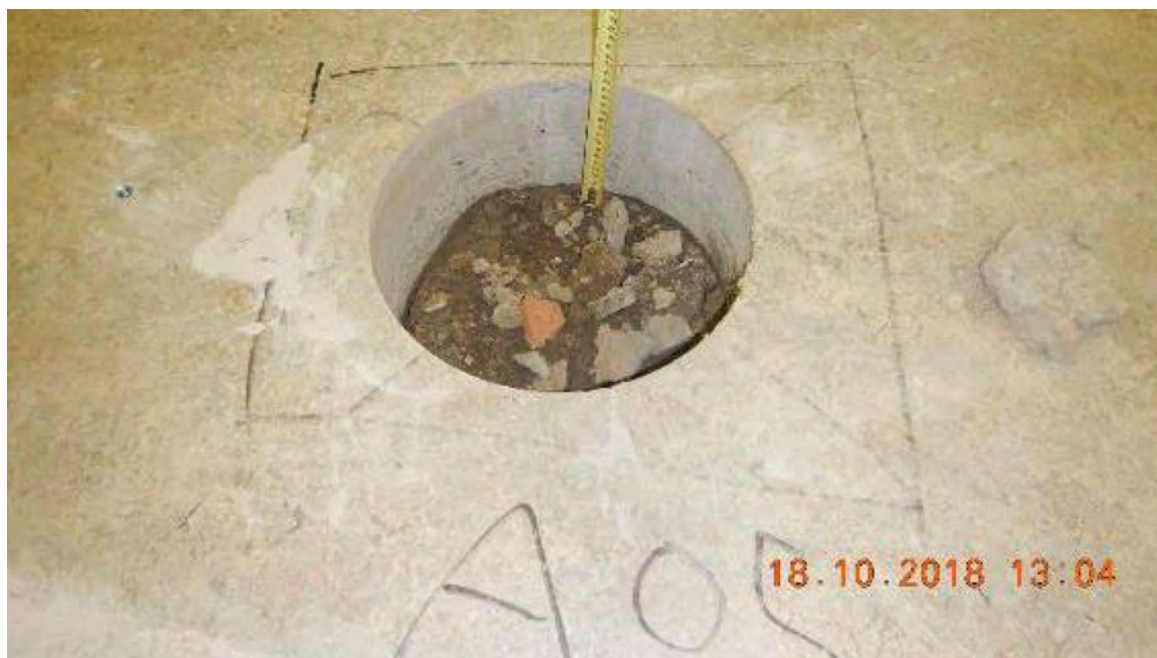
Kuva 20. Alapohja-avaus A05 tilassa 1062.
