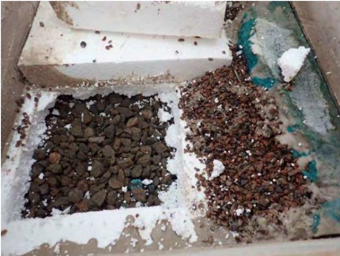
Kuva 22. Alapohja-avaus A25. EPS-eristeen alla sora. Luonnonkivisokkelissa vedeneriste.
