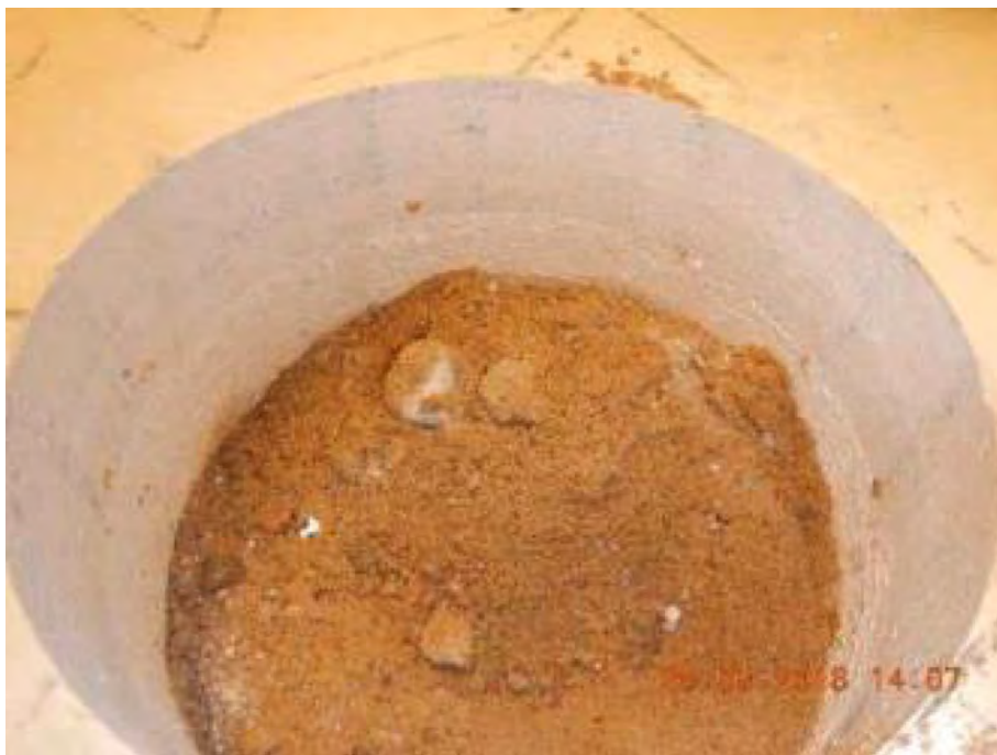
Kuva 16. Alapohja-avaus A03. EPS-eristeen alla hiekka.
