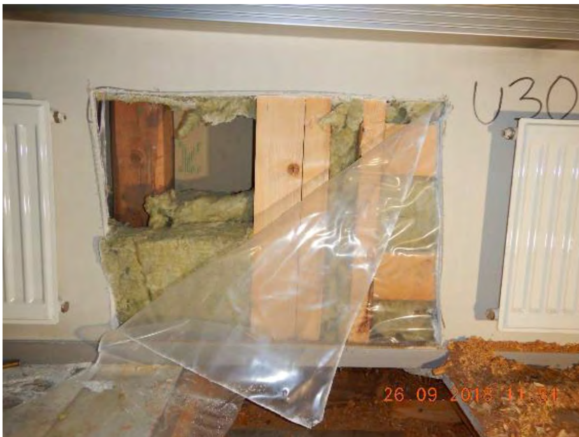
Kuva 44. Ulkoseinäavaus U30.
