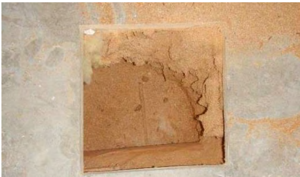
Kuva 33. Välipohja-avaus V18. Purun alla paperi, joka kiertää hirsirungon yli.
