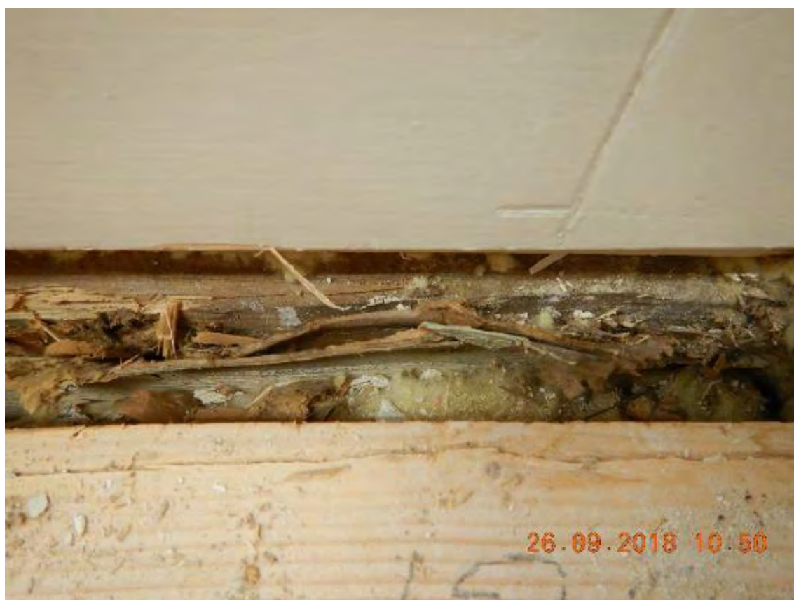
Kuva 45. Ikkuna-avaus I18. Ikkunan alapuolella seinässä pahvi. Tilkkeenä villa.
