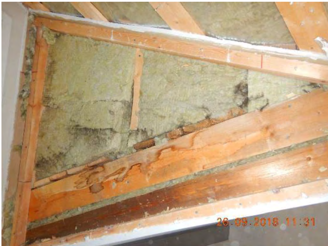
Kuva 57. Laudoituksessa kosteusjälkiä.
