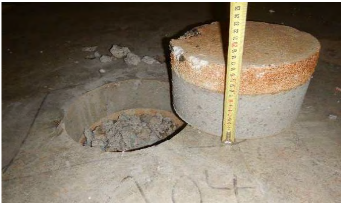
Kuva 18. Alapohjarakenteessa betoni ja EPS-eriste.
