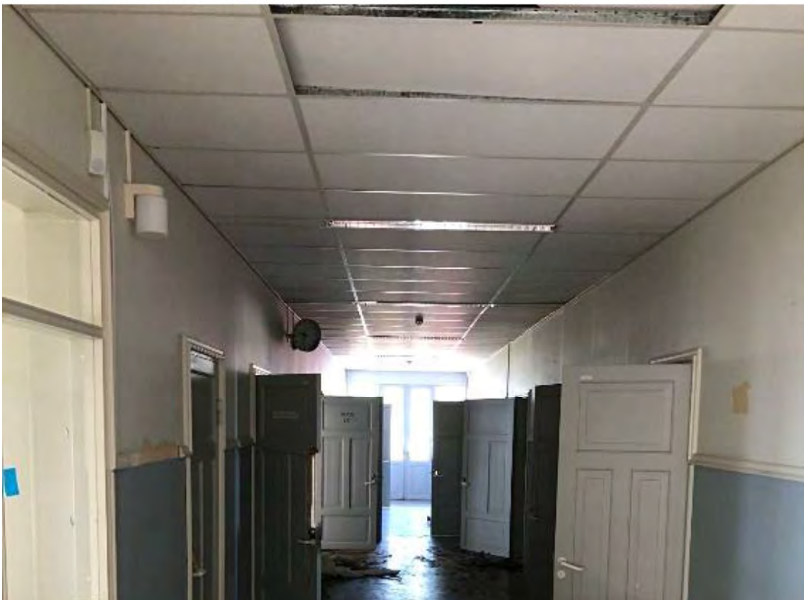
Kuva 60. F-osan 2. kerroksen käytävällä alas laskettu katto.
