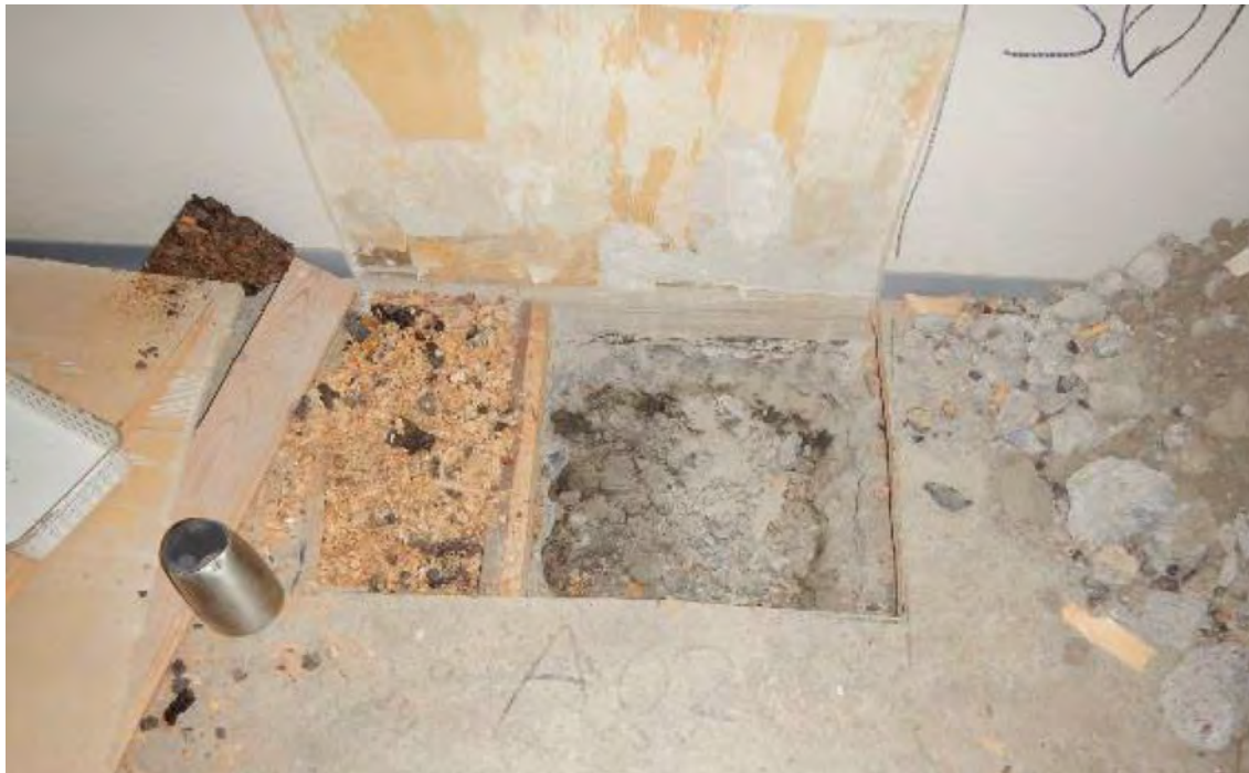
Kuva 14. Alapohja-avaus A02. Eristeenä puru ja expandoitu korkki.
