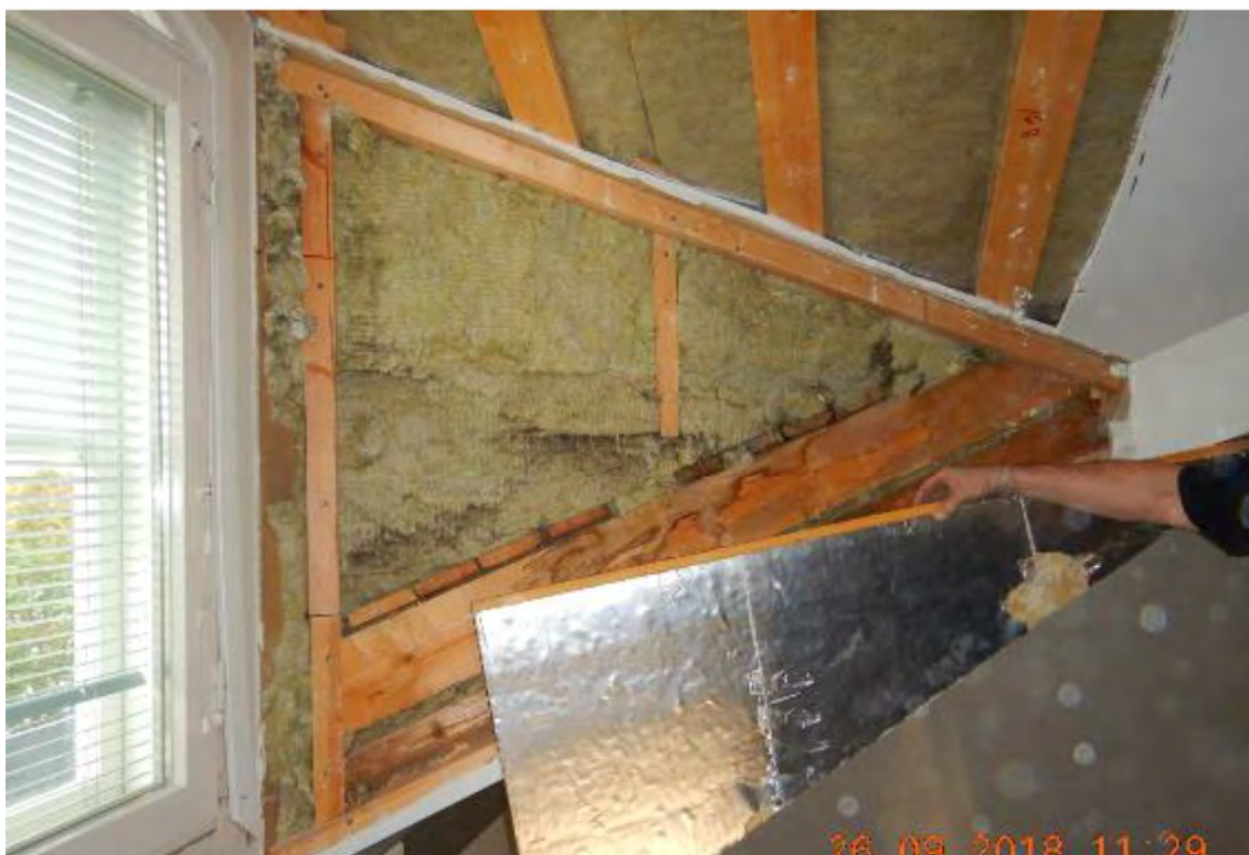
Kuva 56. SPU-levyn takana mineraalivilla ja laudoitusta.
