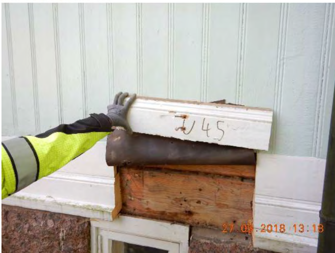
Kuva 41. Ulkoseinäavaus U45 tilan 2072 kohdalla.
