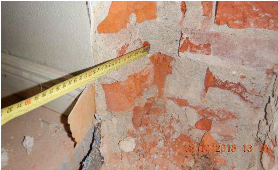
Kuva 10. Muissa tiloissa ei sisäpuolista lämmöneristettä havaittu.
