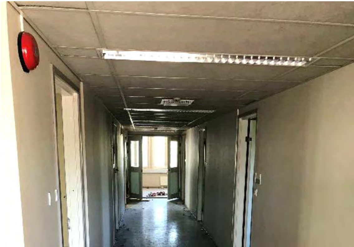
Kuva 61. F-osan 3. kerroksen käytävällä alas laskettu katto.
