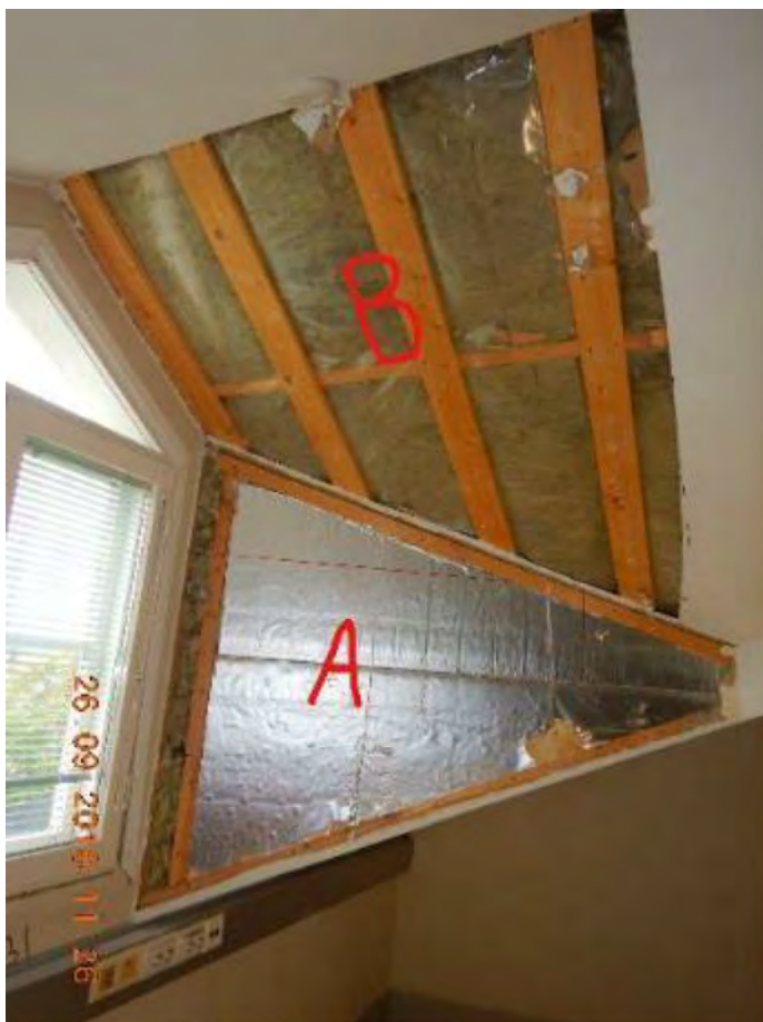
Kuva 55. Kattolyhdyn avaus Y18.
