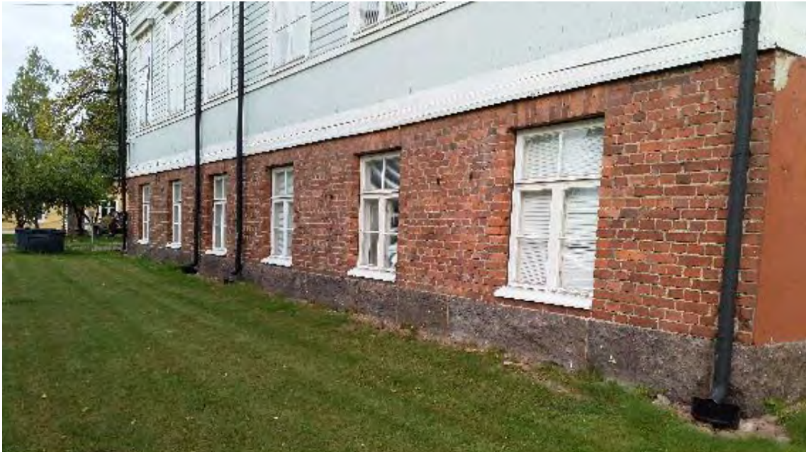
Kuva 2. F-osan Vänrikinkadun puoleinen seinusta.
