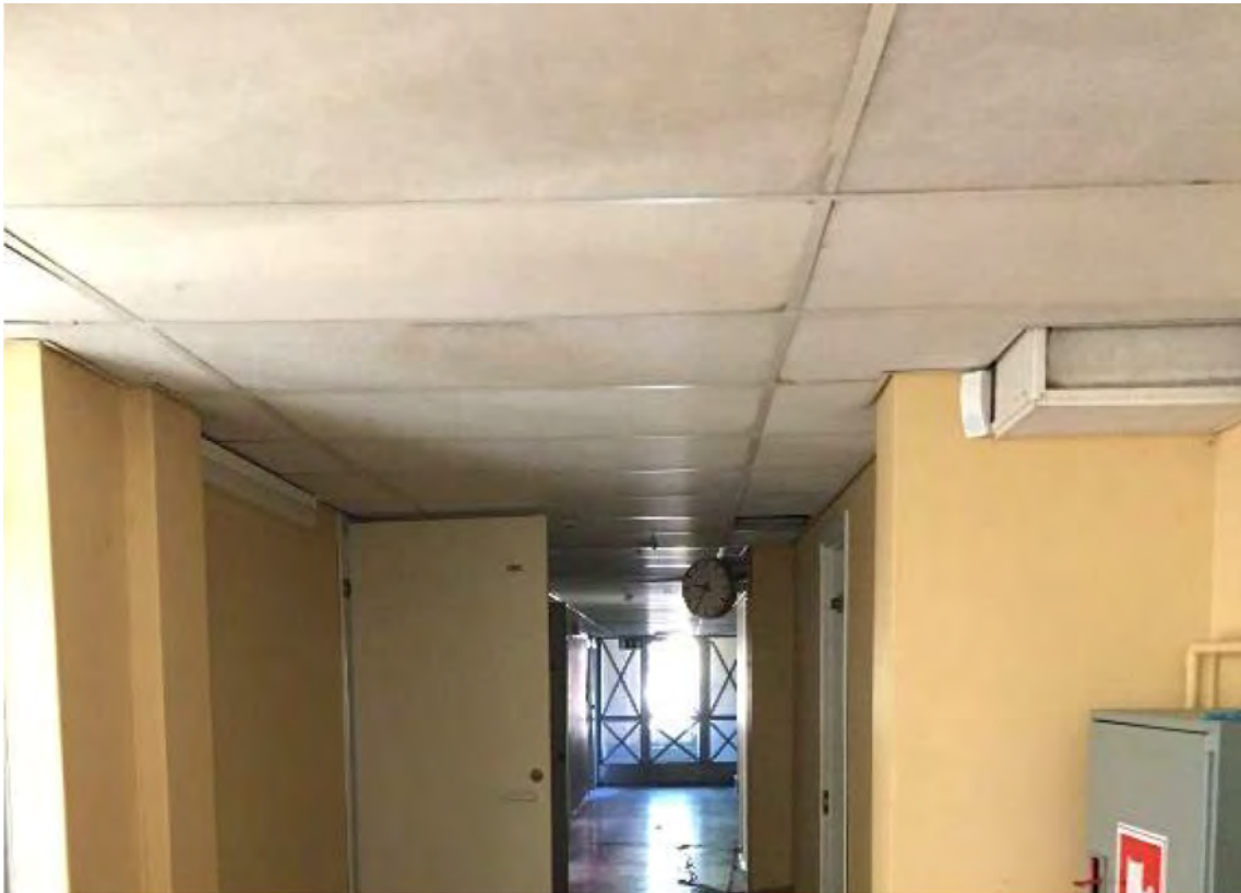
Kuva 59. F-osan kellarin käytävällä alas laskettu katto.
