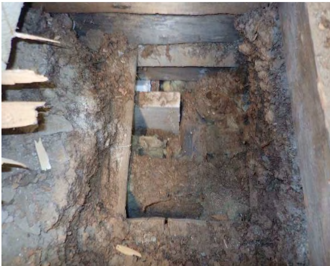
Kuva 9. MS5:n EPS- ja mineraalivillaeriste näkyvät välipohja-avauksen V17 kautta.
