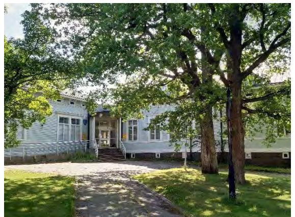
Kuva 9. Sisäänkäynti E- ja F-osien välissä.
