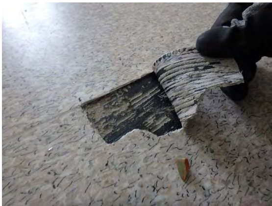
Kuva 38. E- ja F-osan kokoamanäyte mustasta liimasta (ASB11) ei sisällä asbestia. Muut näytteet mustasta liimasta sisälsi asbestia ja on mahdollista, että tämäkin liima on asbestipitoista ja näytteenotossa on osuttu kohtaan, jossa asbestia ei ole. Käsitellään kohteen kaikki mustat liimat asbestipitoisena.
