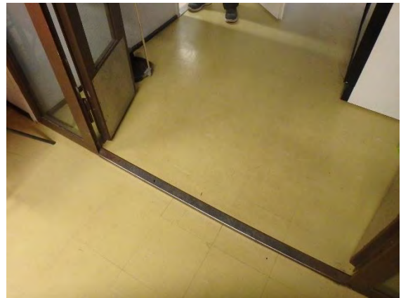
Kuva 33. Lattiapinnoitteena asbestipitoista viinyyllilaattaa.
