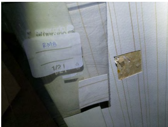
Kuva 69. Näyte wc-tilojen muovitapetista (RM8).
