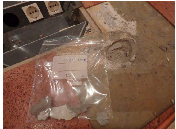
Kuva 11. Näyte lattiatasoitteesta (ASB19) ei sisällä asbestia.
