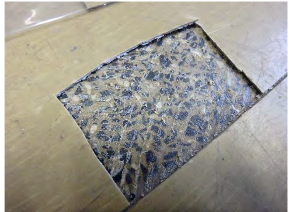
Kuva 56. Näyte teknisen tilan muovimatosta (RM40). Alla mosaiikkibetoni.
