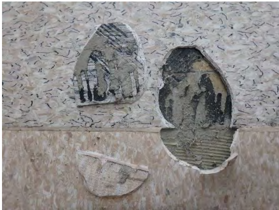
Kuva 43. E- ja F-osan kokoamanäyte mustasta liimasta (ASB11) ei sisällä asbestia. Muut näytteet mustasta liimasta sisälsi asbestia ja on mahdollista, että tämäkin liima on asbestipitoista ja näytteenotossa on osuttu kohtaan, jossa asbestia ei ole. Käsitellään kohteen kaikki mustat liimat asbestipitoisena.
