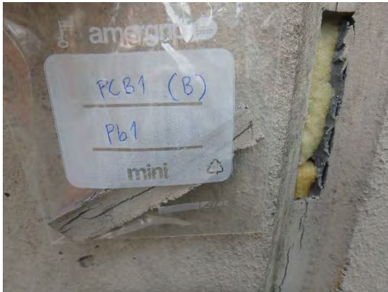
Kuva 92. Näyte B-osan julkisivuelementtien saumamassasta (PCB1).
