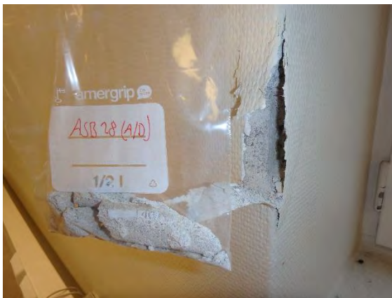
Kuva 18. Kokoamanäyte seinätasoitteesta (ASB28) ei sisällä asbestia.
