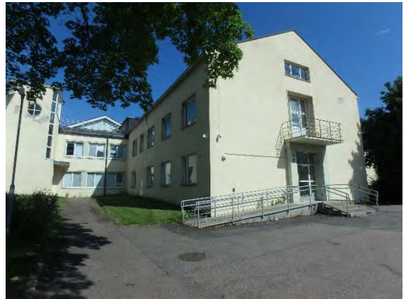
Kuva 5. D-osa 1930-luvulta. Kuvan vasemmassa reunassa näkyy 1980-luvulla rakennettu porrashuone.
