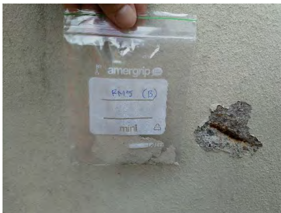
Kuva 66. Kokoamanäyte julkisivumaalista (RM5).
