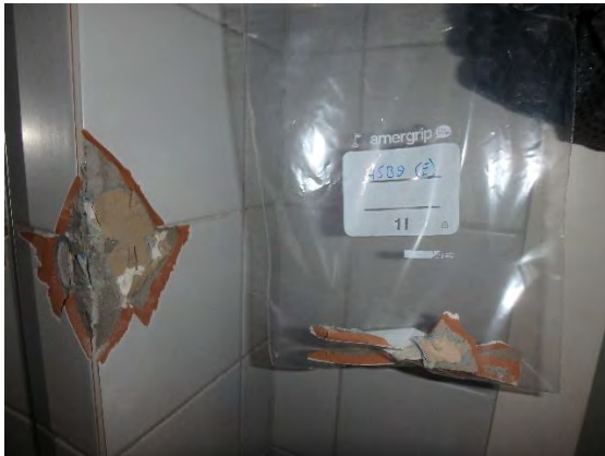
Kuva 36. Näyte seinälaatasta ja laasteista (ASB9) ei sisällä asbestia.
