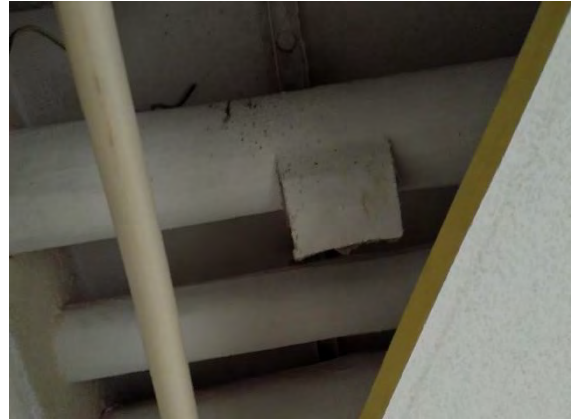
Kuva 23. Asbestipitoinen rikkiäinen putkieriste mahdollistaa asbestikuitujen pääsyn ilmaan.
