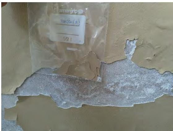
Kuva 53. Näyte porrashuoneen C seinämaalista (RM36).
