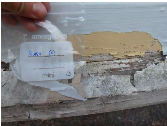
Kuva 67. Kokoamanäyte päällekkäisistä julkisivumaaleista, alla vanha keltainen ja päällä vaaleansininen maali (RM6).
