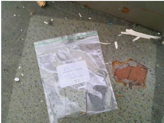
Kuva 82. Näyte ullakon linoleumista (RM21). Alla vanha ponttilautalattia, jonka maalista ei otettu näytettä. Lautalattiaan kohdistuvaa mahdollista purkua tai muita jatkotoimenpiteitä tehtäessä tulee vielä varmistaa maalin mahdolliset haitta-aineet.
