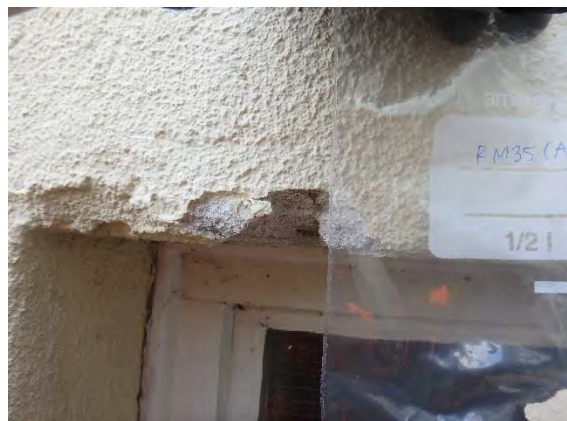
Kuva 52. Kokoamanäyte julkisivumaalista (RM35).
