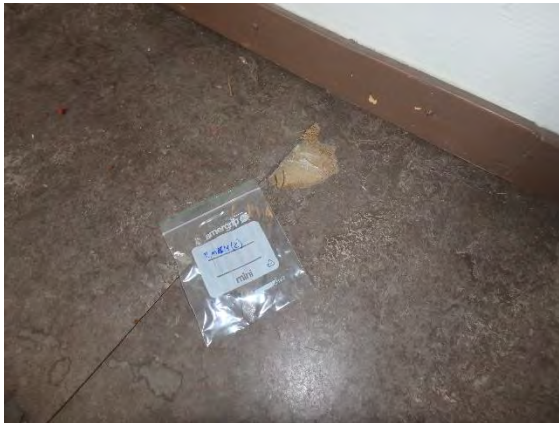
Kuva 75. Näyte C- ja E-osat yhdistävän käytävän linoleumista (RM14).
