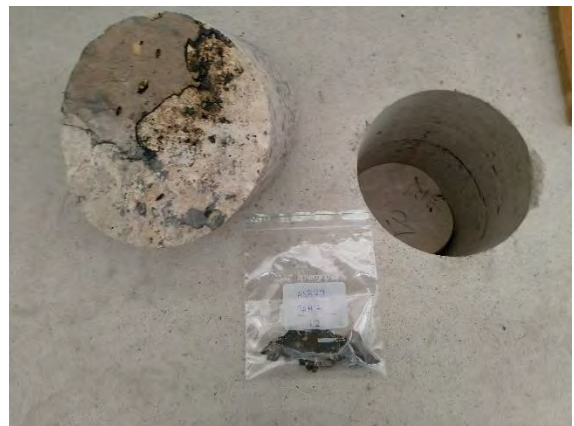
Kuva 19. Kokoamanäyte alapohjan bitumisive-lystä (ASB29) ei sisällä asbestia.
