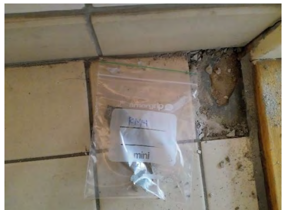
Kuva 65. Näyte lattialaatoituksen alta paljastuneesta vanhasta muovimatosta (RM4).
