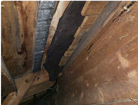
Kuva 97. Näyte vesikaton aluskatteesta ullakon huoneiden kohdalla (PAH4).
