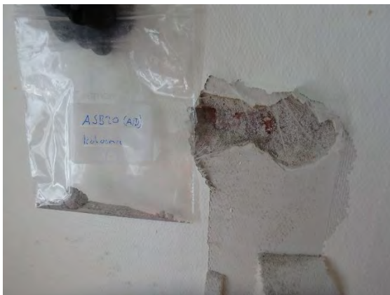
Kuva 12. Kokoamanäyte seinätasoitteesta (ASB20) ei sisällä asbestia.
