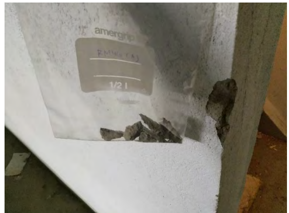
Kuva 60. Kokoamanäyte kellarin seinämaalista (RM46).
