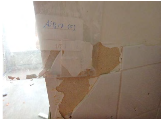
Kuva 44. Välitilan seinälaatta ja saumalaasti (ASB17) ei sisällä asbestia.
