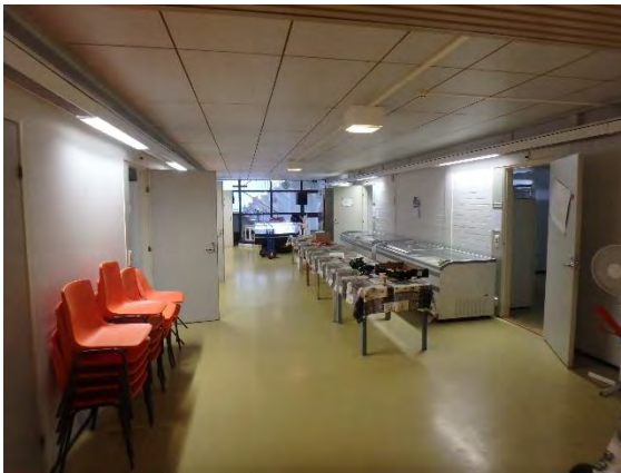
Kuva 32. Lattiapinnoitteena asbestipitoista viinyyllilaattaa.
