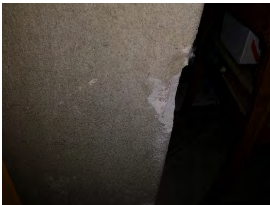
Kuva 14. Kokoamanäyte ullakon hormien rappauksesta (ASB22) ei sisällä asbestia.
