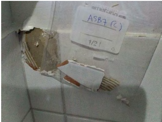
Kuva 34. Näyte seinälaatasta ja laasteista (ASB7), ei sisällä asbestia.
