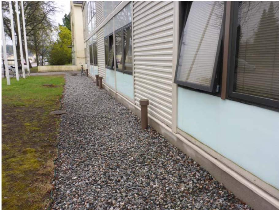
Kuva 19. B-osan kadunpuoleista julkisivua. Tuuletusputket johtavat todennäköisesti alapohjalaatan alle.
