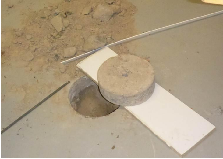
Kuva 11. Vanha rakenneavaus A-osan kellarissa. Maaperä lattian betonilaatan alla on hyvin hienojakoista.
