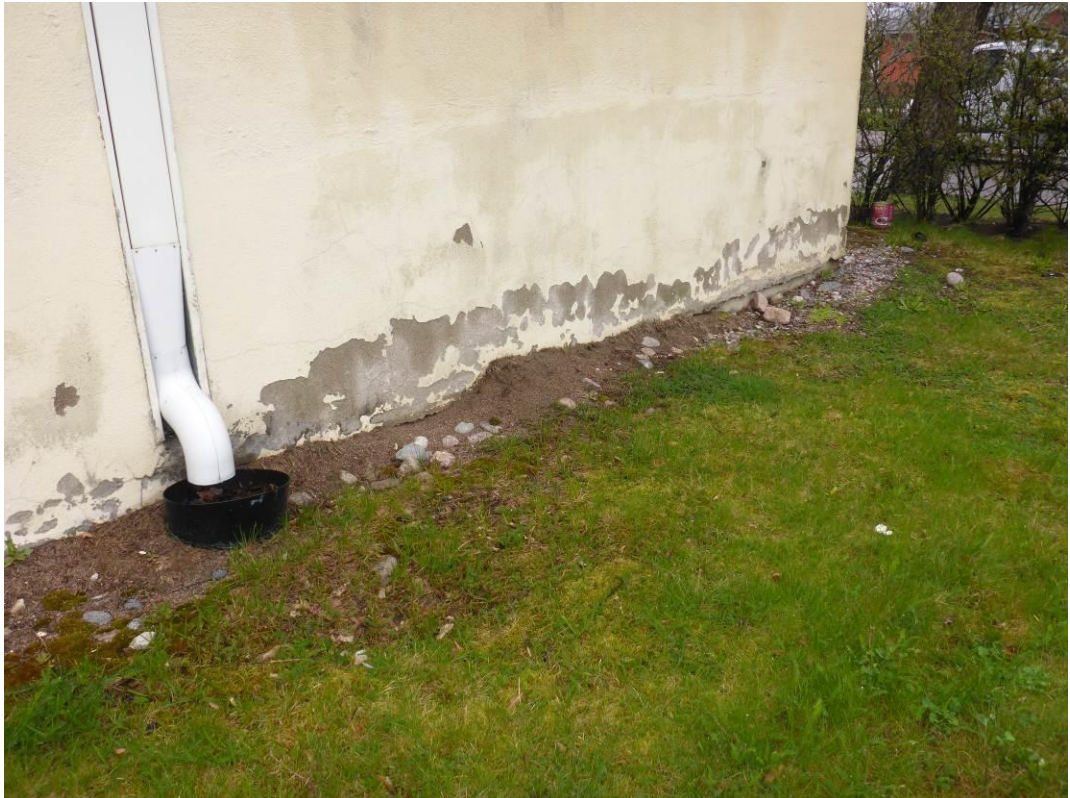
Kuva 10. Sokkelipinnan hilseilyä.
