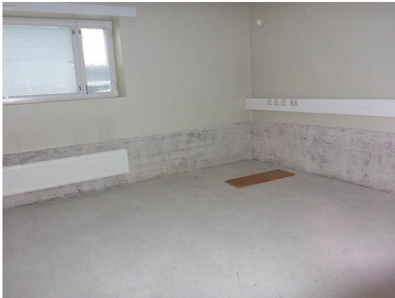
Kuva 4. A-osan kellarin seinäpintojen alaosaan tasoitteet on poistettu.
