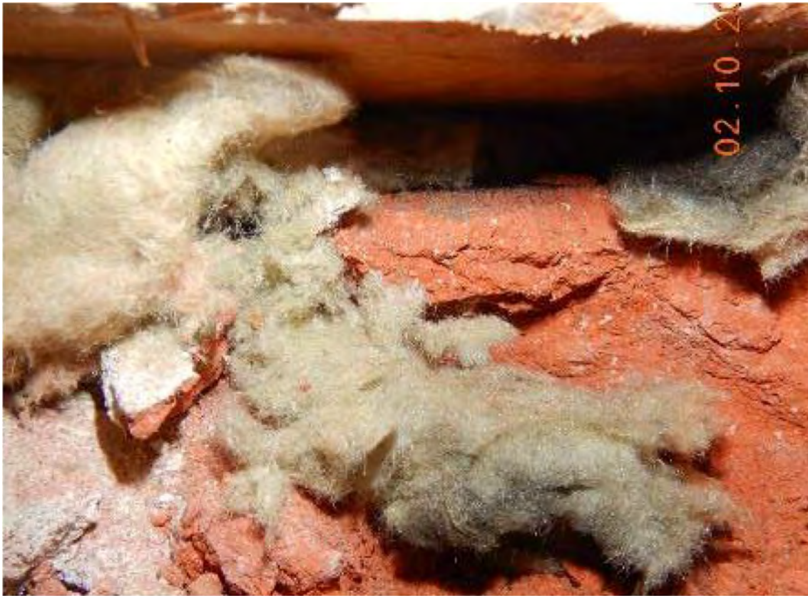
Kuva 53. Ikkuna-avaus I2 tilassa 1034. Tilkkeenä mineraalivilla.
