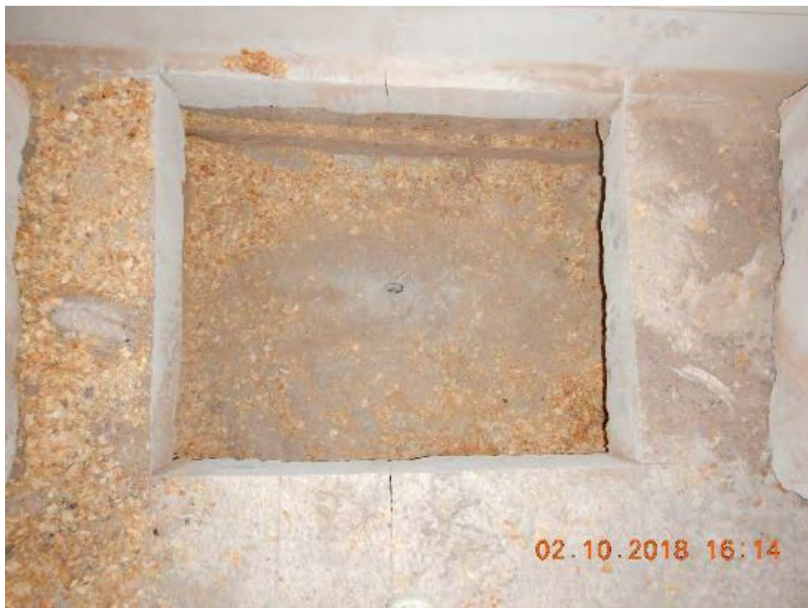
Kuva 42. Välipohja-avaus V3. Välipohjakoteloiden täytteenä on purua.
