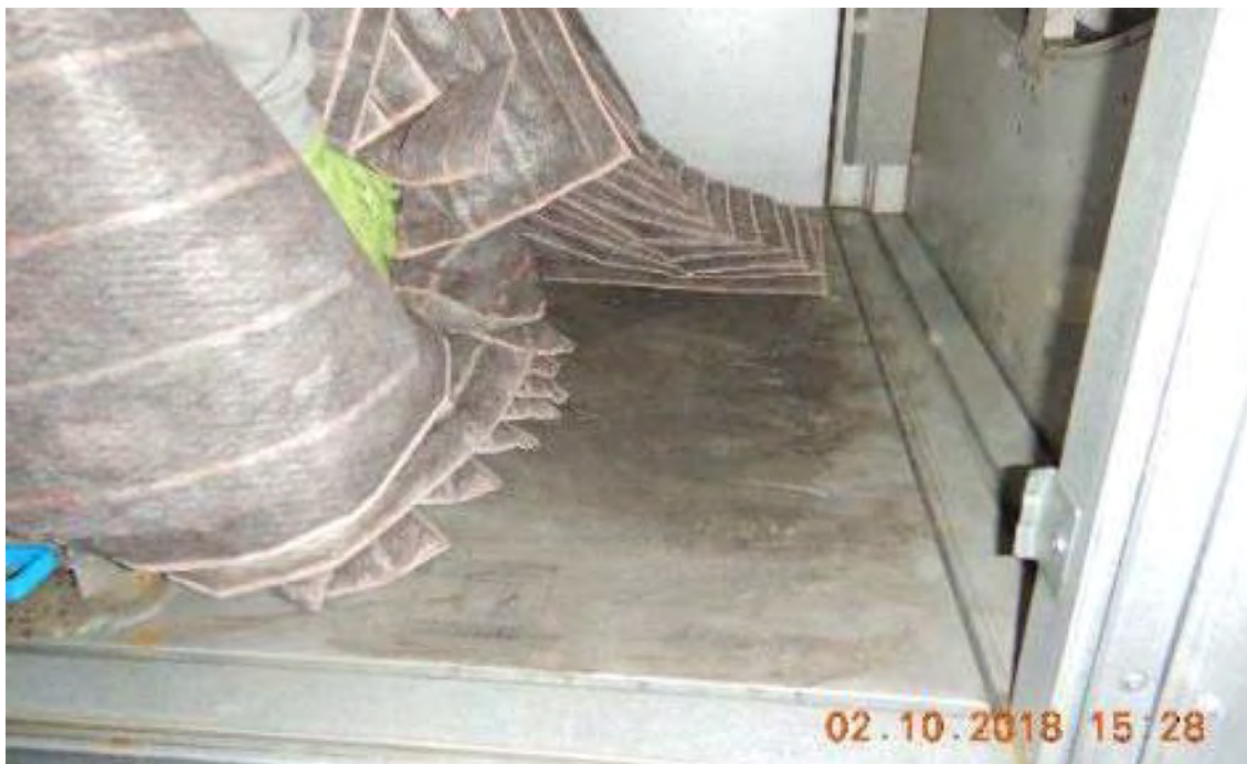
Kuva 65. IV-koneen suodatinkammio on todella likainen.
