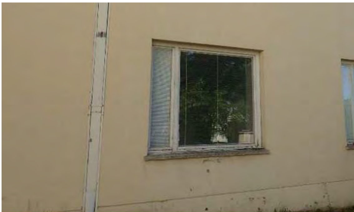
Kuva 55. D-osan ikkuna ulkoa.
