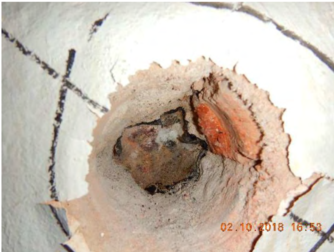
Kuva 10. Maanvastaisen seinän rakenneavaus M02.
