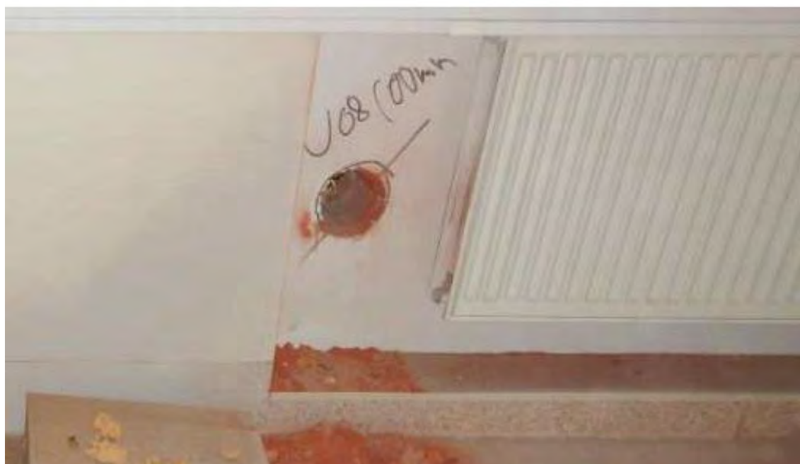
Kuva 49. Ulkoseinäavaus U08 patterin taustaan tilassa 2040.
