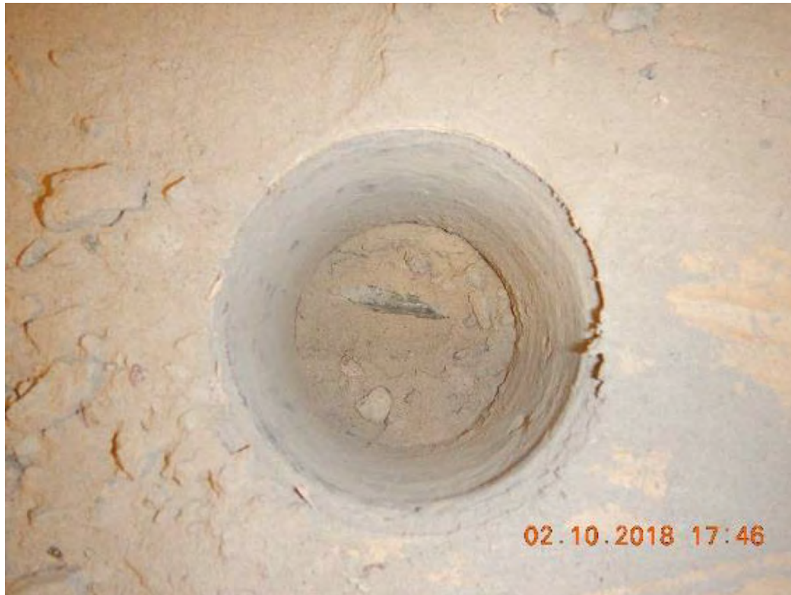
Kuva 36. Välipohja-avaus V1. Avauksessa nähtävissä liittolaatta.
