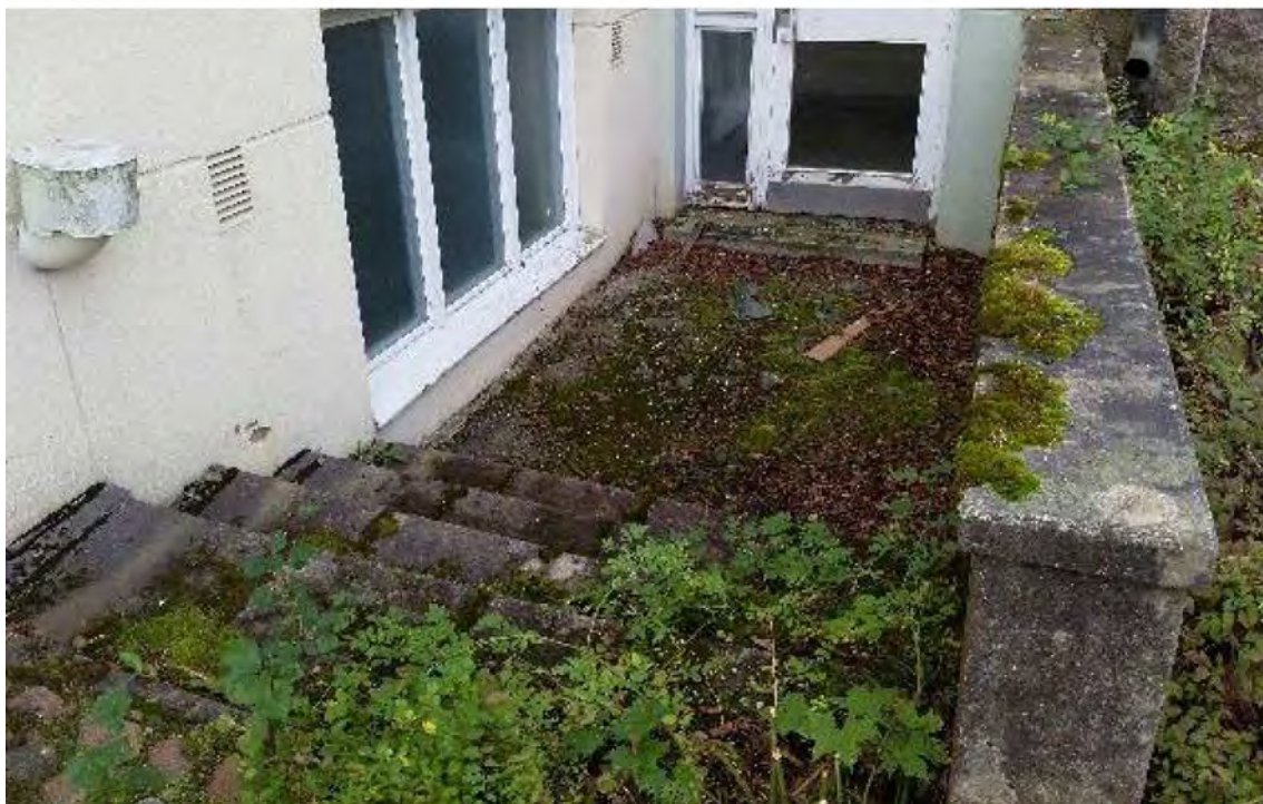
Kuva 5. Sisäpihan puolella sijaitseva sisäänkäyntitasanne kerää sadevettä rakennuksen vierustalle.
