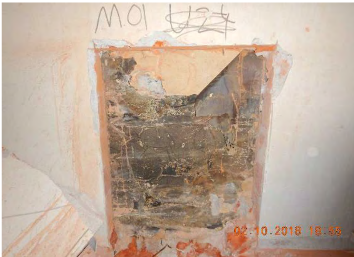
Kuva 14. Maanvastaisen seinän avaus M01, huokoisin puukuitulevyn takana näkyy betoni-pinta.
