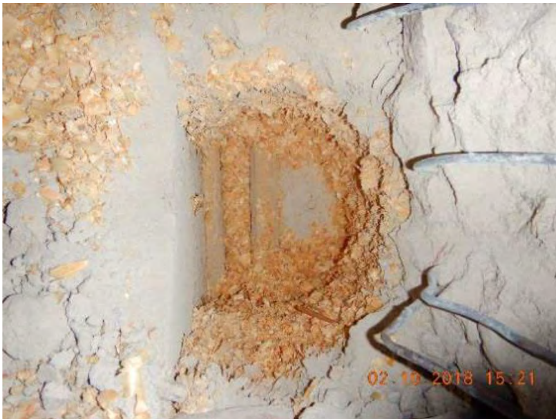
Kuva 61. Yläpohja-avaus Y2 ullakkotilan 3026 A-osalla ulkoseinän vieressä. Eristeenä purua.
