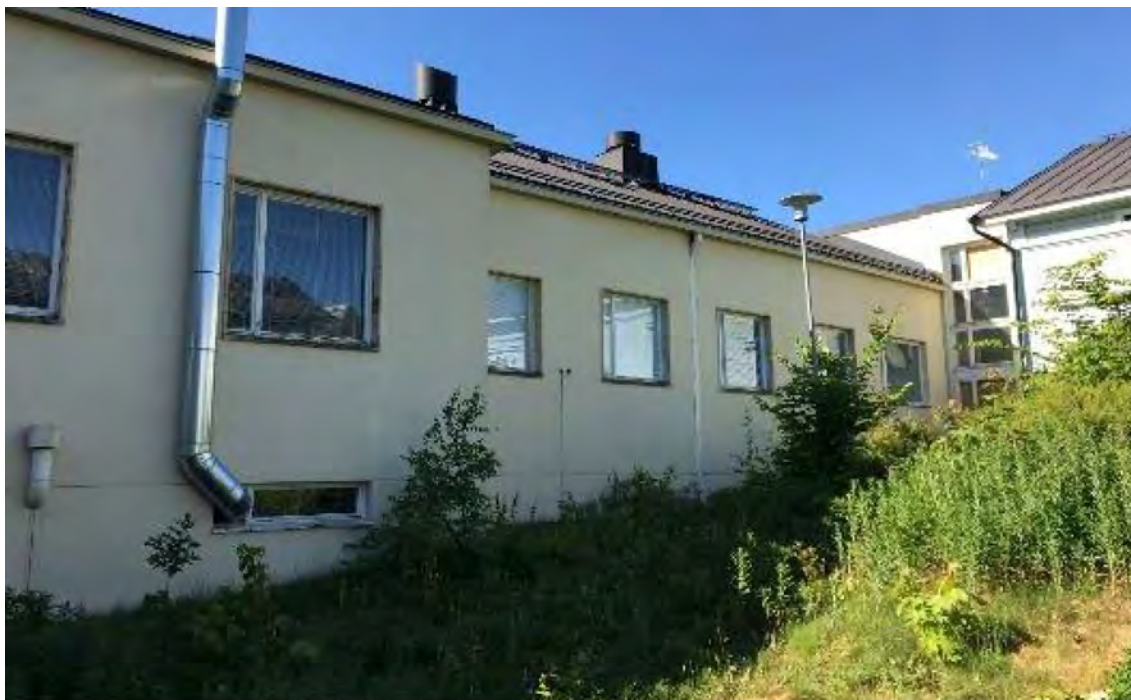
Kuva 2. Yleiskuva A-osasta sisäpihalta.
