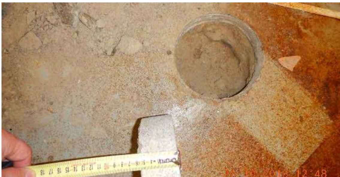
Kuva 21. Vanha alapohja-avaus A3.
