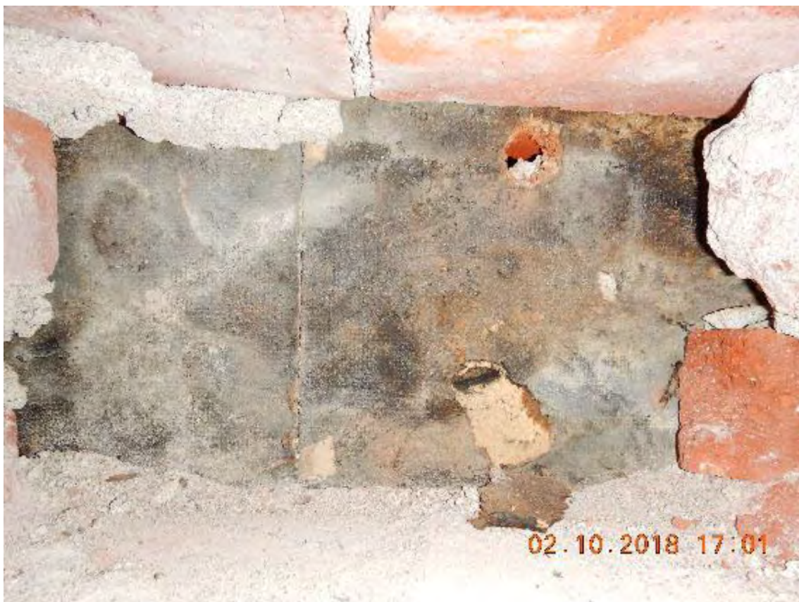
Kuva 12. Maanvastaisen seinän rakenneavaus M03.
