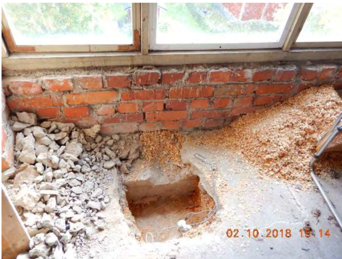
Kuva 59. Yläpohjan rakenneavaus Y4 D-osan päädyssä.
