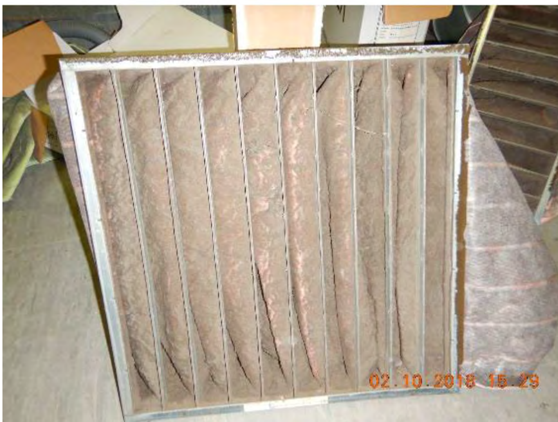
Kuva 67. Suodattimet kaipaavat vaihtamista.
