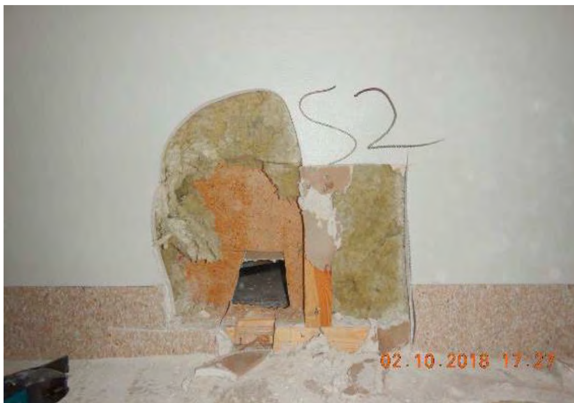
Kuva 64. Rakenneavaus S2 tilojen 1047 ja 1048 väliseen väliseinään.
