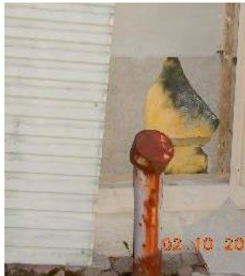
Kuva 24. Ulkoseinäavaus U6 tilassa 2013 ja ulkoseinäavaus U7 ulkoa. Mineraalivilla tummunut.
