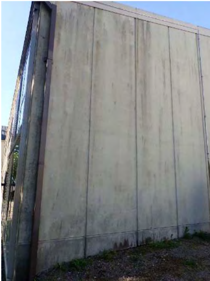
Kuva 30. Päätyseinässä korkeita betonielementtejä.
