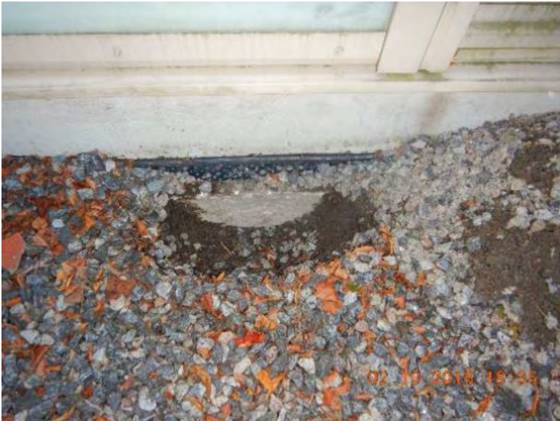
Kuva 4. Sokkelin kaivuun avulla havaittiin patolevy ja EPS-eriste sekä kapillaarinen täyttömaa. Avauspaikka Vänrikinkadun puoleisella pitkällä sivulla.
