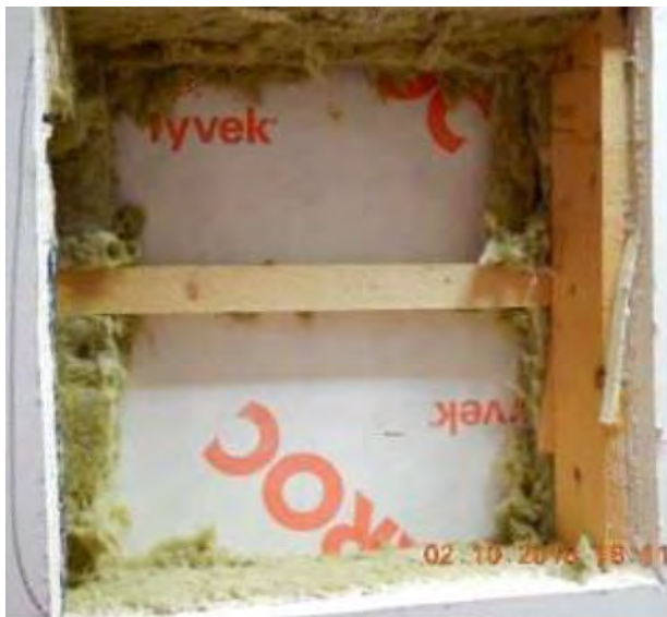
Kuva 24. Ulkoseinäavaus U6 tilassa 2013 ja ulkoseinäavaus U7 ulkoa. Mineraalivilla tummunut.
