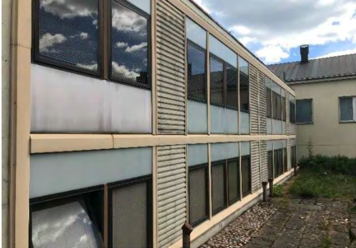
Kuva 2. B-osa sisäpihan puolelta.
