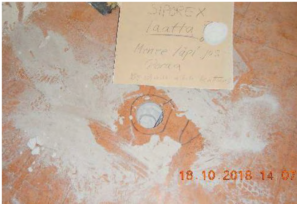
Kuva 19. Välipohja-avaus V11. Rakenne on kiviaineinen pinnoitteita lukuun ottamatta.
