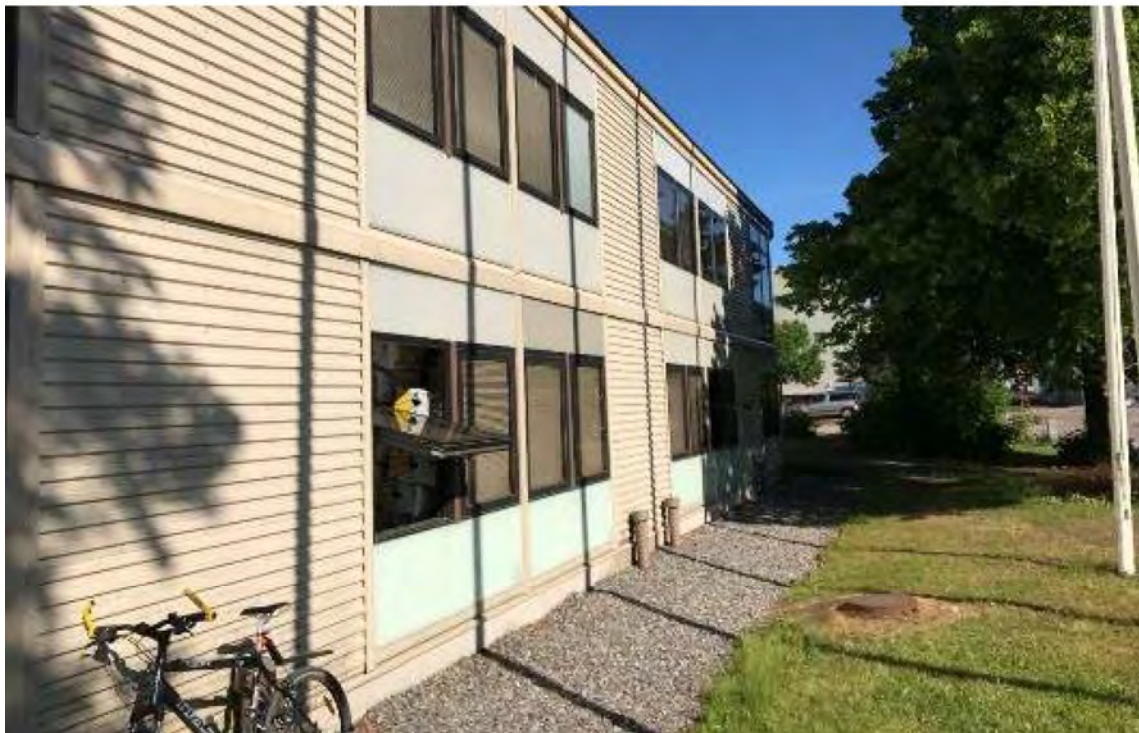
Kuva 3. B-osa kadun puolelta.
