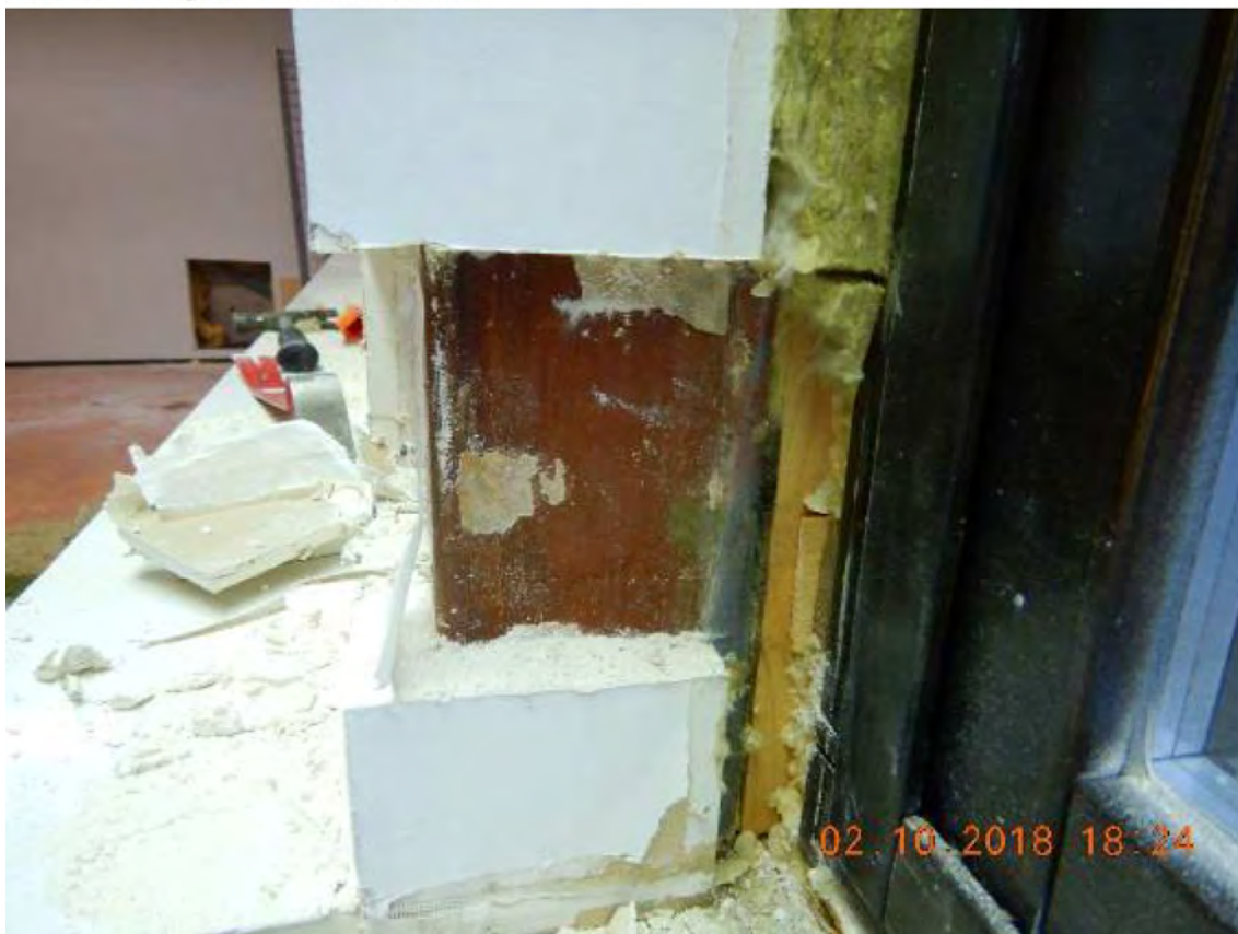
Kuva 35. Teräspalkin takana ohut kaistale mineraalivillaa.
