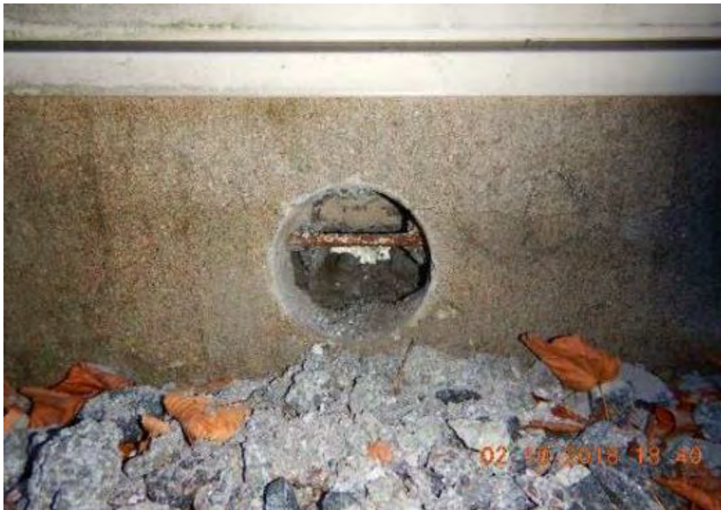
Kuva 7. Sokkeliavaus Sk1. Harkon takana nähtävissä EPS-eriste.
