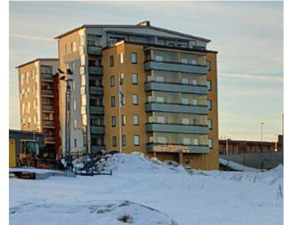
2 Rakenteilla oleva kerrostalohanke
