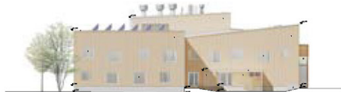
3 Rakenteilla oleva päiväkot Metsätähti
