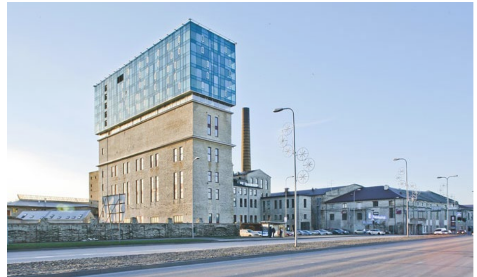
[40] Tallinnassa entinen teollisuusrakennus on muutettu hybridirakennukseksi muuttamalla entisten tilojen fuktio toimisto- ja liiketilaksi sekä korottamalla rakennusta asunto-osuudella.
