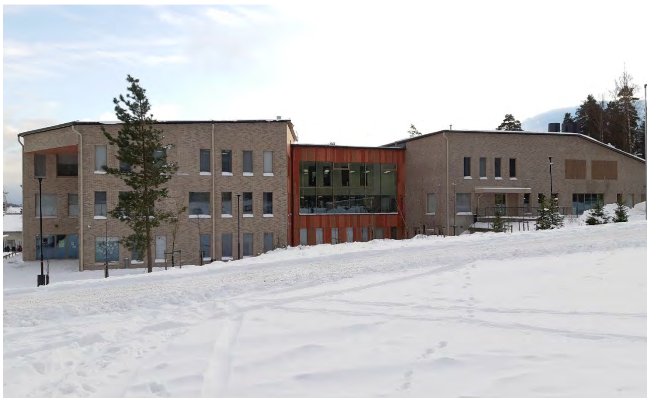
Bild 5 Vyn om planeringsområdet från tomten för den förra Point College, skolbyggnaden Strömborgska skolan. I förgrunden syns gång- och cykelvägen mellan Institutgränd och Pepotvägen'. (Bildkälla: Borgå stad 8.1.2021)
