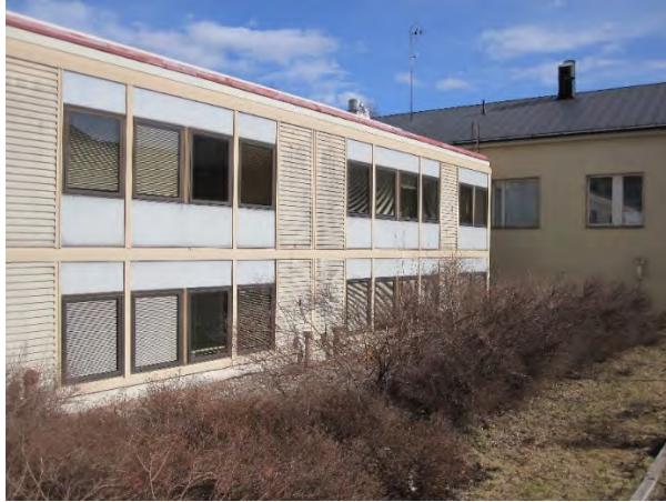
Vuonna 1977 valmistuneen virastotalon laajennuksen julkisivut poikkeavat muusta kokonaisuudesta. Julkisivussa on rakenteellisuutta esiin tuovia konstruktivistisia piirteitä. Ikkunoiden välissä on poimutetut peltilevyt ja ikkunoiden ylä- ja alapuolella muoviset paneelit.
