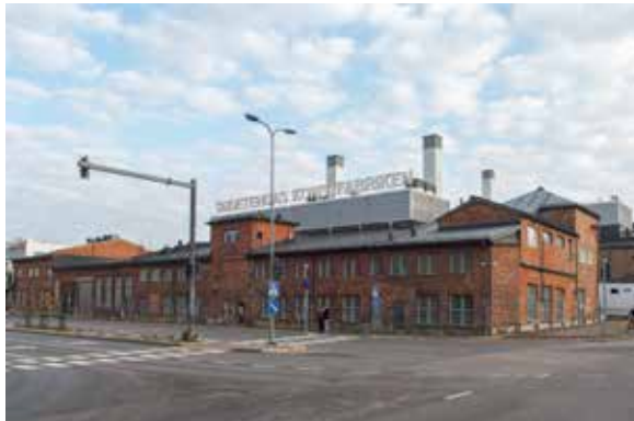
↑ Taidetehdas on kerroksellinen rakennuskokonaisuus, jonka osia on rakennettu 1930-luvulla. Kuvassa näkyvät osat ovat 1900-luvun alkupuolelta. Kokonniementie 6. 1930-luvun laajennuksen suunnittelija ei ole tiedossa.
