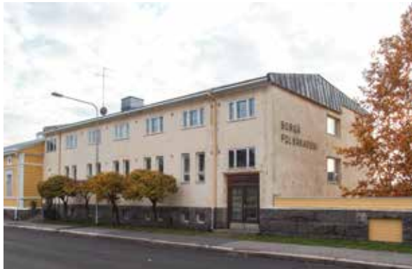
↑ Borgå Folkakademin asuntola osoitteessa Runeberginkatu 16 on sovitettu ympäristön puurakennusten mittakaavaan. Sisäpihan julkisivu on katujulkisivua monimuotoisempi. A. L. Stigell, 1938.
