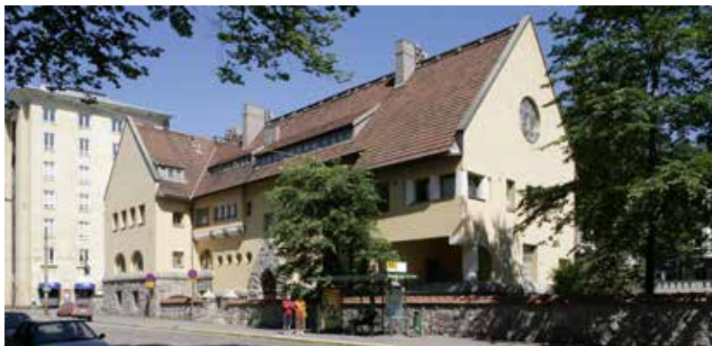
← Lars Sonckin vuonna 1907 valmistunut Eiran sairaala. Ullbergin vaihtoehtoina oli rakennuksen laajentaminen kuvan oikeassa reunassa olevalle tyhjälle tontille tai vanhemman rakennuksen korvaaminen kokonaan uudella rakennuksella. Ark-byroo.
