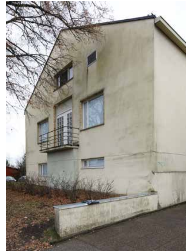
↑ Rakennuksen itäinen päätyjulkisivu. Kellarikerroksen ikkunakokoja on muutettu ja ne ovat nykyisin eri kokoiset. Yläikkunaan ja julkisivuun on lisätty ilmanvaihtosäleikköjä.
