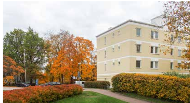
↑ Lundinkadun päädyssä sijaitseva nelikerroksinen asuinkerrostalo on tonttia lähinnä oleva kerrostalo. Lundinkatu 22.
