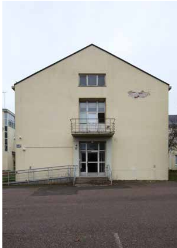
↑ Rakennuksen eteläinen päätyjulkisivu. Parvekkeen alapuolisessa ulokkeessa oleva sisäänkäynti portaineen ja ramppeineen on lisätty vuonna 1971.
