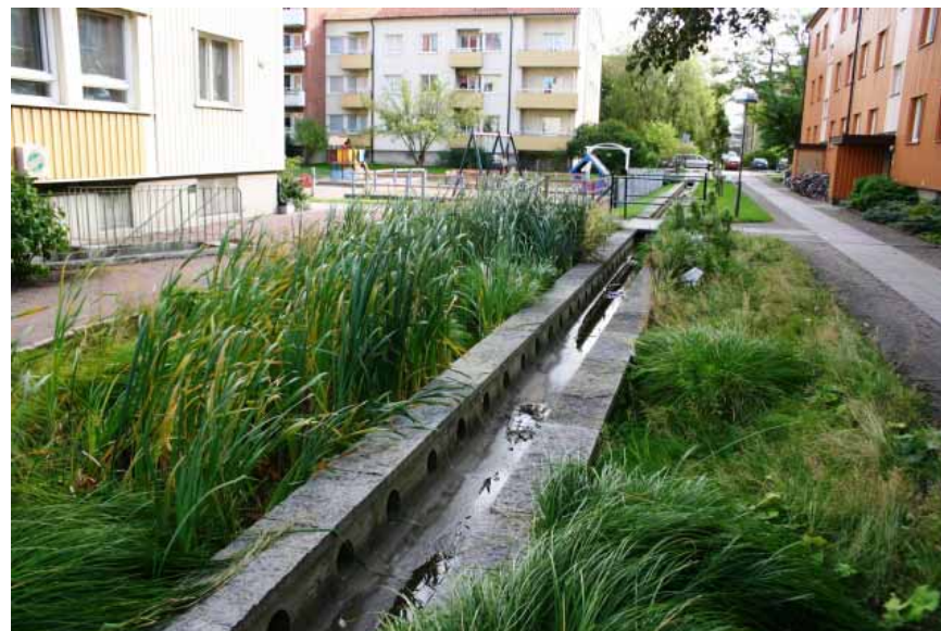
Figur 41: Exempel på en dagvattenkonstruktion som utgör en synlig del i stadsmiljön. (International Sustainable Solutions) http://www.i-sustain.com/learningCenter/photoAlbum/Stormwater/
