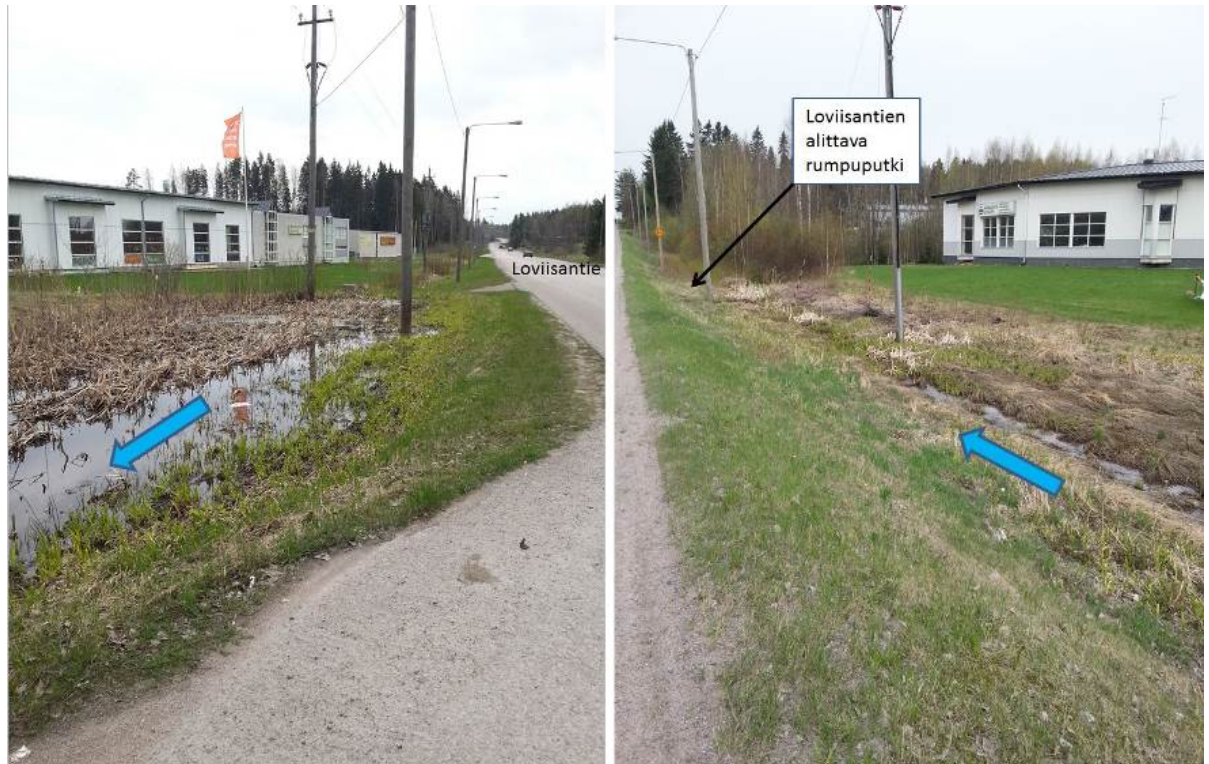
Kuva 1. Loviisiantien pohjoispuolella sijaitsevassa avo-ojassa ei ollut silmämääräisesti havaittavissa selkeää virtausta. Oja alitti Porvoon Sisäkehän rumpuputkessa, jota ei maastokäynnin yhteydessä löydetty. Alituksen jälkeen oja jatkaa matkaa kohti Loviisiantien alitusta.
