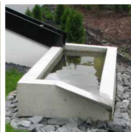
Hulevesien keräämiseen varattu rakenteellinen allas
