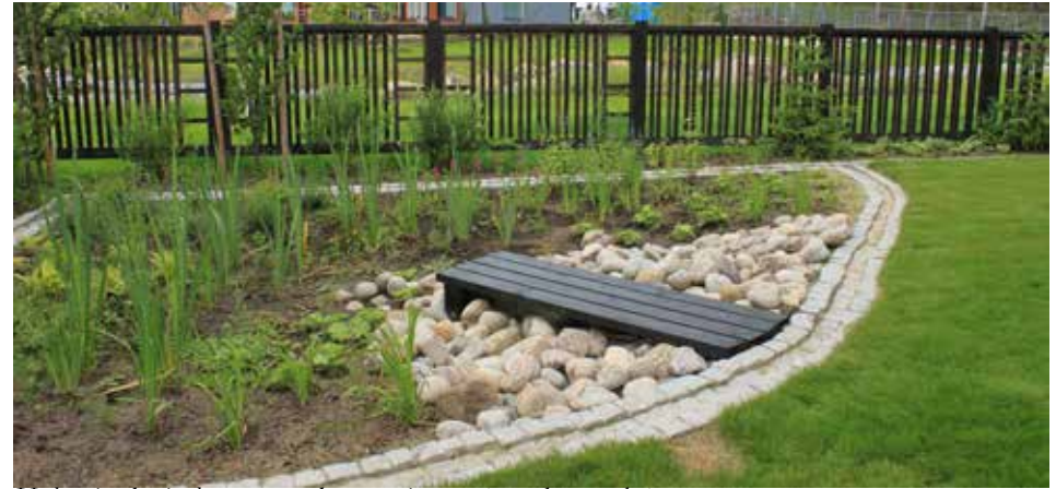
Hulevesien käsittelyä varten rakennettu istutettuja sadepuutarhoja.
