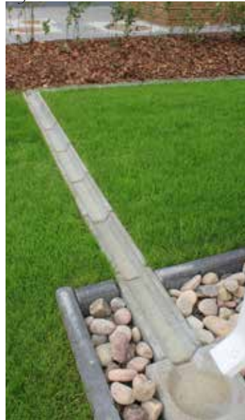
Kattovedet on ohjattu pensasaidan käyttöön.
