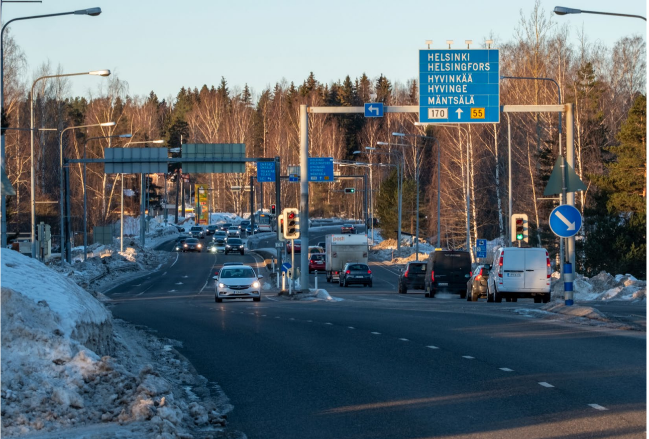
2 Läntinen Mannerheiminväylän tiealue sillalta länteen
