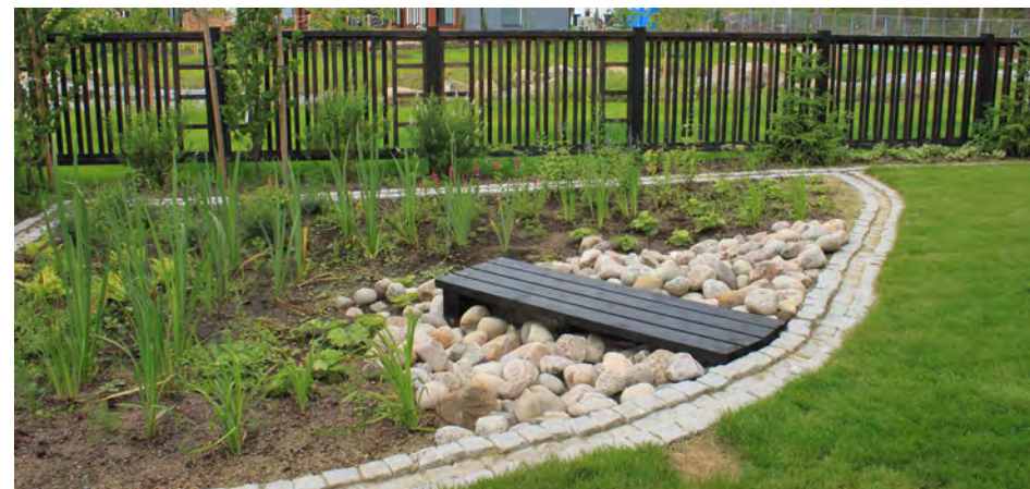
Regnrabatter som planterats för dagvattenbantering.
