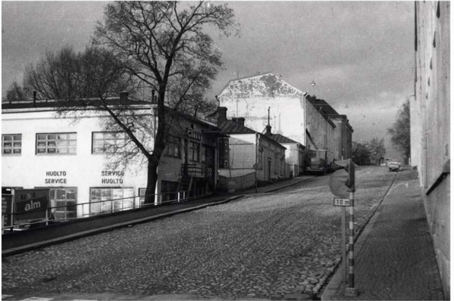
Träkåken rivs, blir parkering, Brunnsgatan 36, december 1975. Christiernin 1975
