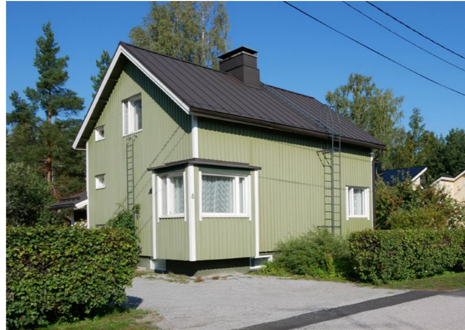
Ett småhus från återuppbyggnadstiden, Pionjärvägen, Pepot(A20). Byggnadens proportioner, lockläktspanelen och hörnfönstret är karakteristiska.
