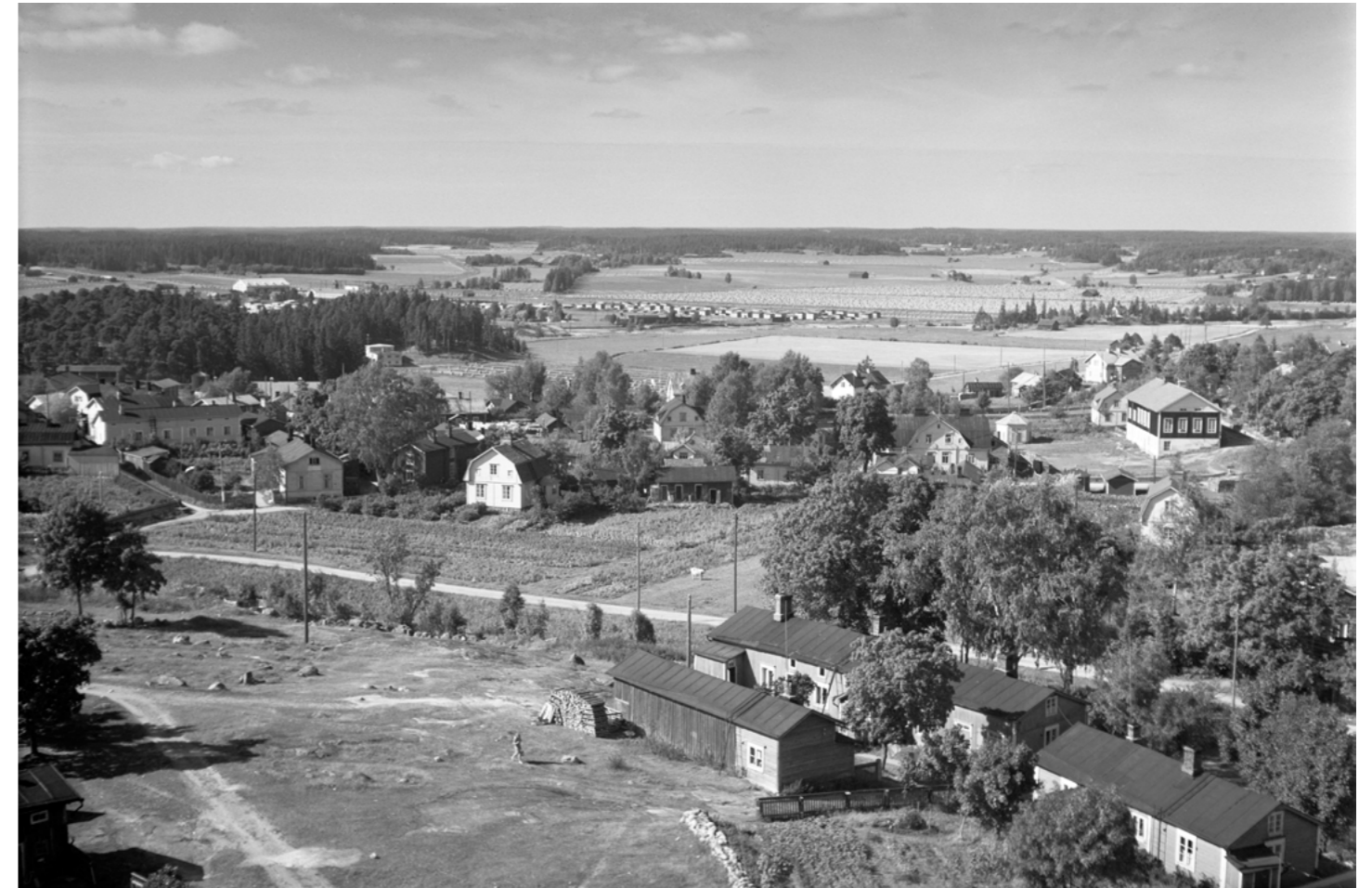
Prästgårdsbackens bosättning, i bakgrunden Hattula såg och Kiala. I förgrunden Utsiktsberget, den nuvarande Tunnbindareparken, och Östra Långgatan, till vänster Tunnbindarebacken, till höger Prästgårdsbackens finskspråkiga folkskola. Bilden är tagen från vattentornet som låg i norra ändan av Linnankoskigatan. Foto Matti Poutvaara, 1946. Museiverket Historiska bildsamlingen.
