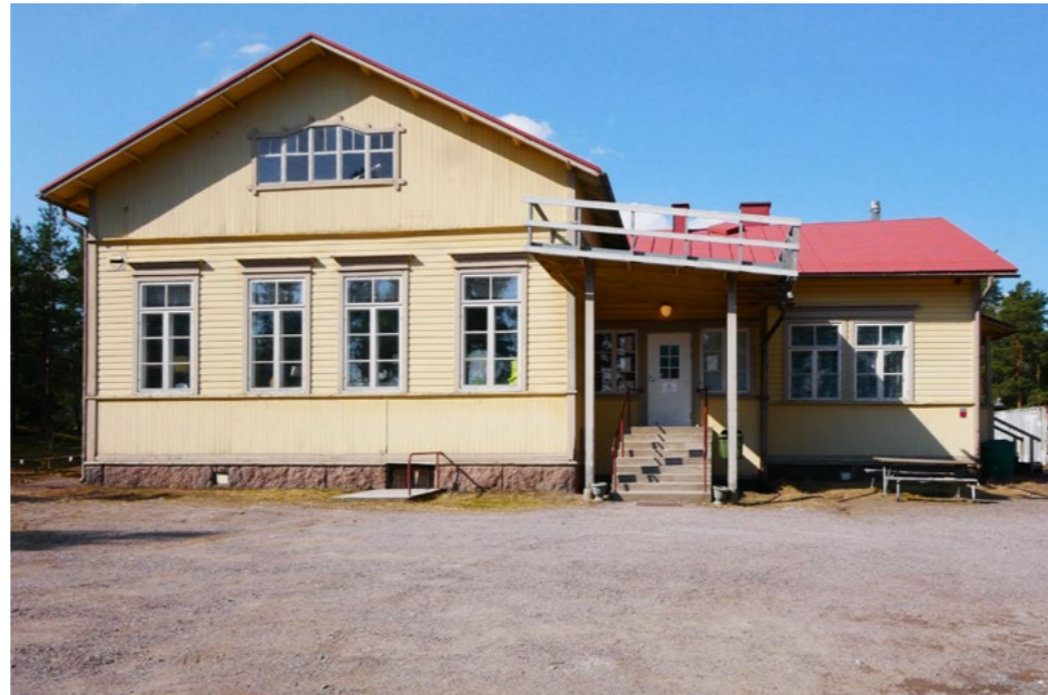
Suomenkylän kansakoulu (119) som byggdes 1908 på en tomt som Bergstad gård hade donerat är den första finskspråkiga skolan i Borgå. I byggnaden som till sitt utseende har bevarats i nästan ursprungligt skick fungerar numera en teater för barn och ungdomar.
