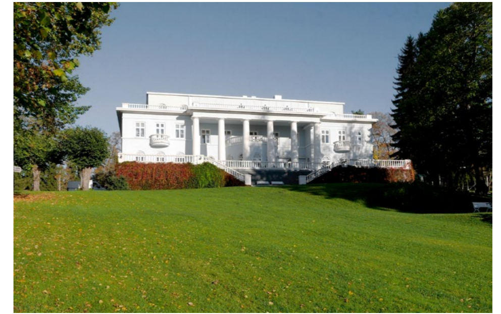
Haiko gårds karaktärsbyggnad (81) är ursprungligen uppförd 1911-1914 enligt ritningar av arkitekt Armas Lindgren. Byggnaden som har ändrats till hotell har utvidgats och förändrats med början på 1960-talet. Till karaktärsbyggnaden ansluter sig ett omfattande parkområde. (A24)
