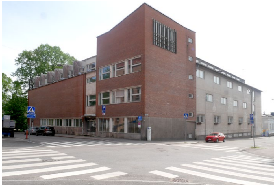
Strömborgska skolan, ett exempel på 1950-talets skolarkitektur i hörnet av Runebergsgatan och Lundagatan. De skolbyggnader som arkitekt Hilding Ekelund planerade hör till de bästa från sin tid.
