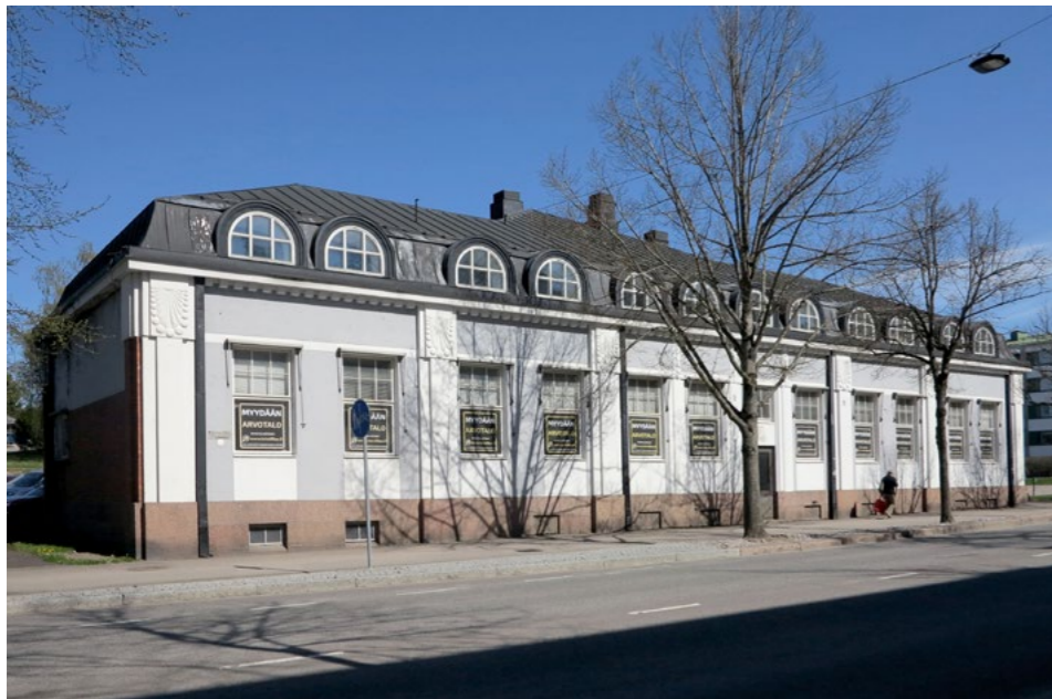
Borgå f.d. elektricitetsverk, Mannerheimgatan 24. Elcentralen och dess kontorshus som ritades av arkitekt Selim A. Lindqvist färdigställdes 1913.
