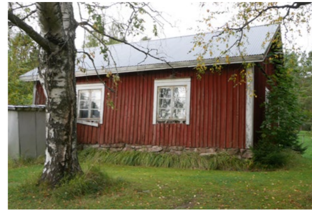
En gammal, mindre backstuga med sockel av natursten, sannolikt byggd på 1800-talet, Stenkulla (114). Fasaderna har gammal, rödmyllad brädfodring med lockläkt, fönstren är 6-rutade..
