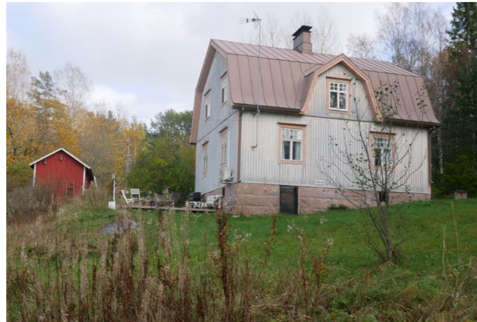
En till sitt yttre väl bevarad bostadsbyggnad från 1930-talet med brutet tak (106). Fasaderna är fodrade med lockläktpanel målad i blågrått, de jugendpräglade fönstren med kittade rutor är ursprungliga, taket är täckt med gammal, falsad bandplåt och sockeln består av kilad sten. (A27)
