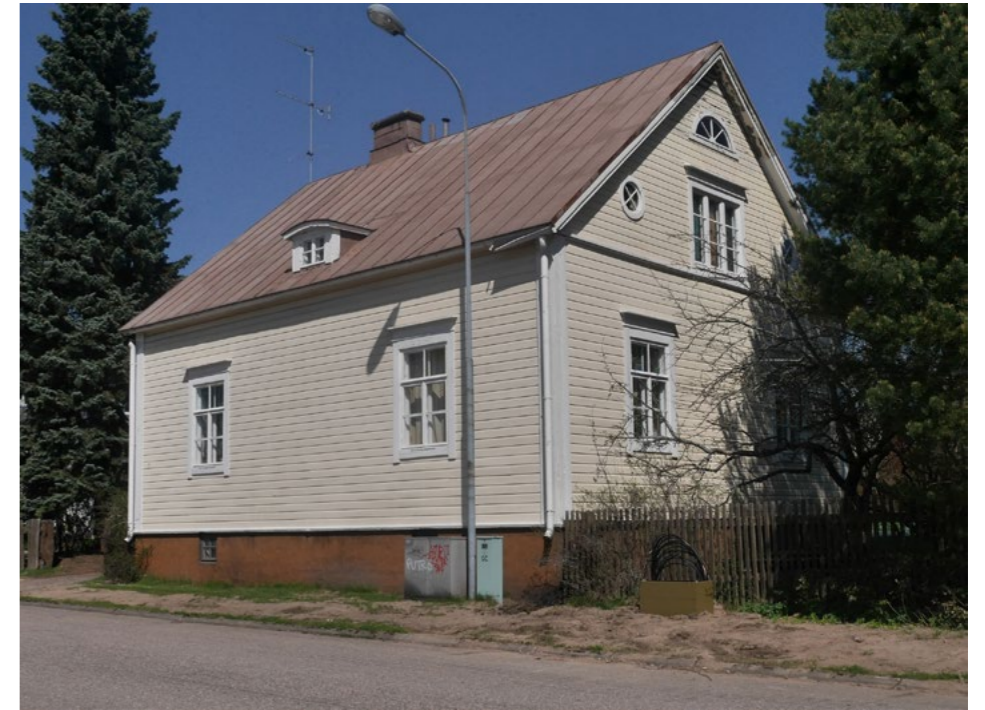
Egnahemshus från 1920-1930-talen har ofta vågrät hålkälspanel och fönstren är indelade i små rutor. Glasen är kittade och fönsterspröjsarna är tunna.
