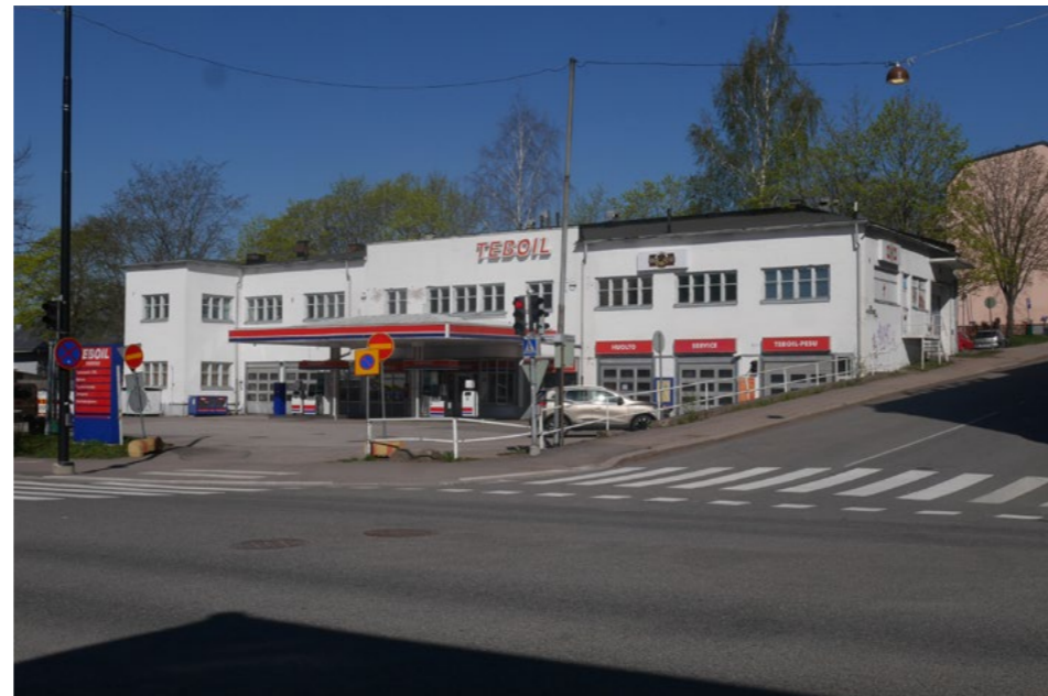
Den modernistiska servicestationen från 1938 vid Mannerheimgatan, ritad av J. Brander.
