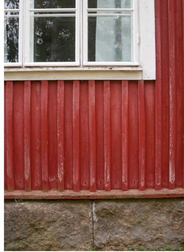
Kvaderstenssockel, locklättspanel och fönster med tät spröjsindelning är kännetecknande för 1920-talets byggnadsskick.
