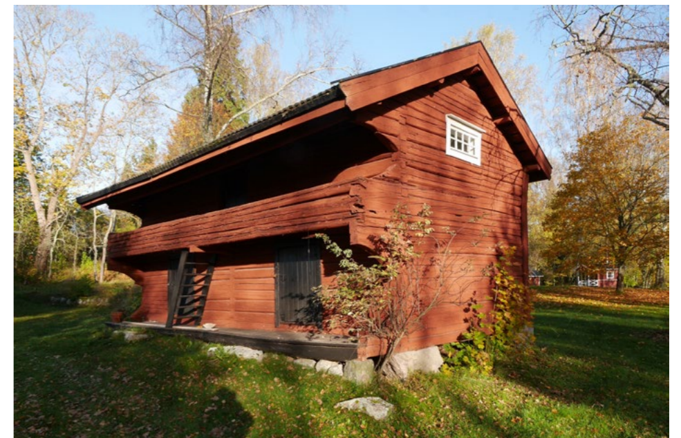
Loftboden på Brasas gårdsområde (7) med långa knutar och tak med längsgående åsar.
