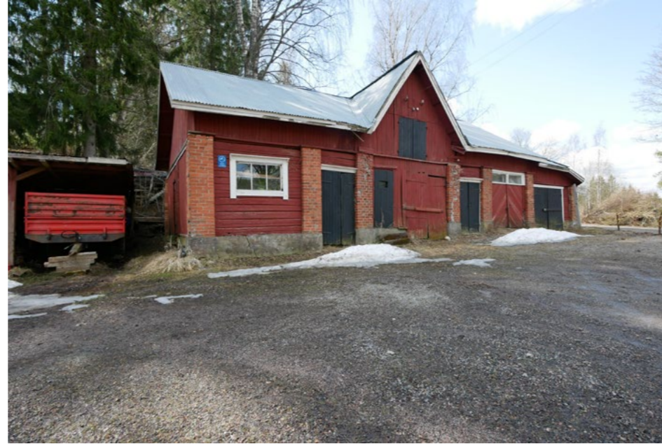
Kombination av tegelpelare och träkonstruktion i en ekonomibyggnad på ett jordbruk (123)
