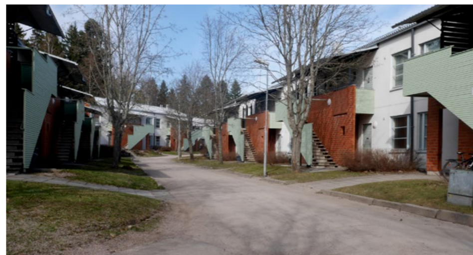
Bostadsstiftelsen var byggherre för bostadsrättsområdet Ritarikannus (Riddarsporren), byggt 1994 enligt ritningar av Arkitektbyrå Helin& Siitonen (A14)
