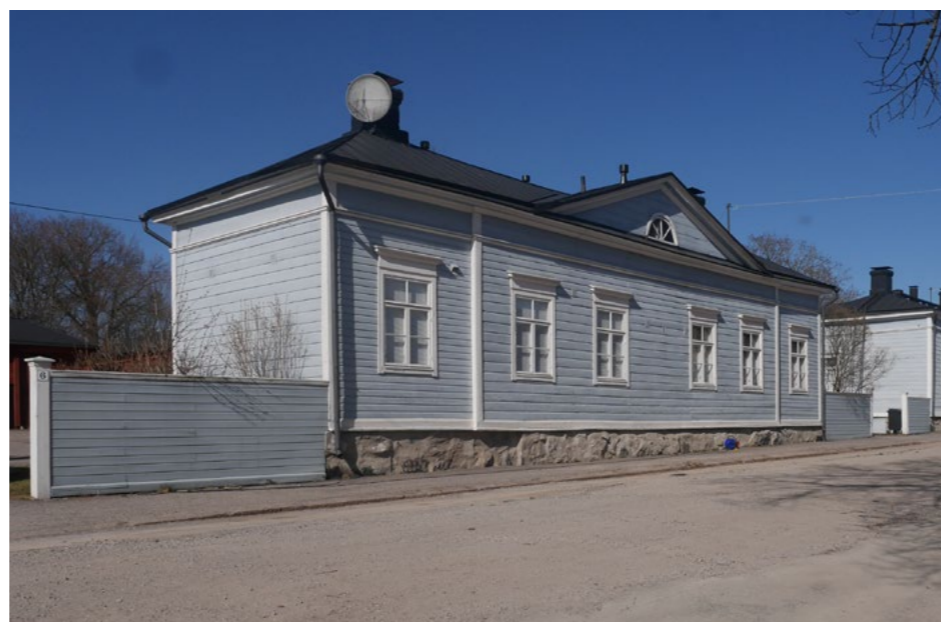
Den karakteristiska utvändiga brädfodringen på de äldre byggnaderna i empirekvarteren i Borgå är en bred, vågrät spontad brädpanel.
