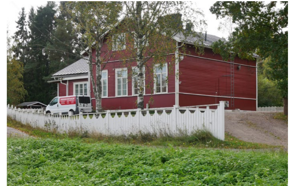
Den vid Finnbyvägen uppförda, svenskspråkiga Finnby folkskola (120) är byggd som en spegelbild av den närbelägna Suomenkylän kansakoulu. Efter år 1973 fungerade byggnaden först som daghem, numera är den i bostadsbruk.
