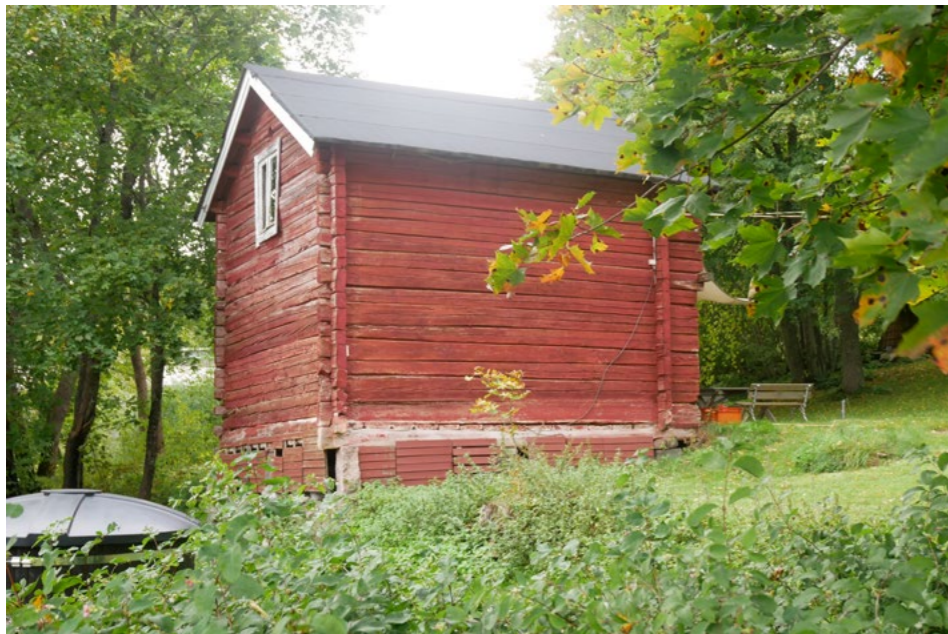
I den parkliknade gårdsmiljön på Staffas (130) finns en bevarad, hög knuttimrad bod med långa knutar och tak med längsgående åsar.
