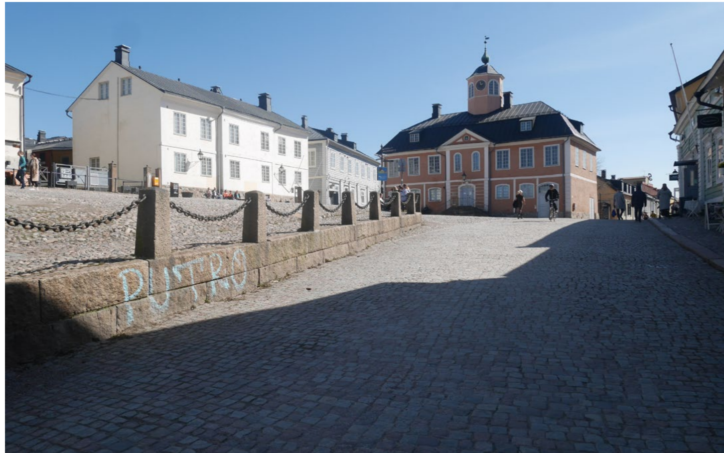
Det av byggmästaren Gotthard Flensburg uppförda rådhuset från 1760-talet, numera museum, är vid sidan om rådhuset i Raumo en av de äldsta bevarade rådhusbyggnaderna i Finland.
