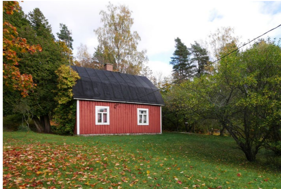
Fridhem, en f.d. backstuga på Bryggars hemman (97) är ett till sitt yttre väl bevarat boningshus med brutet tak, uppfört i början av 1900-talet och synligt beläget i landskapet.
