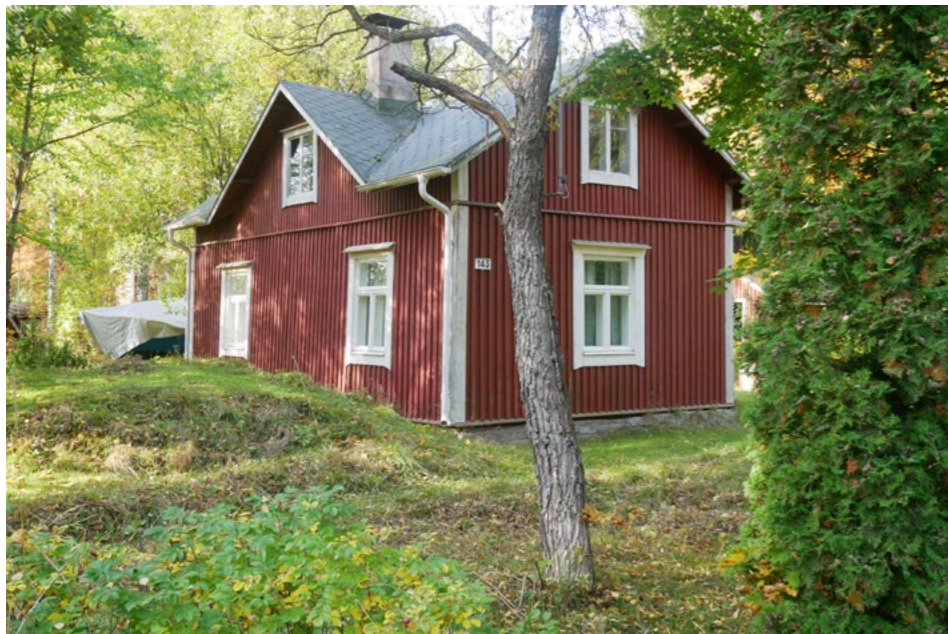
En på 1920-talet uppförd bostadsbyggnad med sadeltak och fronton i Nedre Sillvik (28). Fasaderna har röd stående bräd-fodring med lockläkt.
