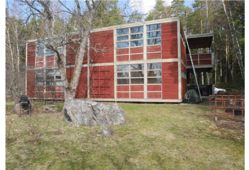
Ett exempel på modern träarkitektur från 1960-1970-talen, byggd med modulstomme, Finnby (36).
