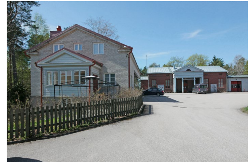
Det på 1930-talet byggda f.d. slakteriets gårdsområde (115), Mästarvägen 2, numera Borgå vatten. Den klassicistiska byggnadsgruppen har enligt huvudritningarna planerats av A. Karls.
