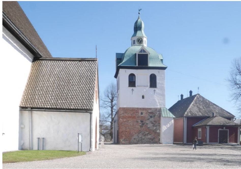
Klockstapeln och den 1739-1747 byggda kyrkobyggnaden av trä, som tidigare har använts av den finskspråkiga församlingen.
