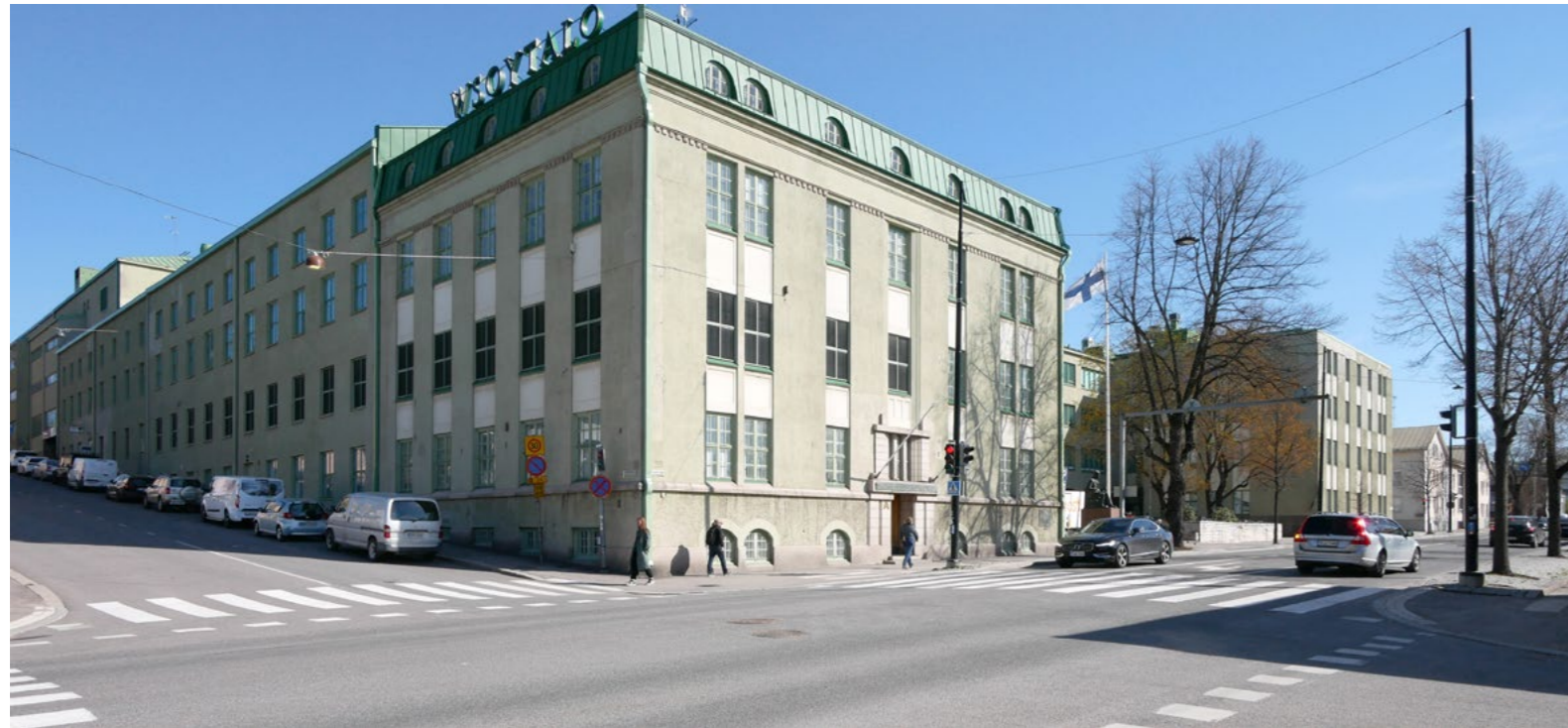
Werner Söderström OY:s tryckeri vid Mannerheimgatan är en särskilt karakteristisk byggnad för Borgå. Byggnads- och tillbyggnadsskedena sträcker sig från år 1898 till år 1969. Tillbyggnaden i hörnet av Mannerheimgatan och Brunngatan är ritad av arkitekt Georg Schreck.
