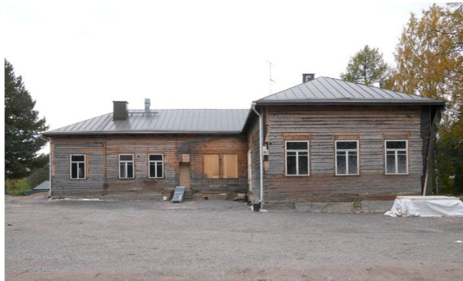
Svartså skola (14), en f.d. skolbyggnad från 1890-talet med L-formad plan och valmat tak. Bilden är tagen medan en renovering pågick, och stockstommens utvändiga brädfodring hade därför avlägsnats.
