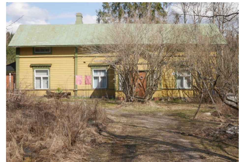
Den väl bevarade huvudbyggnaden på Sexmans, som ligger intill byvägen, är byggd i mitten av 1800-talet och av parstugetyyp (123).
