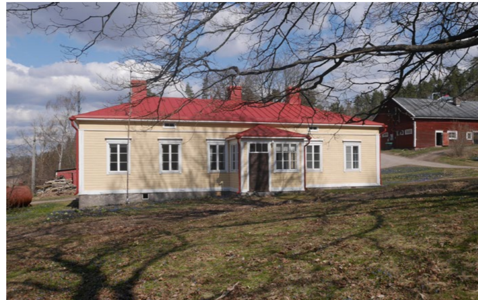
Kallolas tidigare karaktärsbyggnad, som generallöjtnant von Ammondt hade låtit bygga, brann 1931, lämningar av stenfonten finns kvar i den västra delen av gårdsområdet. Den nuvarande huvudbyggnaden (127) är ett boningshus från 1800-talet, byggt i en våning med valmtak. (A34c)
