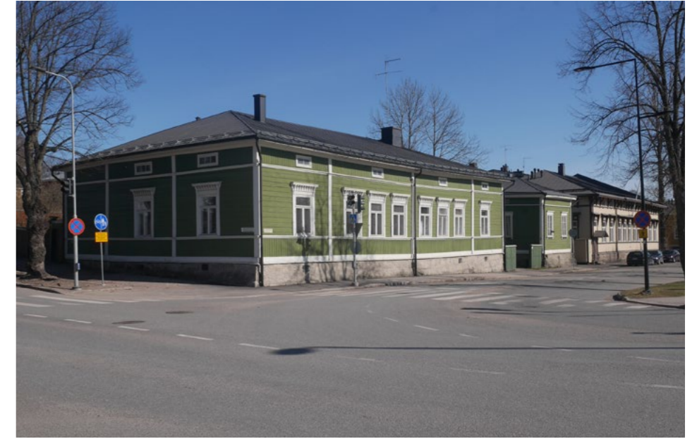
Empirestadens fasad mot östra åstranden, Ågatan 19 och 17. Den grönmalade byggnaden är från 1849. Till höger syns en nyrenässansfasad ritad av arkitekt Theodor Höjjer.
