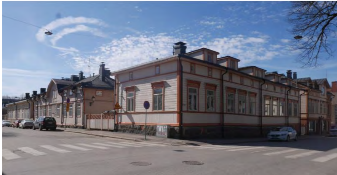
I hörnet av Stadshusgatan och Brunngatan står ett bostadshus från år 1843 med drag från empire och nyrenässans. Byggnaden har planerats av arkitekt G. Westerberg.
