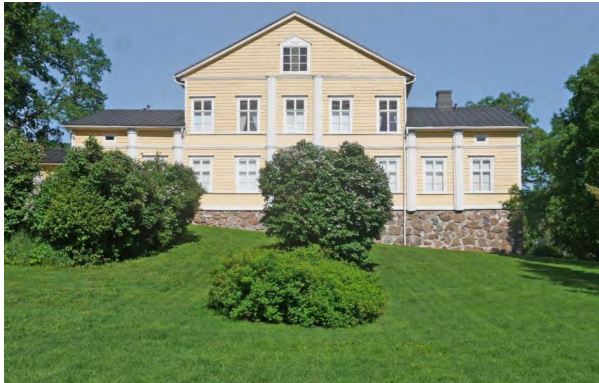
Karaktärsbyggnaden med sina doriska halvpilastrar är byggd enligt arkitekt Pehr Granstedts ritningar på 1810-talet.
