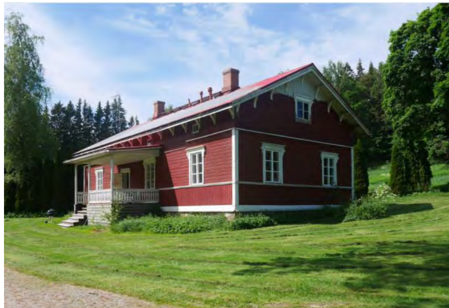
Bostadsbyggnad på norra sidan av gården.
