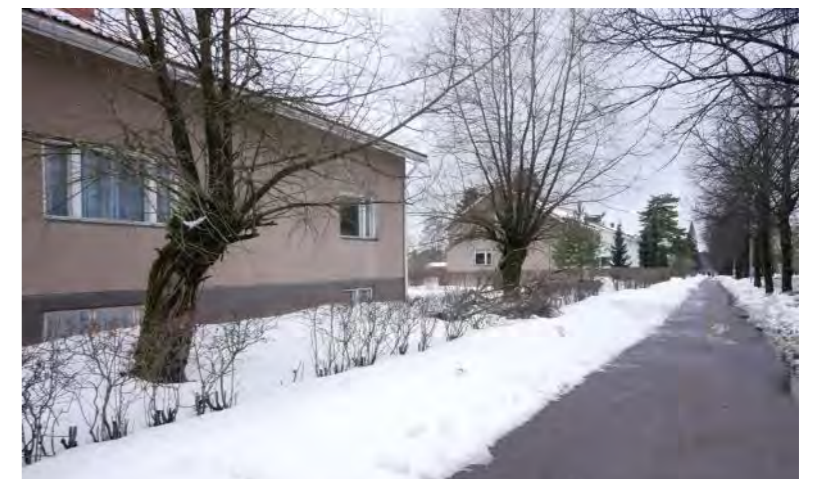
Wittenbergsgatan kantas av putsade småhus från 1950-talets början. De klippta häckarna samt träden inne på tomterna och trädplanteringarna vid gatorna har en viktig roll i stadsbilden.
