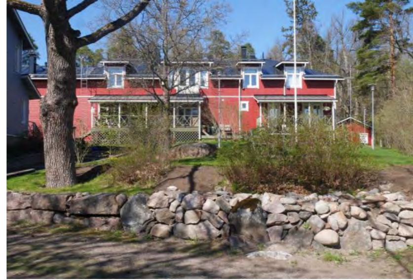
Borgå kritfabriks byggnad har ombyggt till bostäder.
