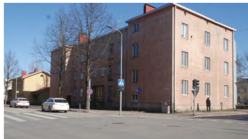
Det putsade våningshuset från år 1932 vid Alexandersgatan, planerad av arkitekt Hilding Ekelund, har drag av funktionalismen och 1920-talsklassicismen.
