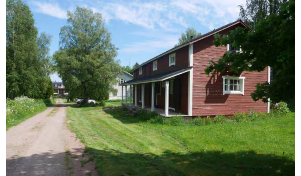
Ekonomibyggnad på gårdens södra sida.
