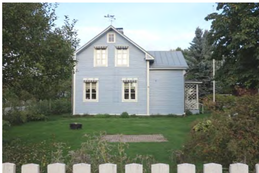
Villa från 1900-talets början vid Jackarbygatan.
