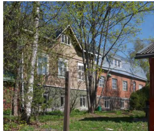
Äldre tegelbyggnad Vid Östravägen som är sammanbyggd med en trävilla från 1900-talets början.
