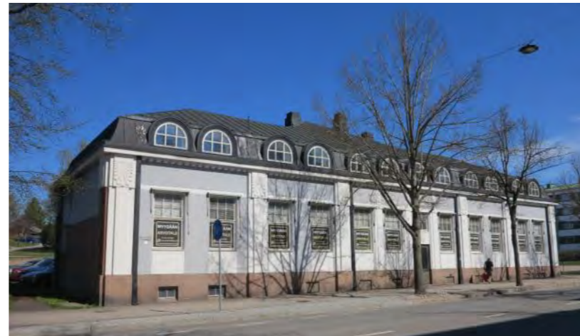
Borgå Energis hus vid Mannerheimgatan är skyddat med detaljplan.
