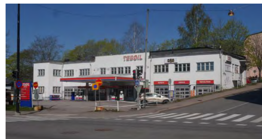
Den vid Mannerheimgatan belägna bensinstationen med funkisdrag från år 1938 och är planerad av J. Brander
