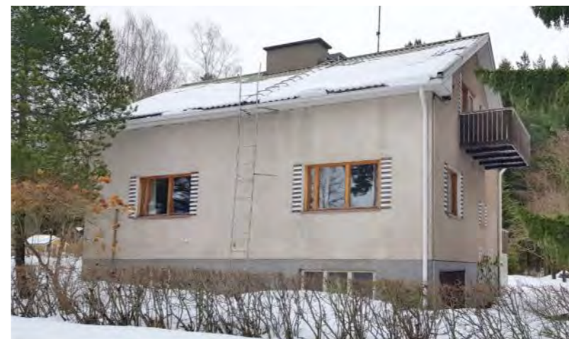
Fönsterkanterna på småhuset vid Skyttegatan är markerade med keramiska plattor.
