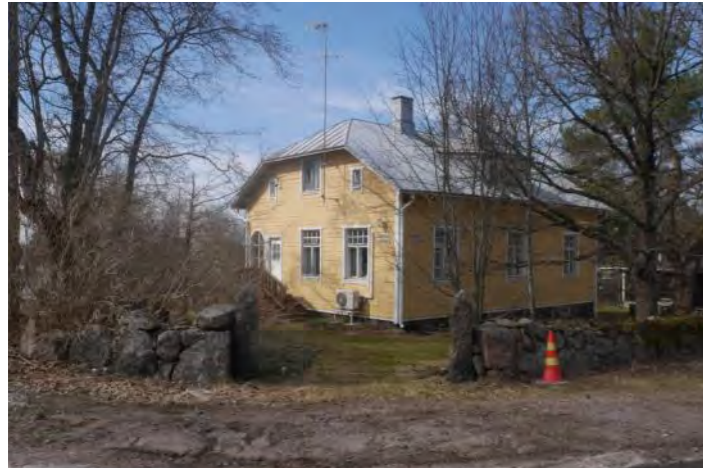
Exempel av bosättningen på Prästgårdsbacken från 1800-talets slut och 1900-talets början.
