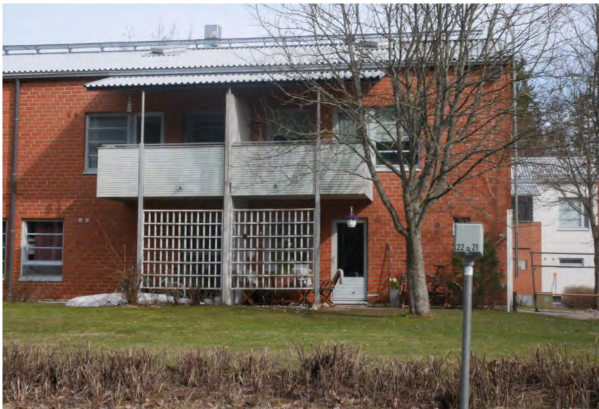
De utåtvända kvartersfasaderna är av rödtegel. I arkitekturen upprepas för tidsperioden typiska detaljer som bl.a. spjälverk av trä och vågrätt uppdelade fönster med pastellfärgade karmar.
