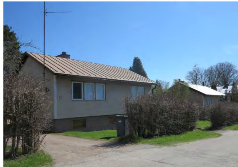
Byggnaderna är placerade med långsidan mot gatan.
