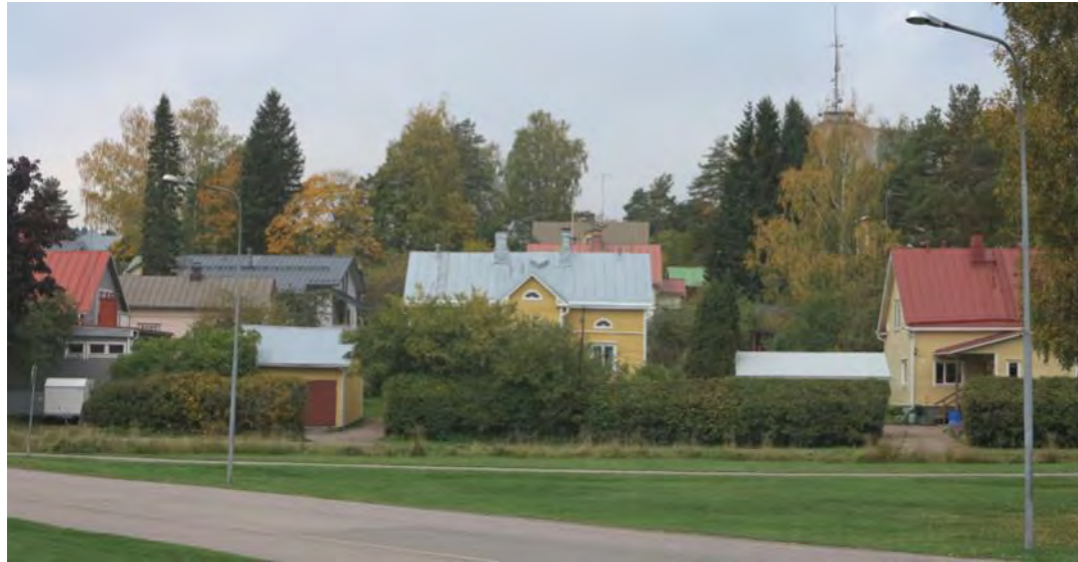
P.g.a. topografin framträder byggnaderna i slutningen som en mångskiftad och tät-bebyggd stadshelhet.
