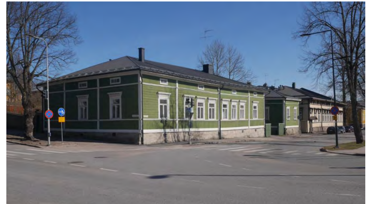
Bostadshuset i hörnet av Alexandersgatan och Ågatan är från år 1851.
