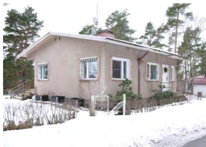
Egnahemshus från 1950-talet med putsad fasad.
