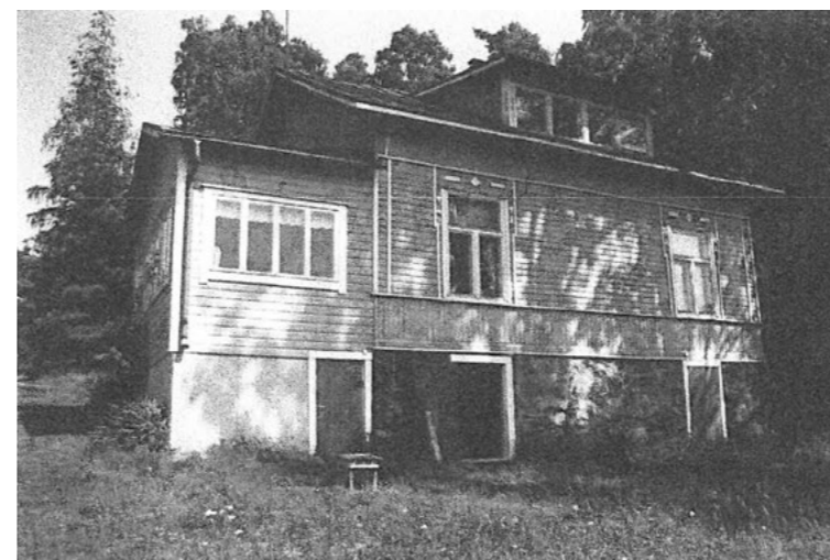
Fasaden mot stranden före 2000-talets förändringar. Inventeringsfoto Vara, Virkki 1999.
