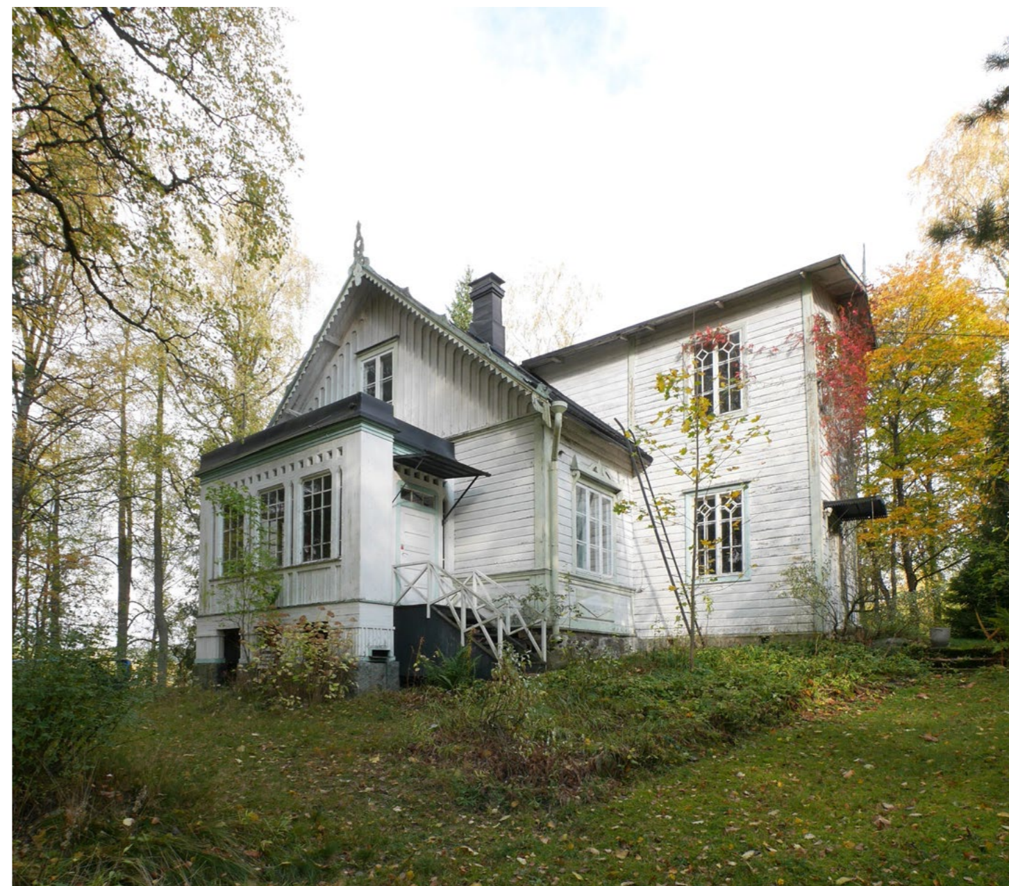
Vy från sydväst. Huvudvolymen med sadeltak och tvärgavel har byggts ut mot väster med en glasveranda och i riktning mot skogen med en hög tillbyggnad med smal stomme på den södra sidan.
