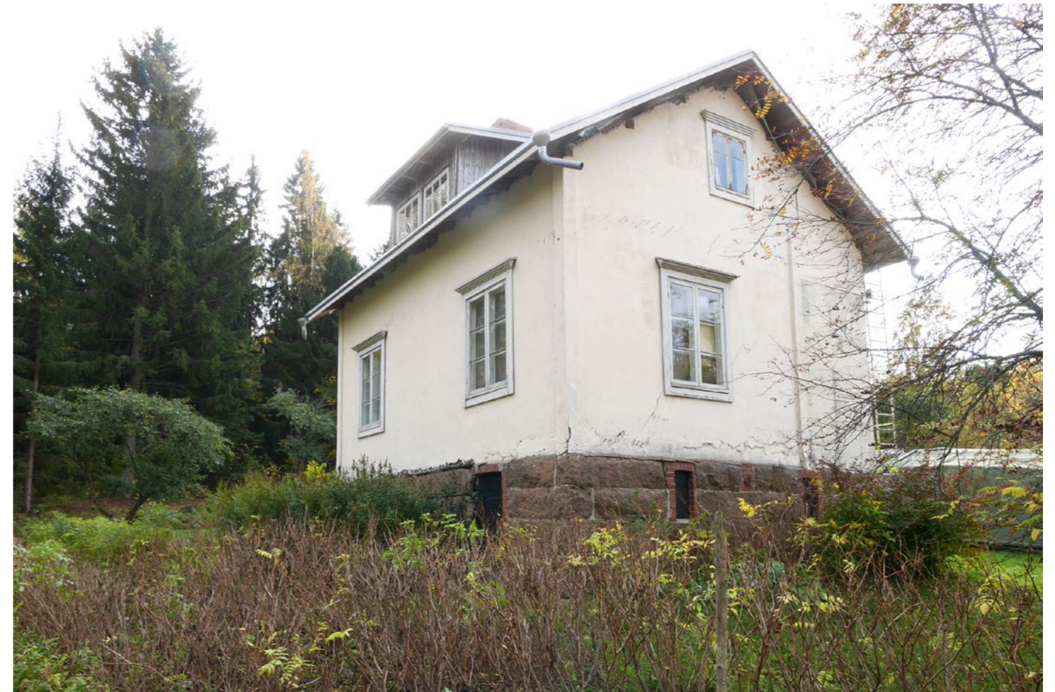
Den putsade ekonomibyggnaden. Källarens fasader är murade av regelbundna kvaderstenblock.
