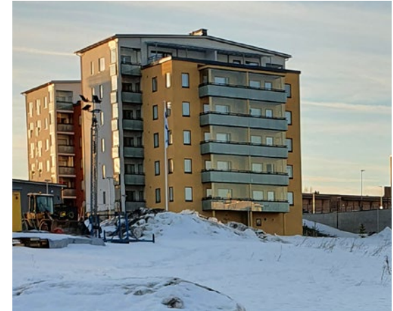
2 Rakenteilla oleva kerrostalohanke
