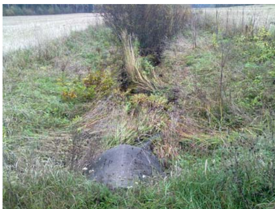
c) Alue D, keskialue, puron ylittävän tien rumpu ja vesi hieman maanpinnan alapuolella
