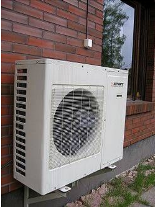
Kuva 8 Ilmalämpöpumpun ulkoilmayksikkö
