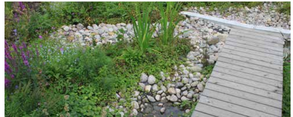
Hulevesien käsittelyä varten rakennettu istutettuja sadepuutarhoja.
