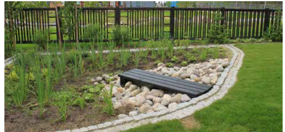
Hulevesien käsittelyä varten rakennettu istutettuja sadepuutarhoja.
