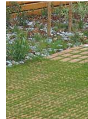
Stenbeläggning med gräs på parkeringsplatsen. Vattnet som rinner ut längs med ytan leds till växterna vid kanten.
