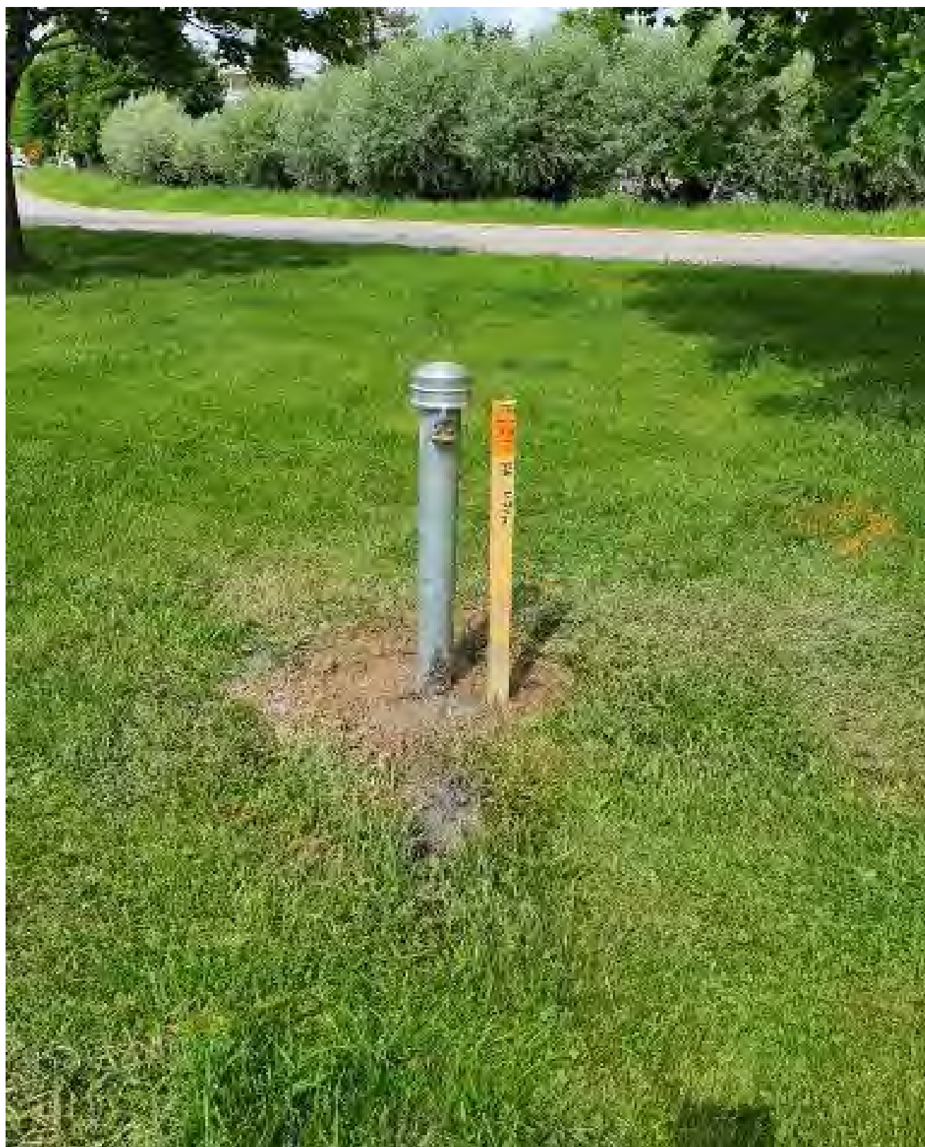
Valokuva putkesta (asennuksen jälkeen)
