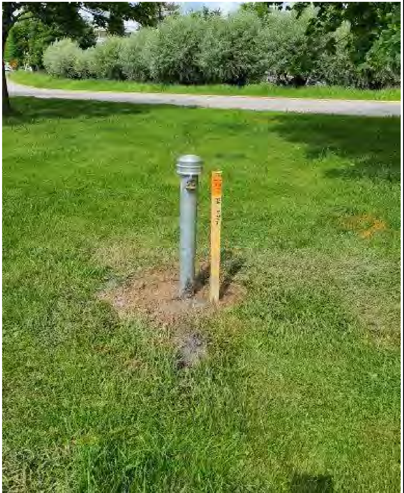
Valokuva putkesta (asennuksen jälkeen)
