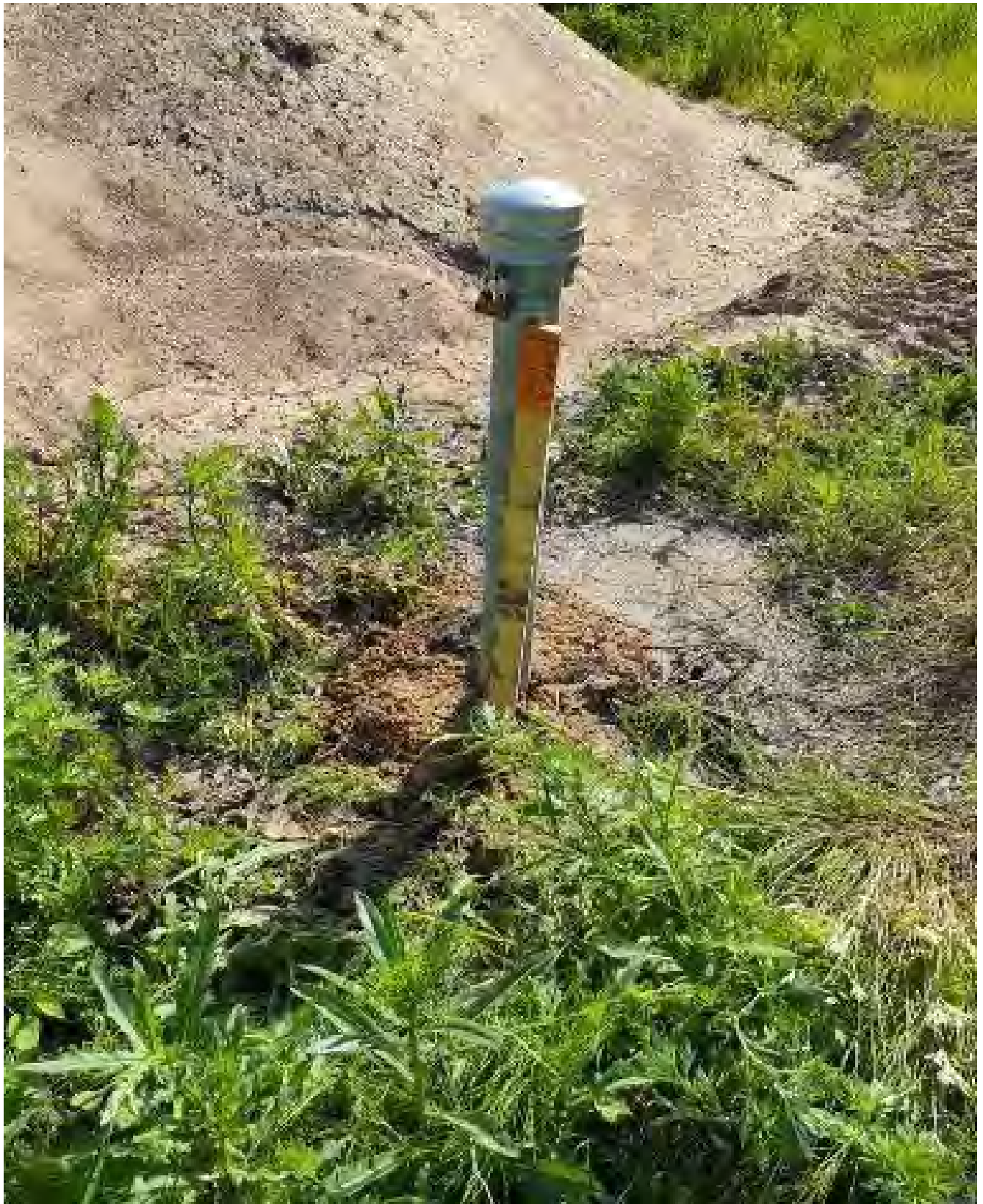
Valokuva putkesta (asennuksen jälkeen)
