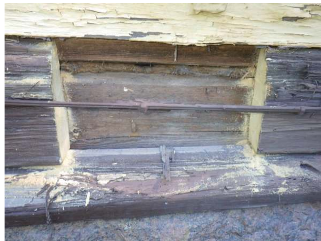
22. Tien puoleisissa avauksissa ei havaittu hirren osalla vaurioita
