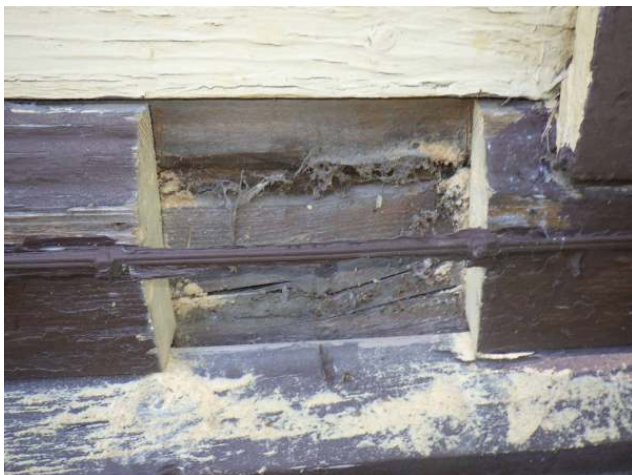
21. Tien puoleisissa avauksissa ei havaittu hirren osalla vaurioita
