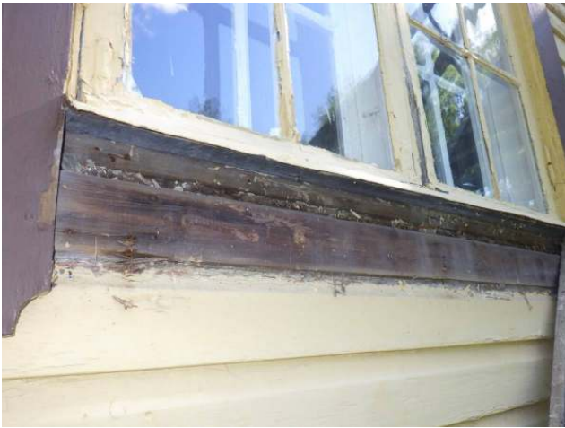
23. Ikkunan alta poistettiin laudoitusta
