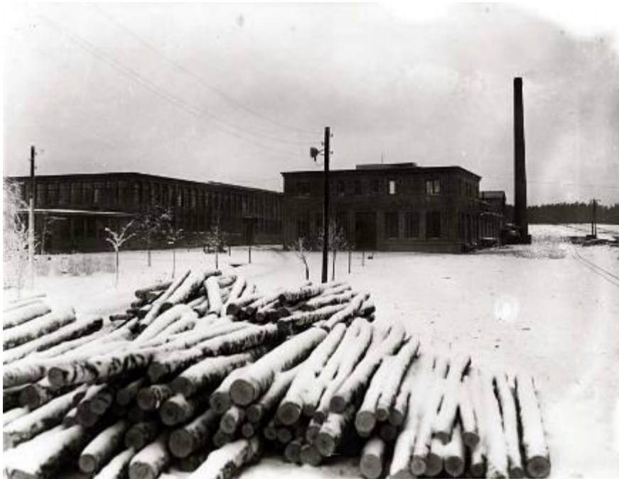
Fabriken avbildad från östra sidan 1937. Till höger tillbyggnaden som omfattade verkstads- och bostadslokaler. Till vänster den påbyggda fanerfabriken och den flygel som fanns i östra gaveln med bl.a. fabrikskontoret som numera rivits. Hjalmar Lindfors, Borgå museum.
