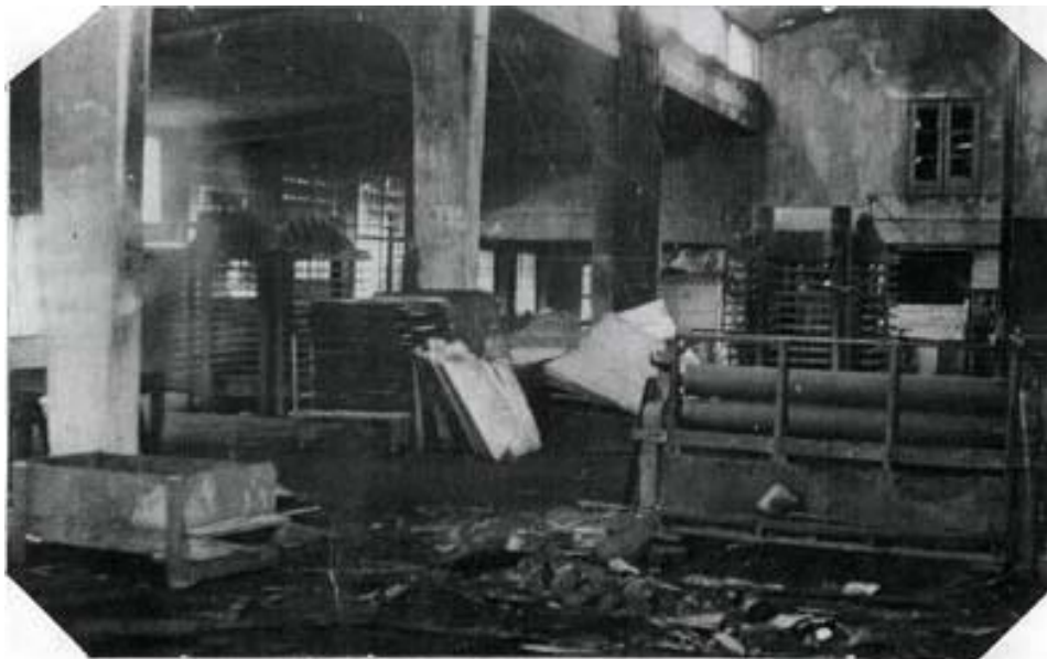
Fabrikssalen efter branden. Hjalmar Lindfors 7.1.1936, Industri-Brand, ELKA.
