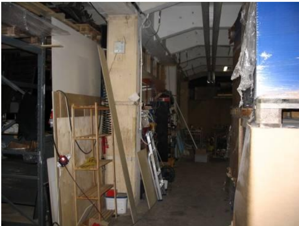
Den tidigare fanersalens (102) mellanbottenkonstruktioner av betong finns kvar, men det är ställvis svårt att skapa sig en bild av själva utrymmet. Henrik Wager 2008, Borgå museum.
