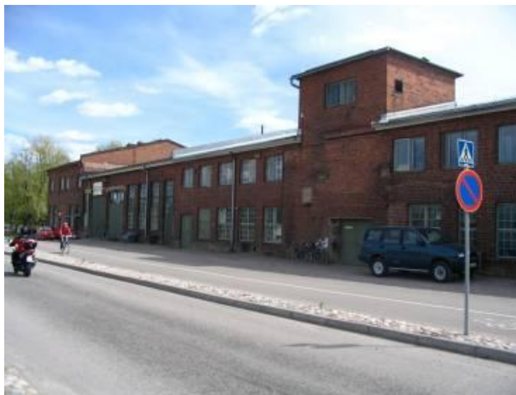
Den nuvarande konstfabrikens norra flygels fasad mot norr är i huvudsak från 1940-talet. Fasaden domineras av hisstornet som byggts 1941. Henrik Wager. Borgå museum.
