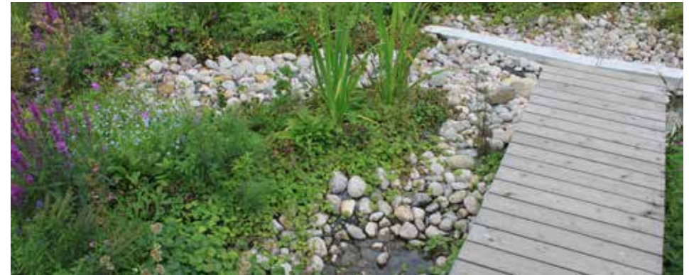
Hulevesien keräämiseen varattu rakenteellinen allas
