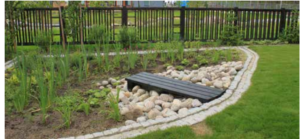
Hulevesien käsittelyä varten rakennettu istutettuja sadepuutarhoja.
