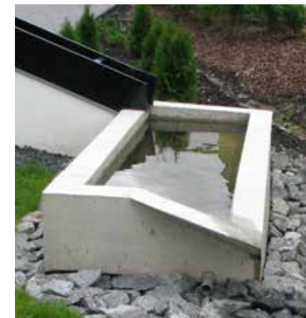
Hulevesien keräämiseen varattu rakenteellinen allas
