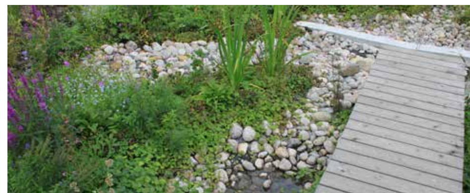
Regnrabatter som planterats för dagvattenhantering.
