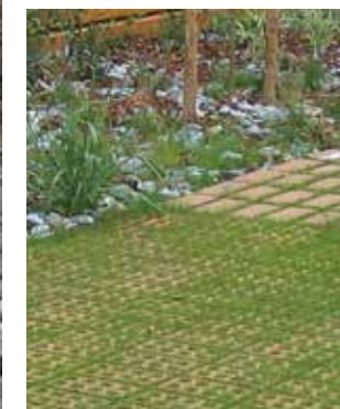
Stenbeläggning med gräs på parkeringsplatsen. Vattnet som rinner ut längs med ytan leds till växterna vid kanten.
