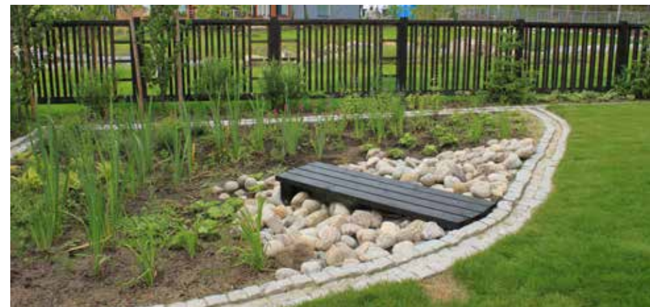
Regnrabatter som planterats för dagvattenhantering.
