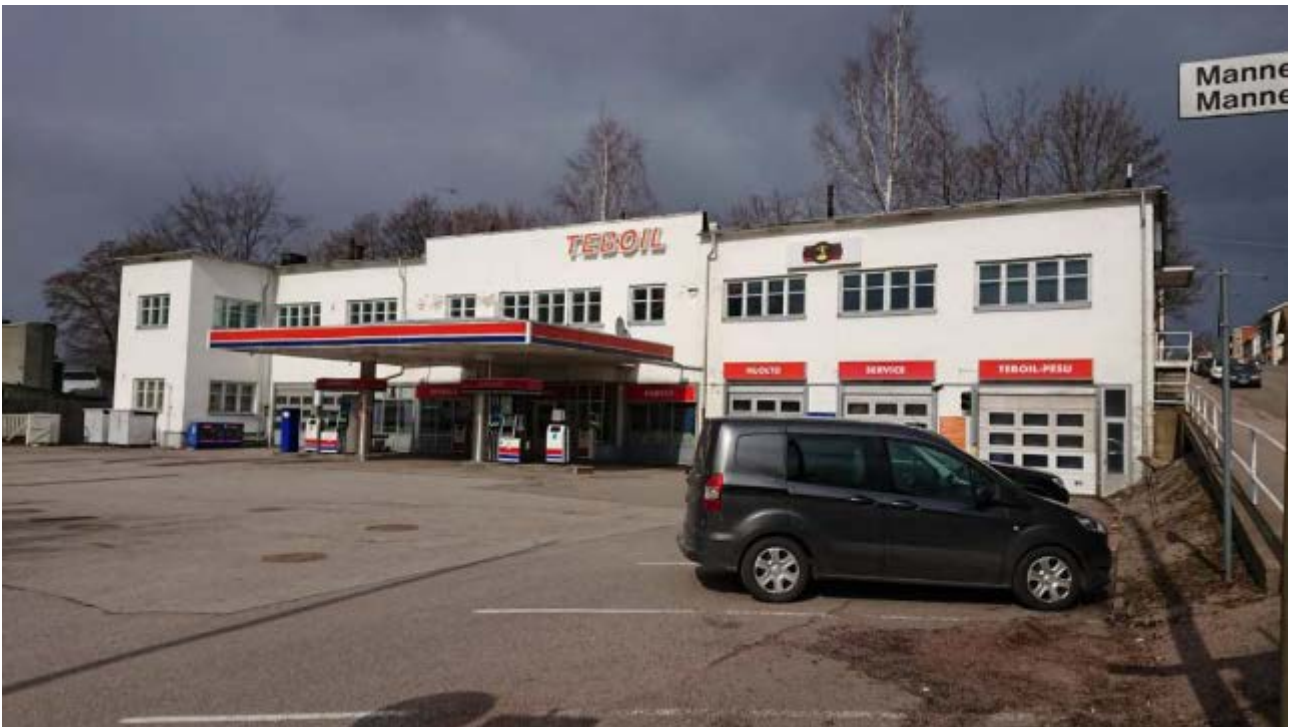
Näkymä huoltoaseman pihalle vuonna 2019 Mannerheiminkadun ja Kaivokadun risteyksestä. Lähde: rakennushistoriaselvitys, ks. kohta 5.
