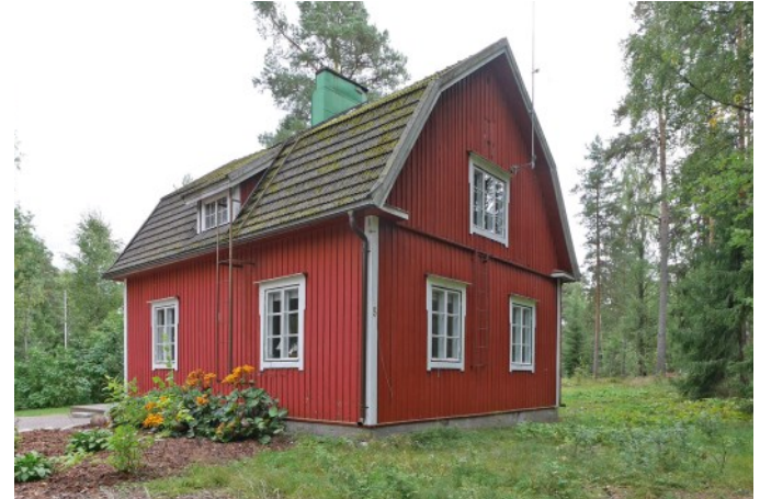
Oskarshamn (106). 1900-luvun alkupuolen taitekattoinen asuinrakennus, jonka ilme on jonkin verran muuttunut laajennusten myötä. Betonisokkelille perustettu asuinrakennus. Julkisivuissa on punainen vanhempi pystyrimavuoraus ja kitatut puuikkunat. Katteena on sementtitiili.
