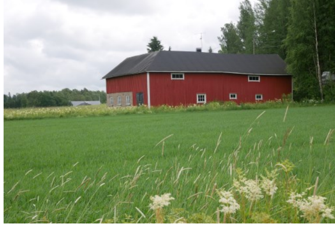
Norråkerin (12) 1900-luvun alussa rakennettu pientilan talousrakennus, jossa on yhdistetty navettasiipi ja talousrakennussiipi saman vesikaton alle.
