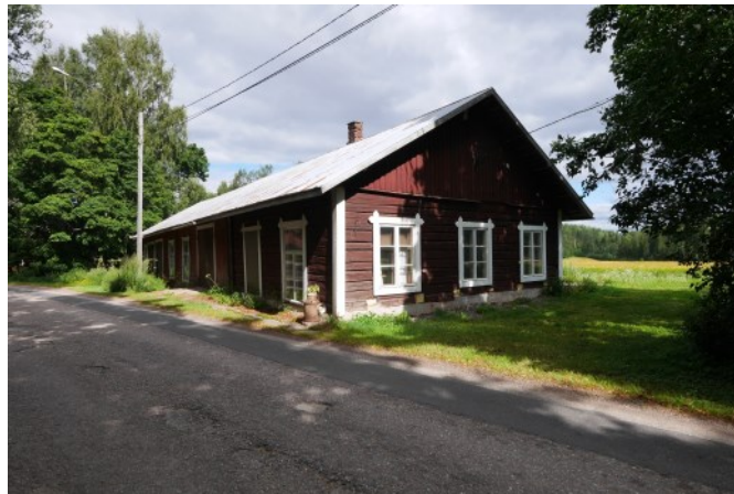
Snickarsin entisen tilakeskuksen alue levittäytyy kylätien molemmille puolille. Tilan monipuolisiin elinkeinoihin on kuulunut mm. saha. Tien varrella on säilynyt lamasalvottu, pitkänomainen talusrakennus, jossa on harvinaisen isot ikkunat. Ristikkäin liitetyt vuorilaudat olivat suosiossa 1800-luvun loppupuolen maatalusrakennuksissa. (A24)
