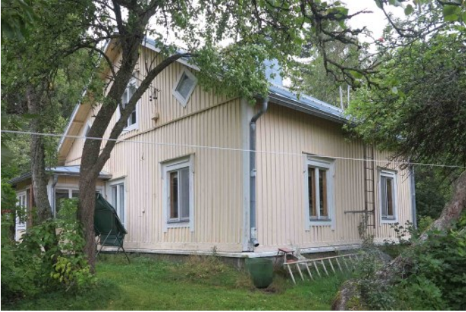
Flätbacka (131). Satulakattoinen, hirsirunkoinen, lohkokivisokkelille perustettu 1920-luvun satulakattoinen asuinrakennus. Vuonna 1952 runkosyvyttä lisäämällä tehty laajennus johon liittyy aumakattoinen sisäänkäyntikuisti, on rankarakenteinen. Nykyinen ulkoasu on 1950-luvulta.
