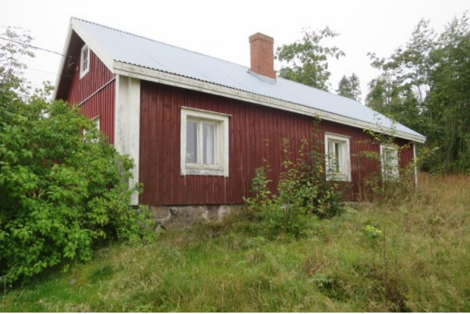
Sandkulla (132). Pihan pohjoisreunalla on luonnonkivisokkelille perustettu asuinrakennus. Mahdollisesti myöhemmin nykyiselle paikalle siirretty pitkänurkkainen hirsirakennus lienee 1800-luvulta. (A38)
