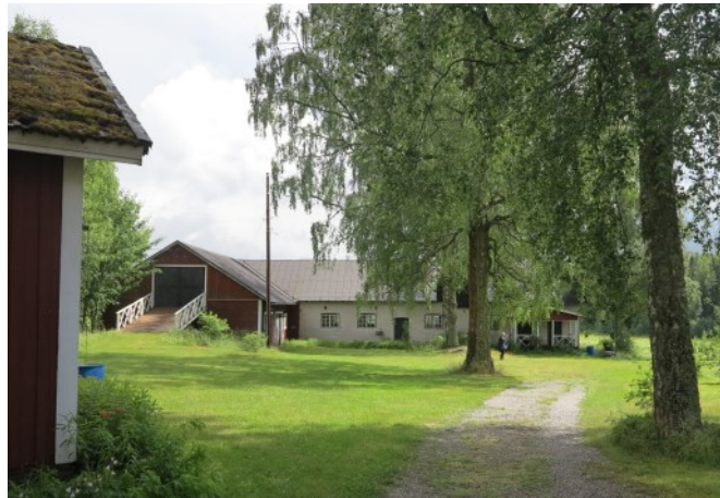
Lövgårdin (19) hirsi- ja tiilirakenteinen navetta, jonka päädyssä on ullakolle johtava ajosilta. (A21)
