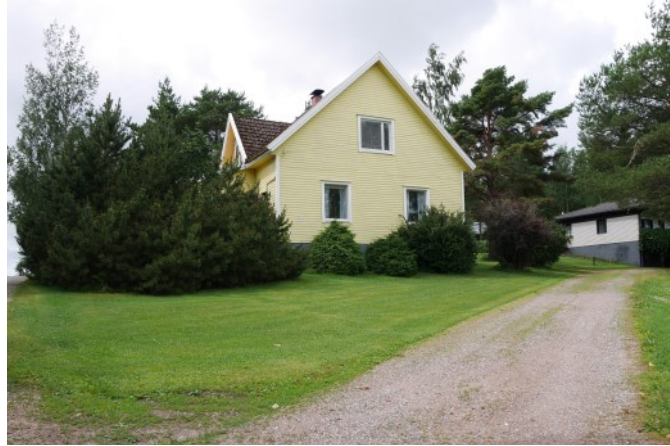
Knutsbergetin rinteeseen rakennettu Knutsbackan satulakattoinen päärakennus (11) 1900-luvun alusta. Rakennus on jonkin verran muuttunut.
