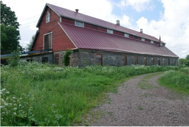
Snickarsin tilan (21) monumentaalinen navetta on rakennettu järeistä graniittiharkoista. Vesikatto on jaettu lanterniinosaan ja alempiin lappeisiin, eteläpäädyssä on ullakolle johtava ajosilta. (A24)
