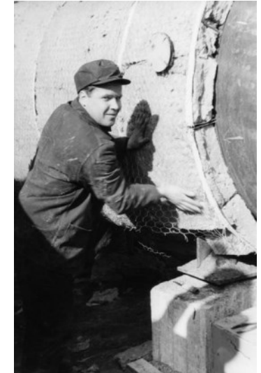
Työntekijä eristämässä öljysäiliötä Sköldvikin työmaalla 1965. Työväen arkisto. finna.fi
