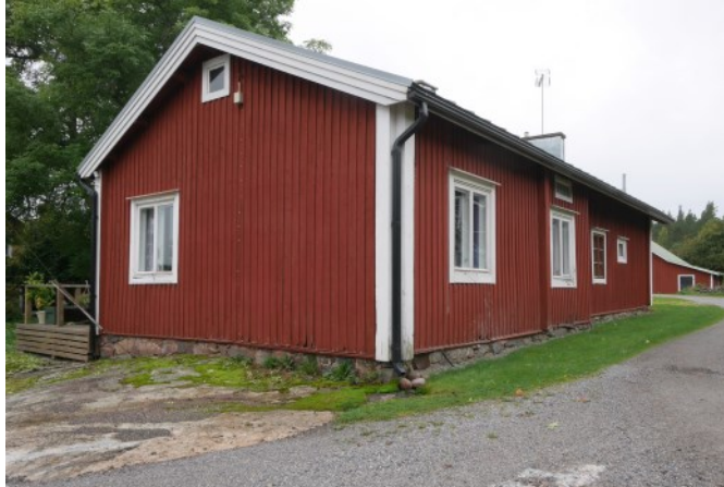
Bergkulla (142) sijaitsee Överkärras-nimisen kantatilan alkuperäisen tilakeskuksen paikalla. Pihan eteläreunassa on vanha, matalalle kiilakivisokkelille perustettu pitkänurkkainen asuinrakennus, jota myöhemmin on jatkettu ja muutettu. (A39)
