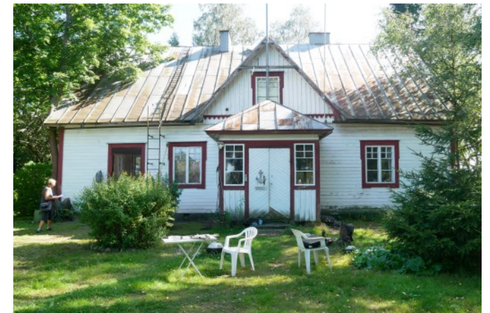
Isojaon uudistuksessa 1906 nykyiselle paikalleen siirretty kantatilan, Jobsin päärakennus (63), jonka ulkoasussa on jugendin huvila-arkkitehtuurin piirteitä: perinteistä jyrkempi vesikatto, ikkunallinen kuisti ja yläosaltaan pieniruutuiset ikkunat.
