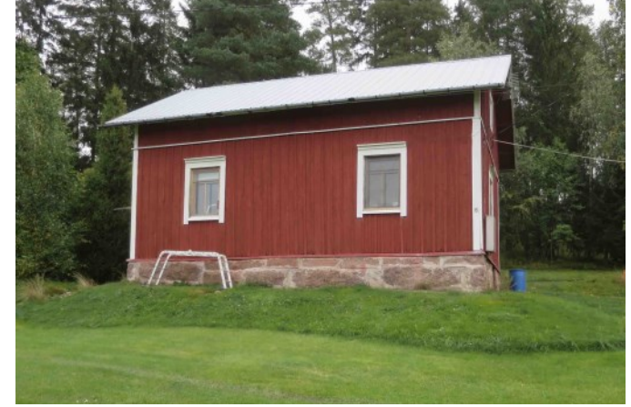
(Nordborg (139). Pienehkö satulakattoinen ilmeeltään 1900-luvun alkua edustava asuinrakennus. Julkisivuissa on punainen vanhempi epäsäännöllinen pystyrimavuoraus ja uusitut ikkunat. (A39)
