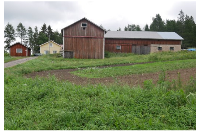
Malmgårdin (5) navetassa ja talousrakennuksessa on 1930-1950-luvulle tyypilliseen tapaan yhdistetty eri materiaaleja, sementtitiiltä ja puurakenteita.
