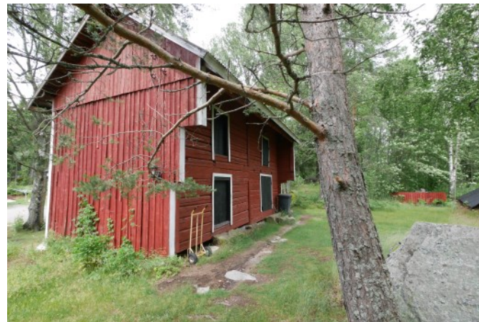
Knutsbackan (11) historiallisen kyläpaikan alueella on säilynyt sekä vanhempi lamasalvottu luhtiaitta että hirsirunkoinen lato. Luhtiaitan julkisivuja on myöhemmin vuorattu. Luhtikäytävä puuttuu.
