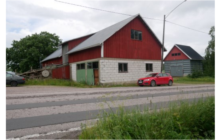
Piltarsin (8) todennäköisesti 1930-1950-luvulla rakennettu navetta, jonka ulkoseinissä on käytetty sementtitiiltä. (A22)
