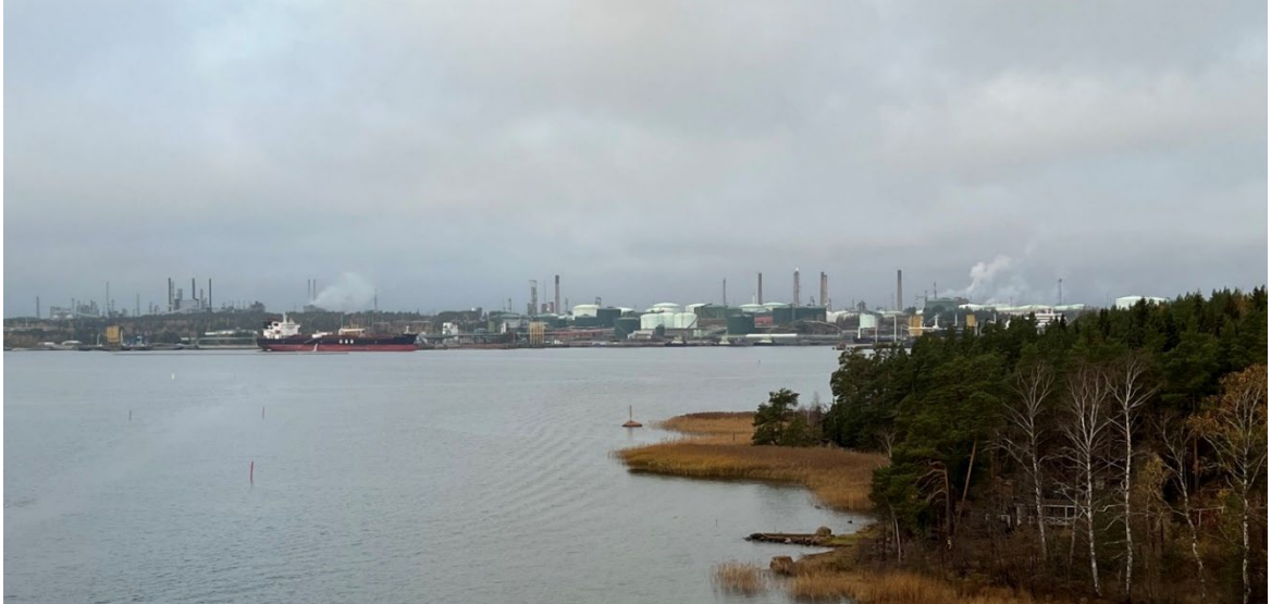
Kuva 24. Näkymä Emäsaloon johtavalta sillalta Kilpilahden suuntaan.
