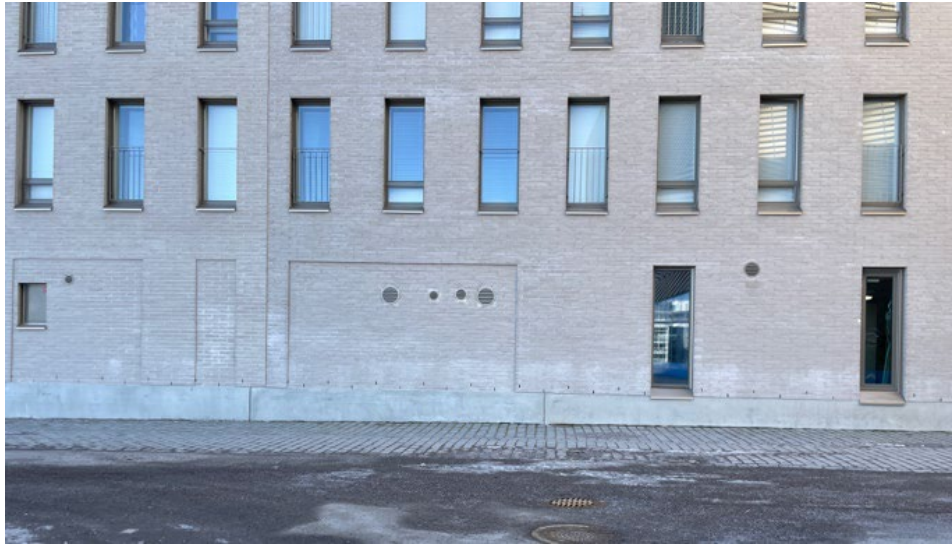
Kuva 26 Esimerkkikuvan syvennykset tiilimuurissa eivät ole riittävät eikä vastaavanlaisia ratkaisuja hyväksytty. Kuvassa 21 ja Kuvassa 23 on esitetty kivijalan arkkitehtoninen luonne.
