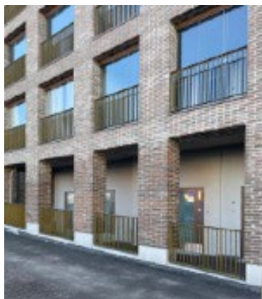
Kuva 40 Vasemmalla ja keskellä keveitä parvekekaiteita lasitetulla parvekkeella. Oikealla syvennetty ranskalainen parveke. (NEMO arkkitehdit Oy)
