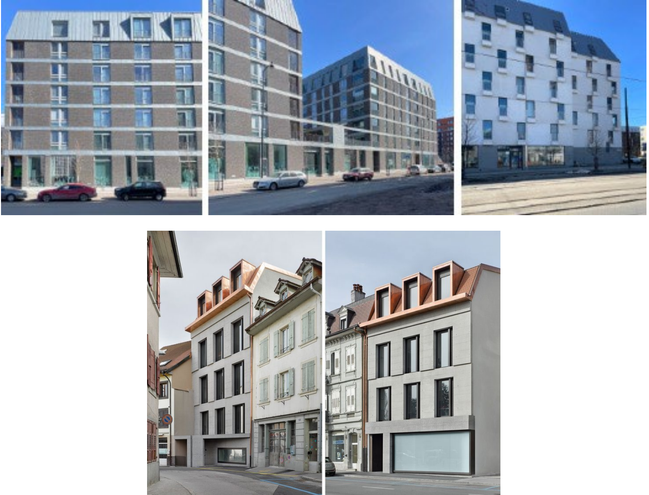
Kuva 36 Vaihtoehtoisia kattoikkunoita: vasemmalla kattolyhty ja lappeen leikkaava pystysuora ikkuna; keskellä lisäksi parvekkeellinen kattoikkuna; oikealla lappeen suuntainen kattoikkuna. Referenssikuvissakatto kattorakenne on erilainen kuin Porvoon puistokadun taloissa. (kuvat yllä: NEMO arkkitehdit Oy, kuvat alla: Boegli Kramp Arkitekter)
