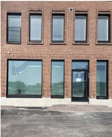
Kuva 25 Erilaiset muuraustavat elävöittävät julkisivupintaa. (NEMO arkkitehdit Oy)
